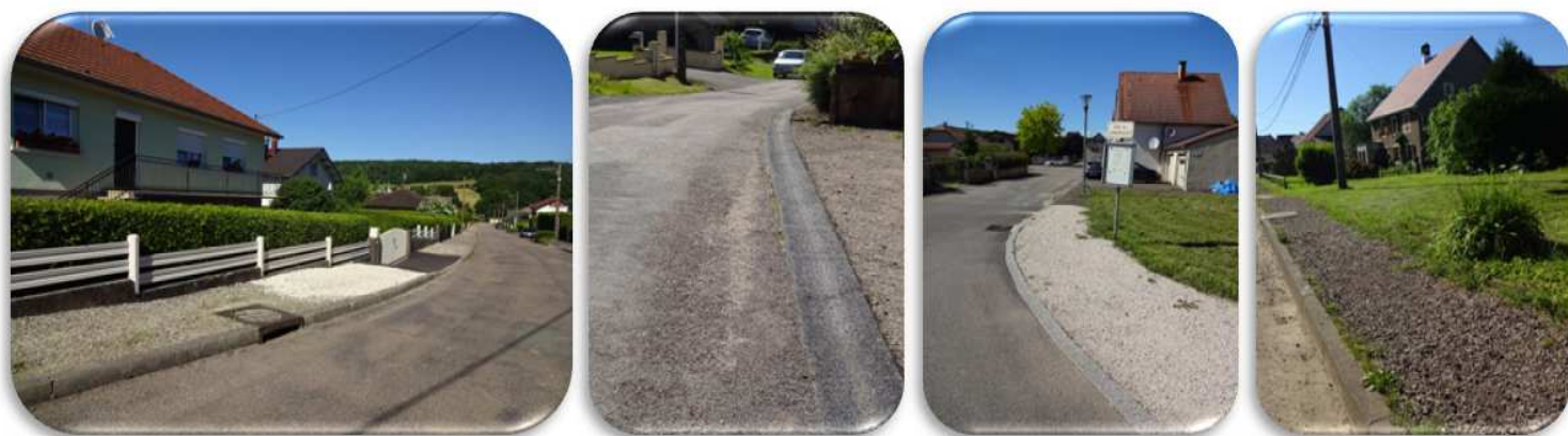
Exemples de voirie perméables d'Echenans-sous-Mont-Vaudois : différents revêtements
