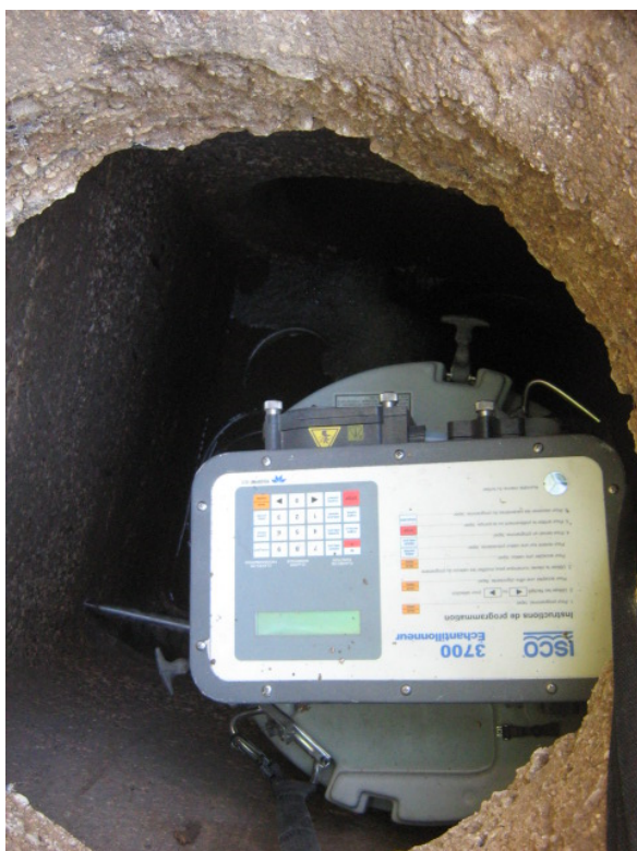
Pont n° 1 : amont bassin rue Droulier
