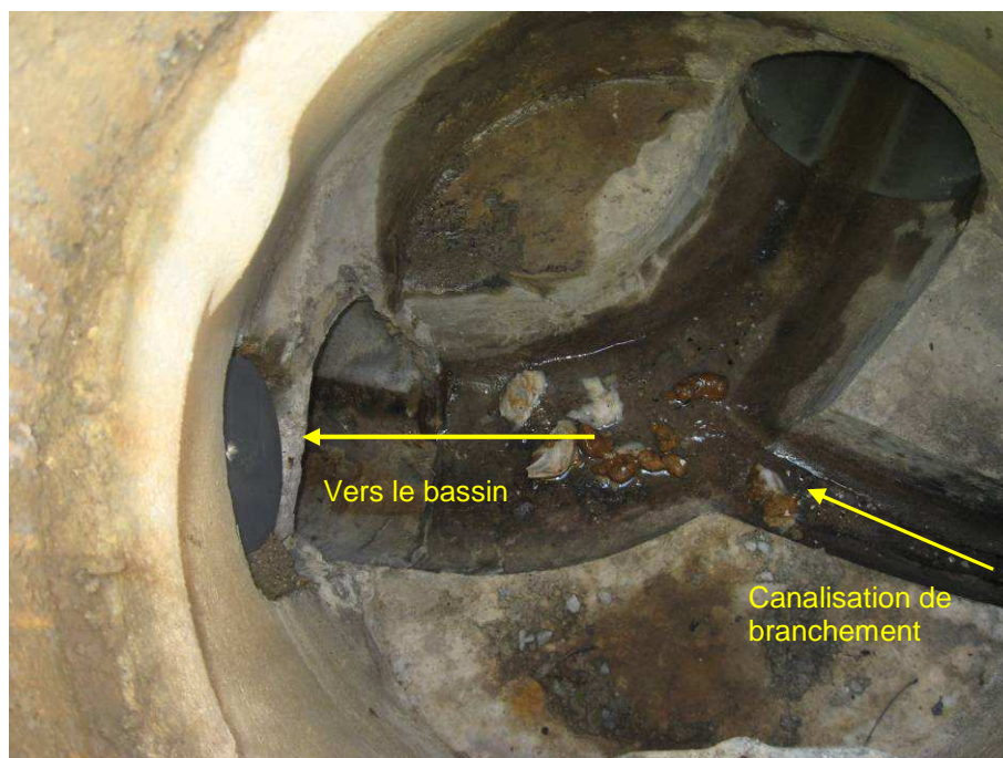
Figure n° 10 : Inversion de branchement EU sur EP
