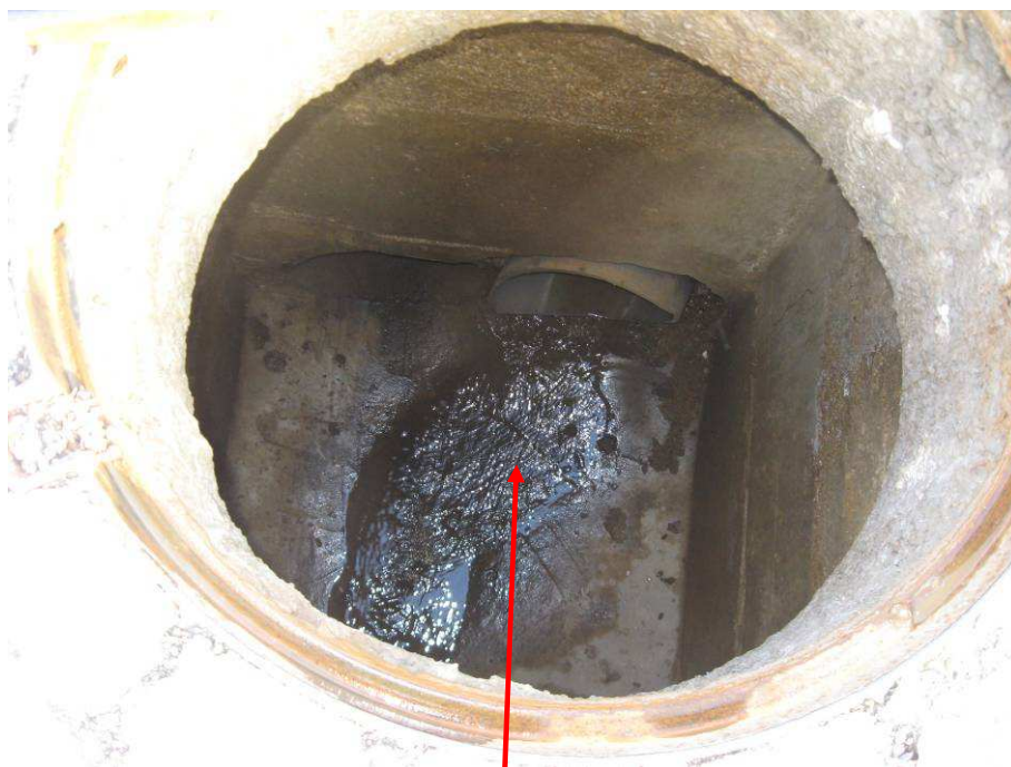
Figure n° 3 : Arrivé en Ø 500 et départ en Ø 600 à l'intersection avec la rue des Crayes
