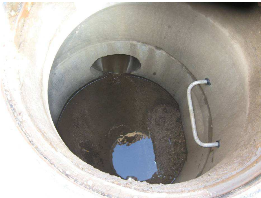
Figure n° 2 : Ø 400 EP rue des Hauts de Vorin en face du 1 Bis
