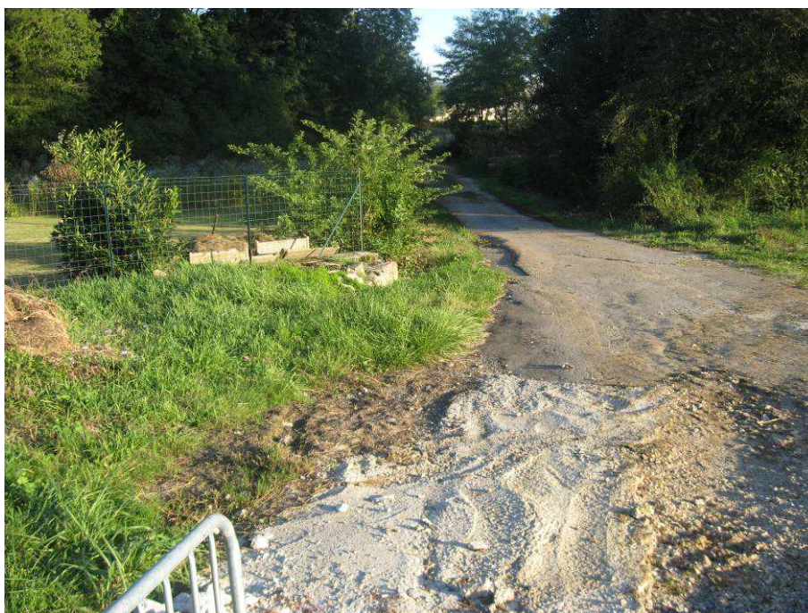
Figure n° 12 : Exutoire de la canalisation EP doublée, vue vers l'aval
