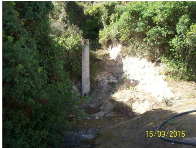
Environnement amont du puits de Longone
