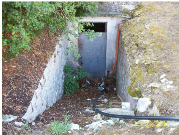
Entrée de l'abri abritant le puits de Longone
