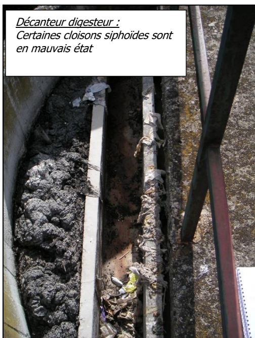
Figure 3 : Vues des problèmes de structures et d'équipements de la STEP
