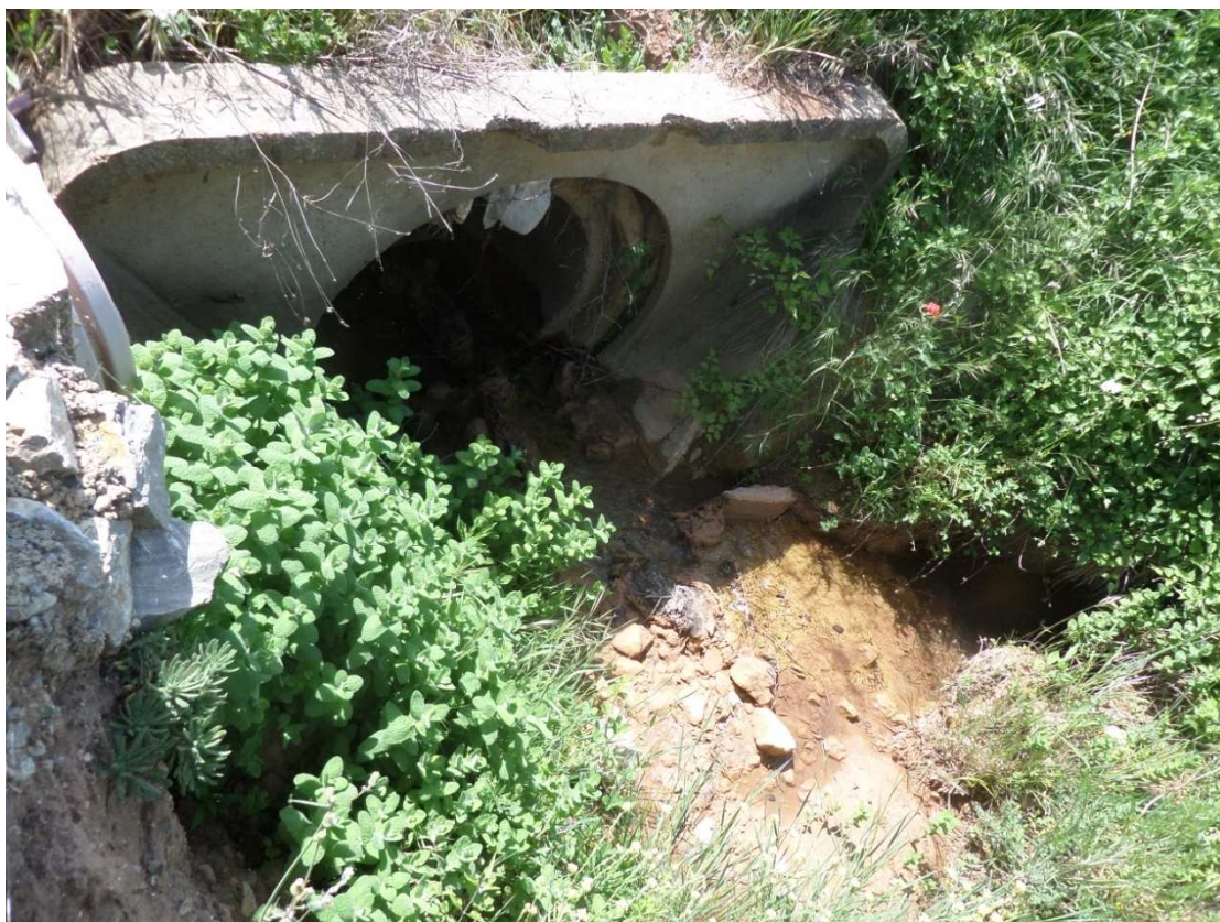
P69 : Buse béton DN1000
