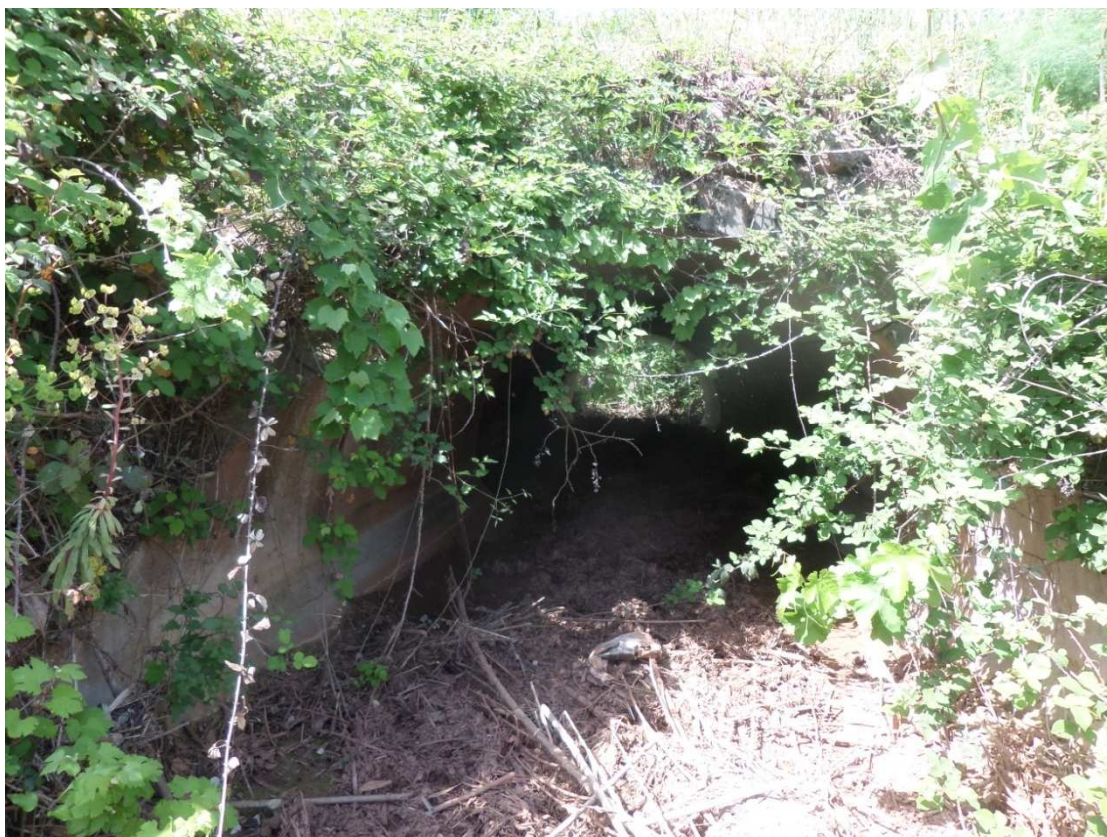
P67 : Voute / hauteur : 1,6m / largeur 2,5m
