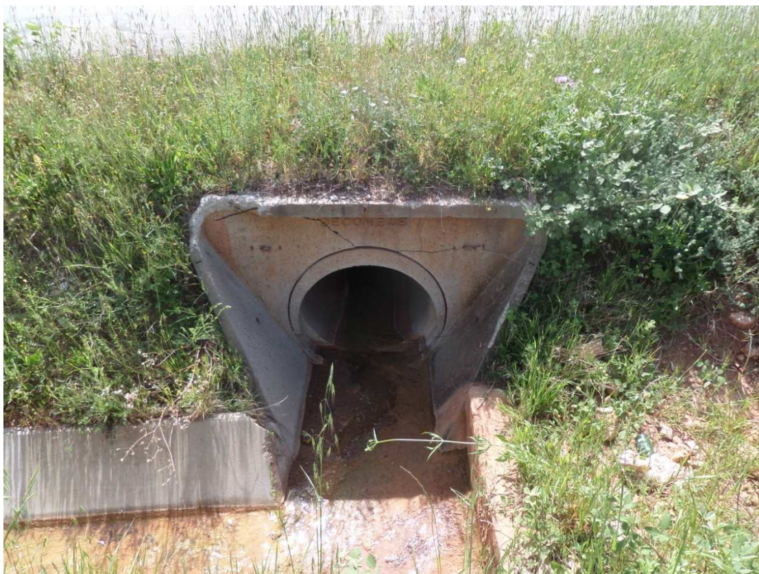
P65 : Buse béton DN800
