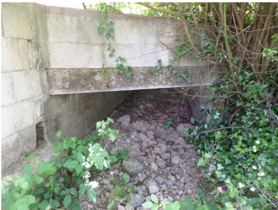
P14 : Cadre / hauteur : 0,8m / largeur : 1,4m
