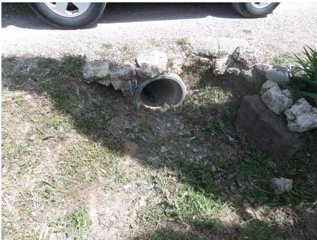
P77 : Buse béton DN400
