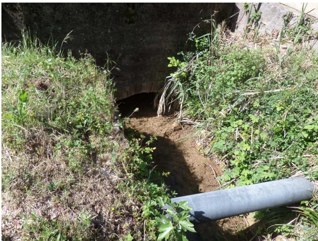
P6 : voute / hauteur : 0,6m / largeur : 1,7m (bouchée)
