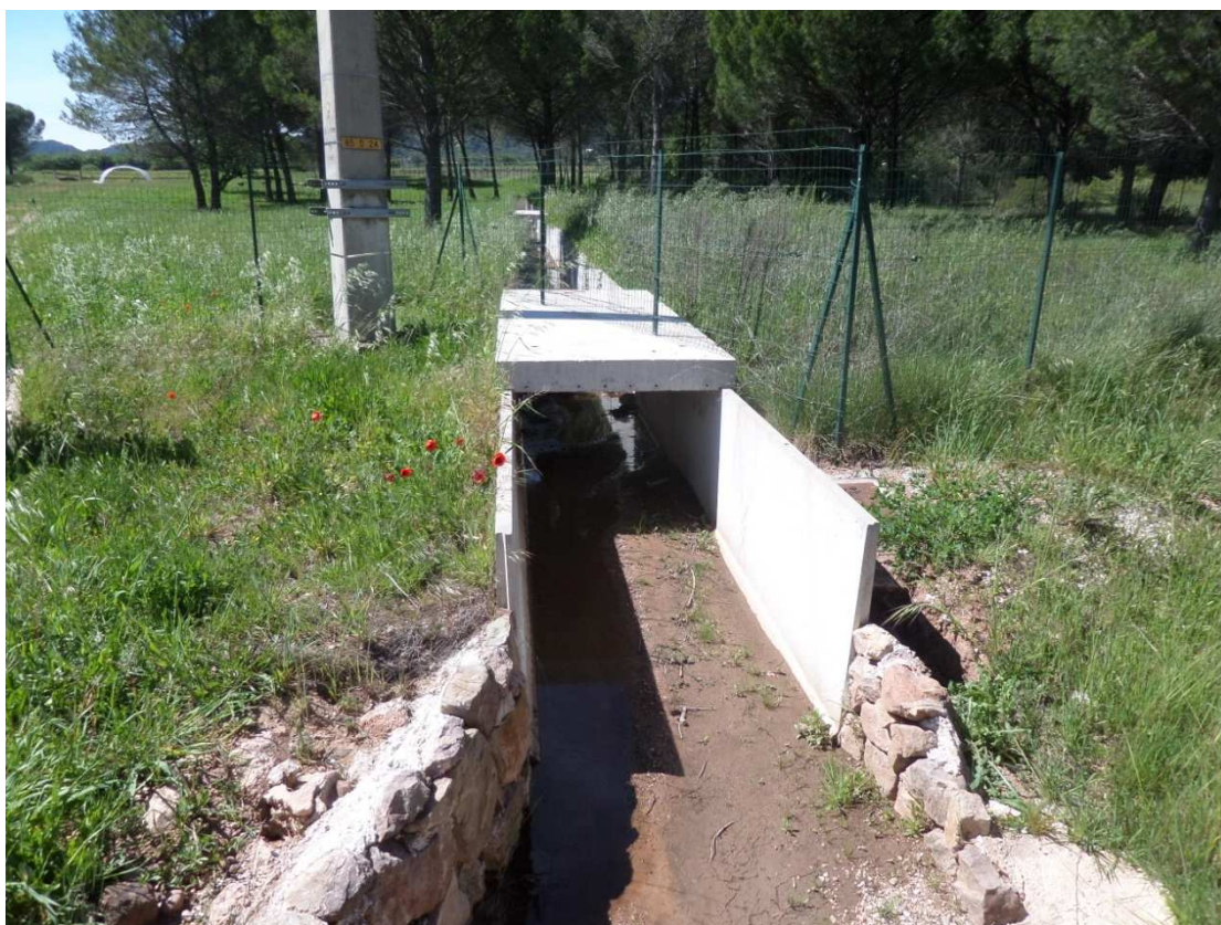
P28 : Cadre / hauteur : 1m / largeur : 1,35m
