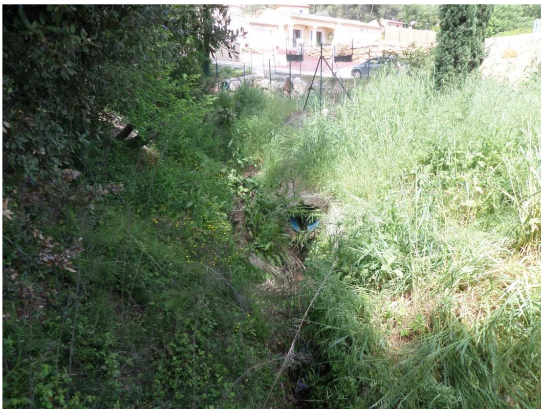
P20 : Sortie bassin d'orage
