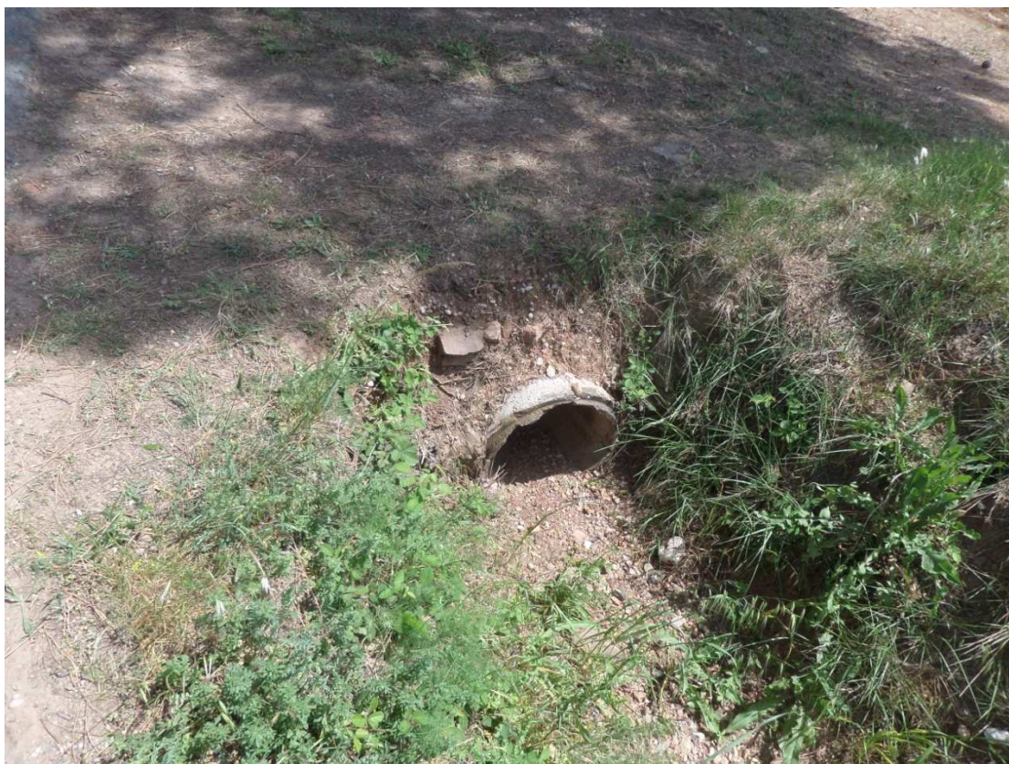
P73 :Buse béton DN500
