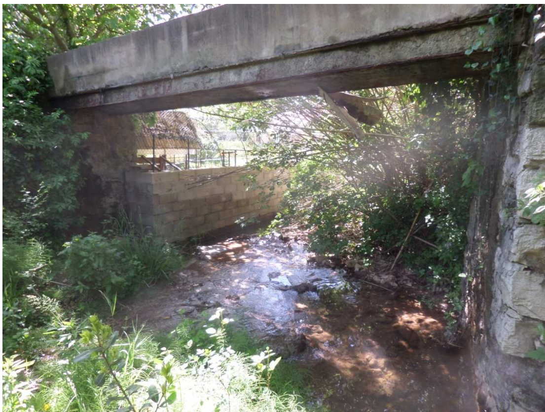
P7 : cadre / hauteur : 2,5m / largeur : 5,5m
