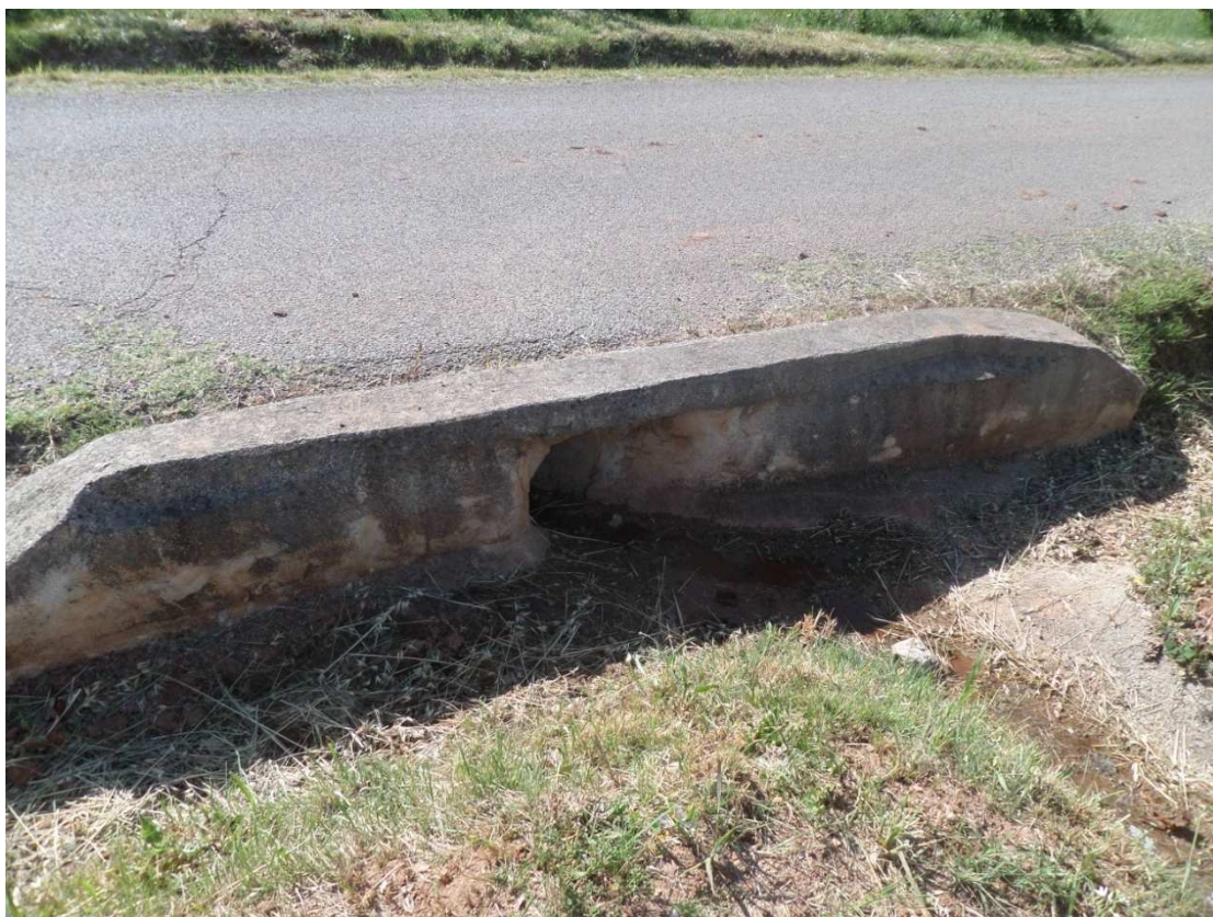
P49 : Buse béton DN400
