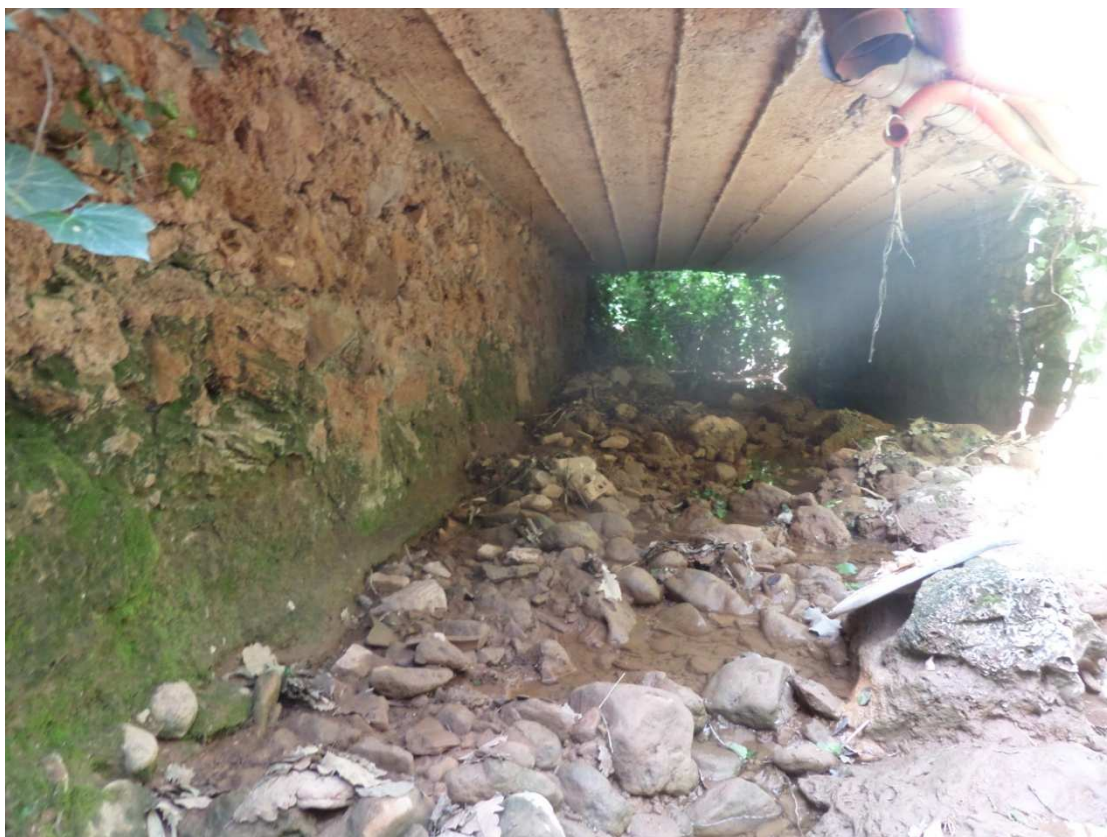
P5 : cadre / hauteur : 1m / largeur : 2,3m
