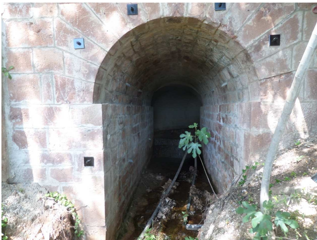
P70 : Voute / hauteur : 3,3m / largeur : 1,8m
