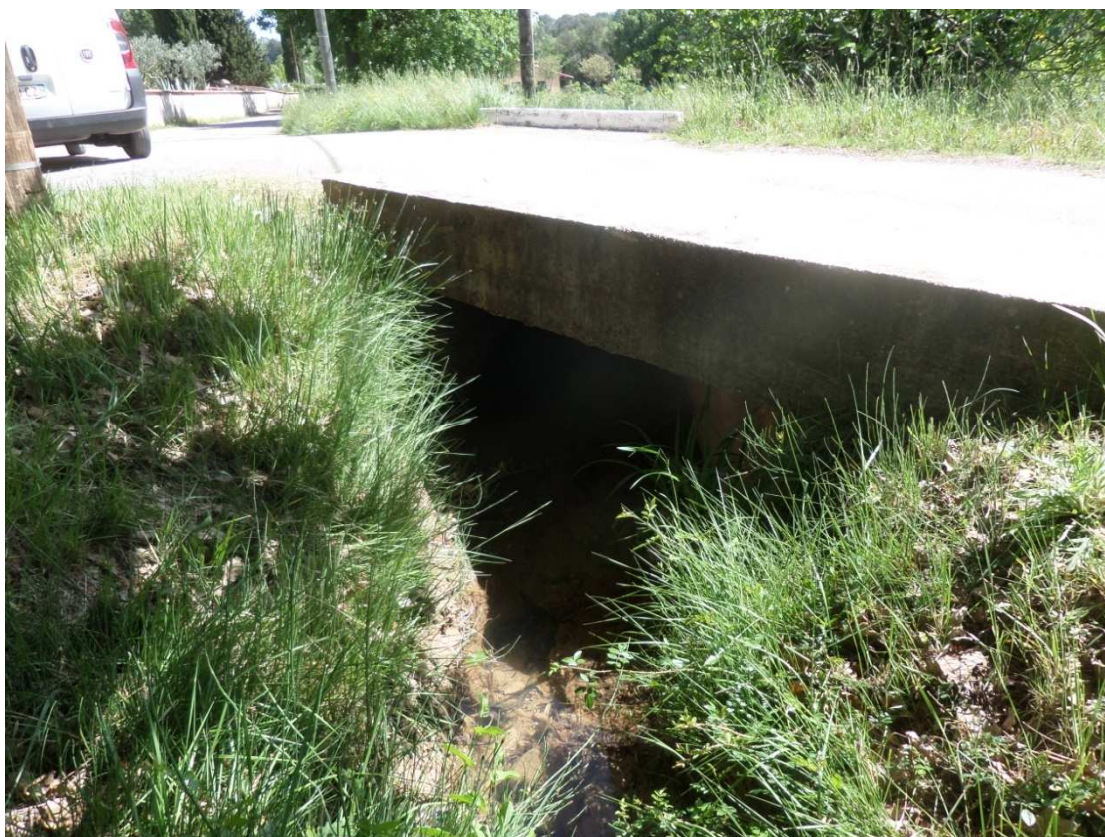
P24 : Cadre / hauteur : 1m / largeur : 1m
