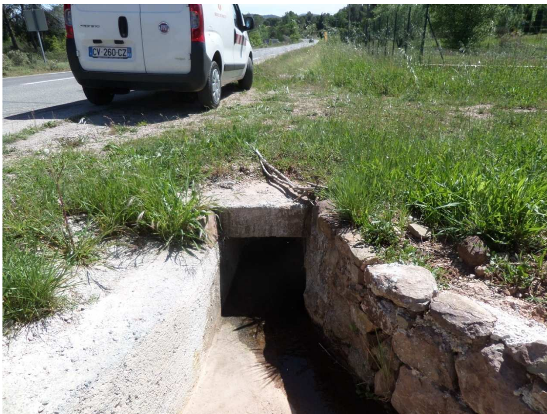
P29 : Cadre / hauteur 0,4m / largeur : 0,5m
