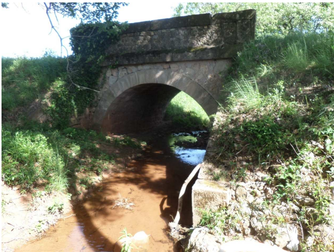
P45 : Voute / hauteur : 1,9m / largeur : 3,45m
