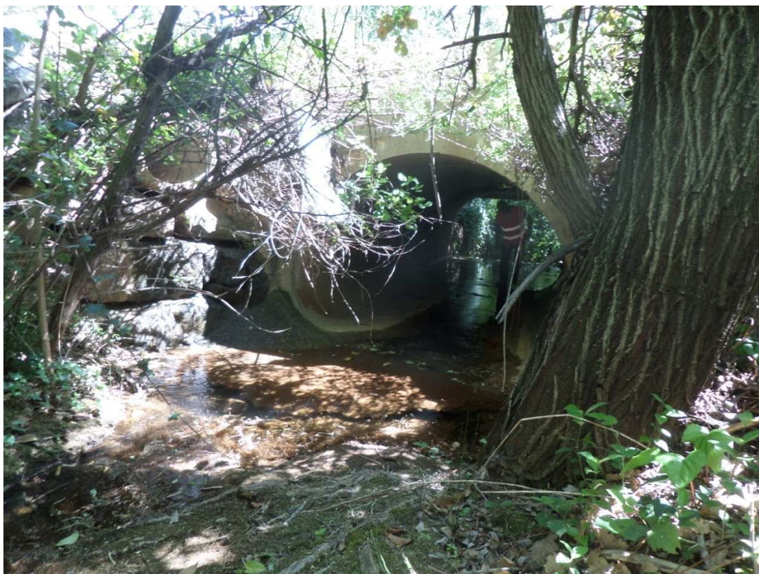
P25 : Voute / hauteur : 1,8m / largeur : 3m
