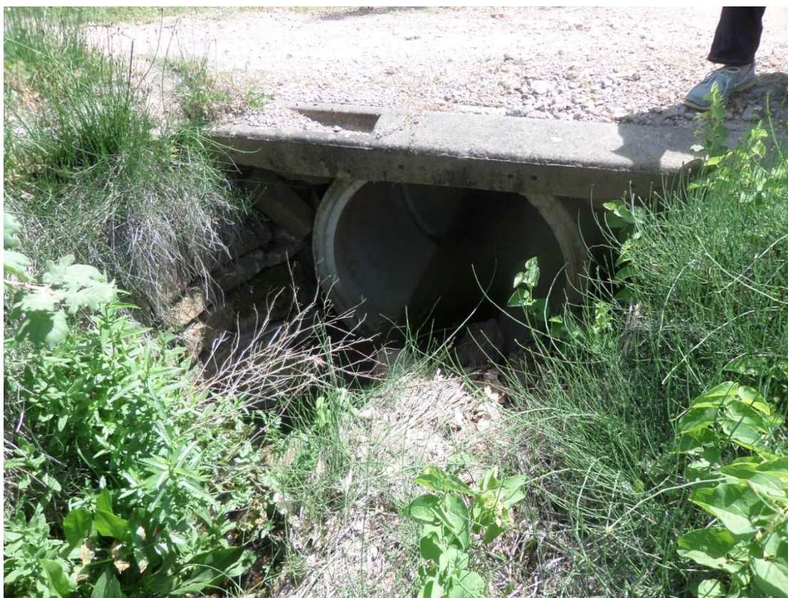
P78 : buse béton DN1000
