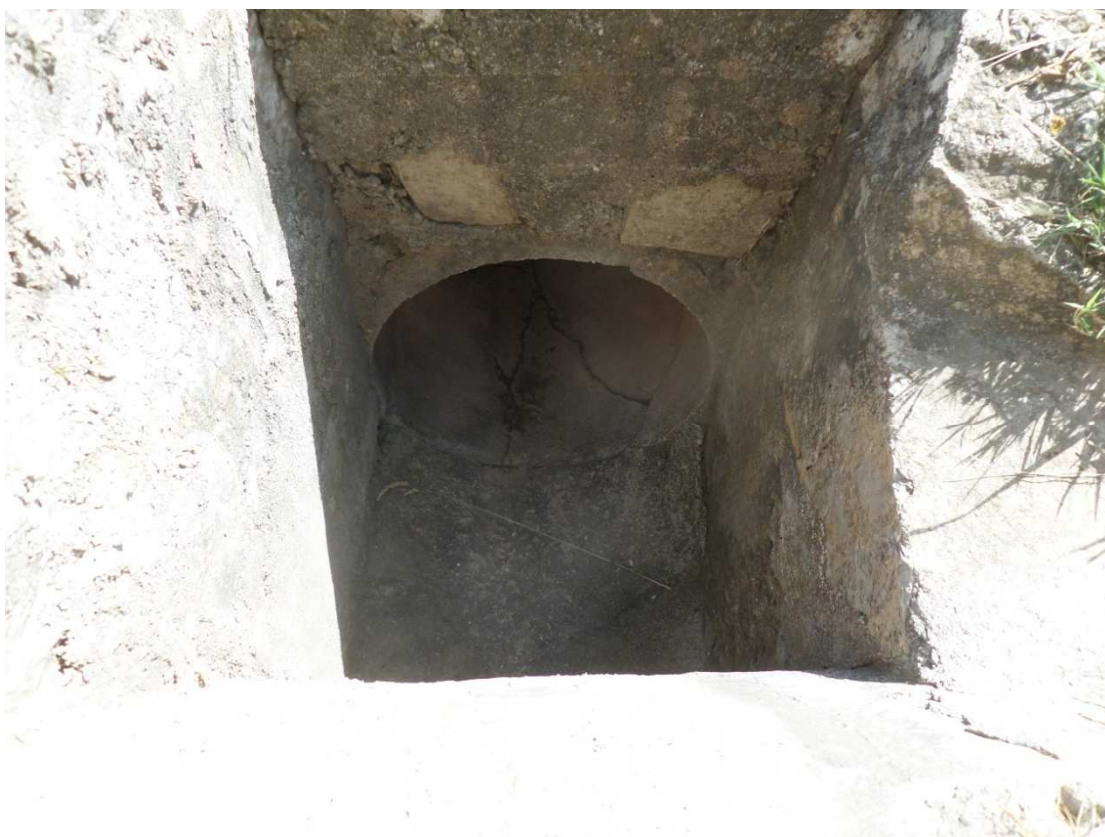
P38 : buse béton DN 500
