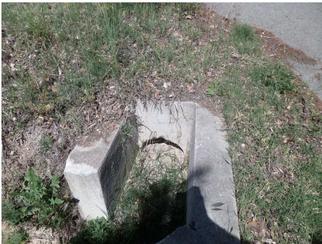
P91 : Buse béton DN 400
