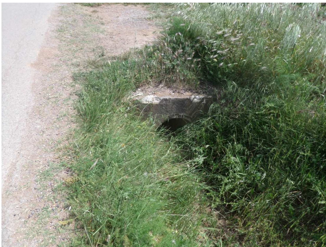
P72 : Buse béton DN400
