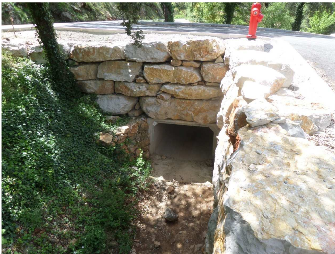
P15 : cadre / hauteur : 1m / largeur : 1,5m
