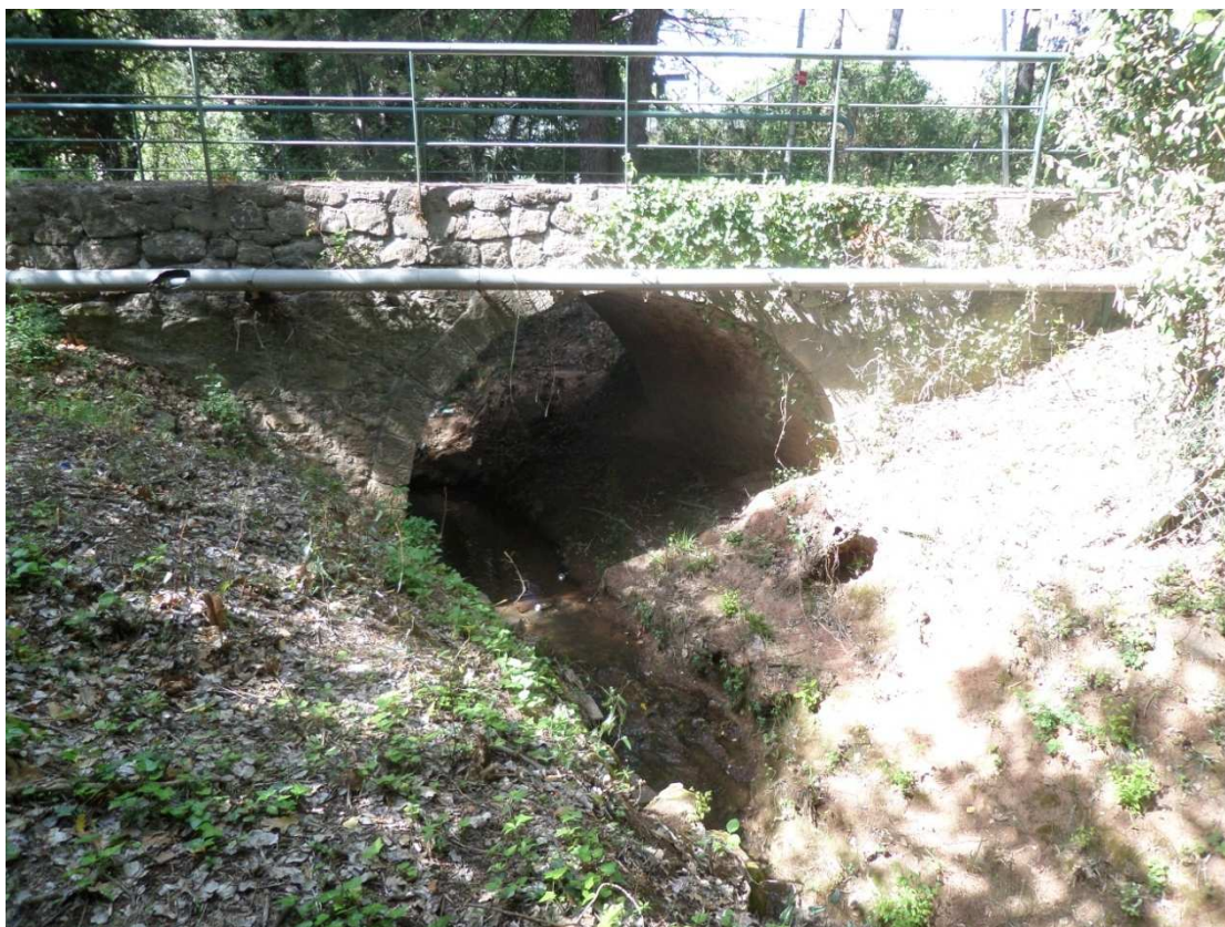
P41 : Voute / hauteur : 2,5m / largeur : 3,7m)
