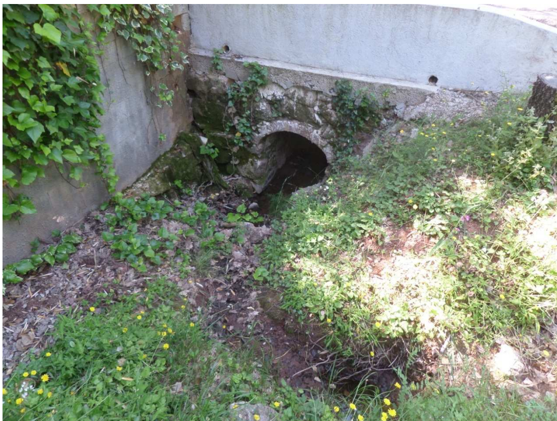
P57 : Voute / hauteur 1,15m / largeur : 1m
