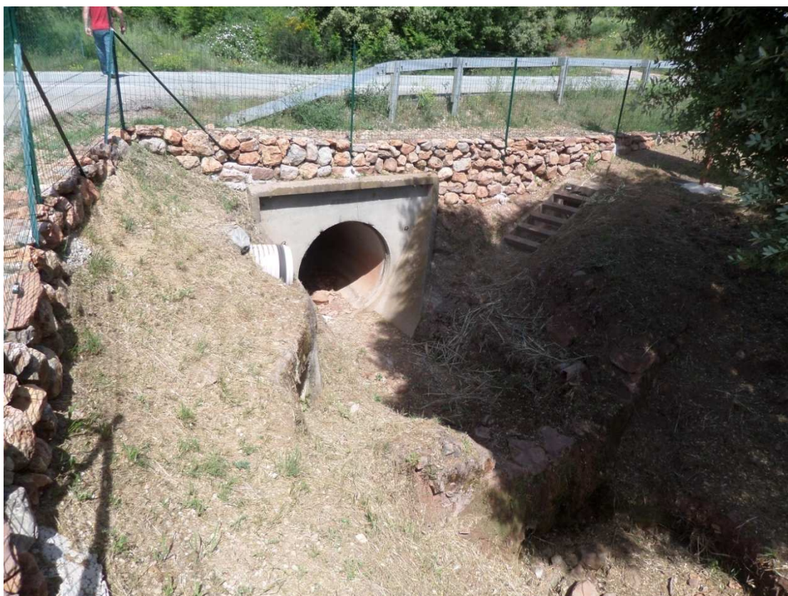
P68 : Amont (cadre / hauteur 1,17m / largeur : 1,30m) ; Aval (Buse DN1500)
