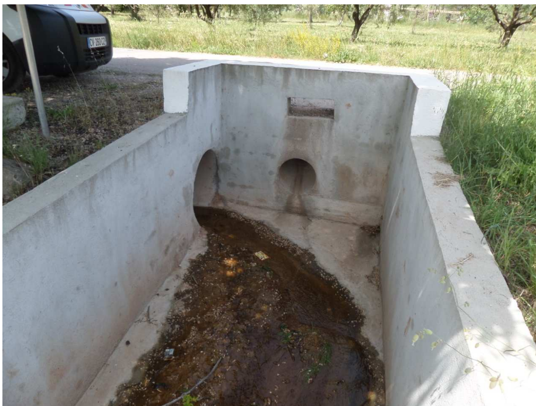
P76 : buse béton DN400
