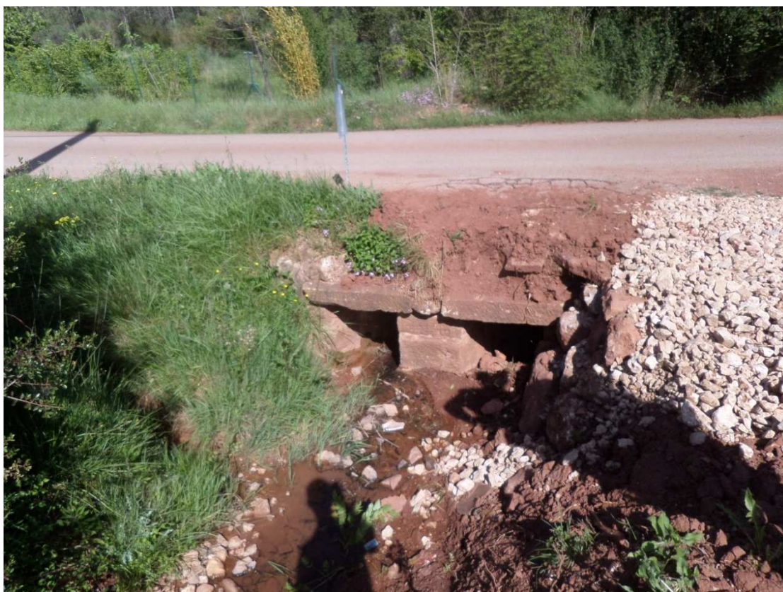
P46 : 2 Cadres / hauteur 0,6m / largeur : 0,7m
