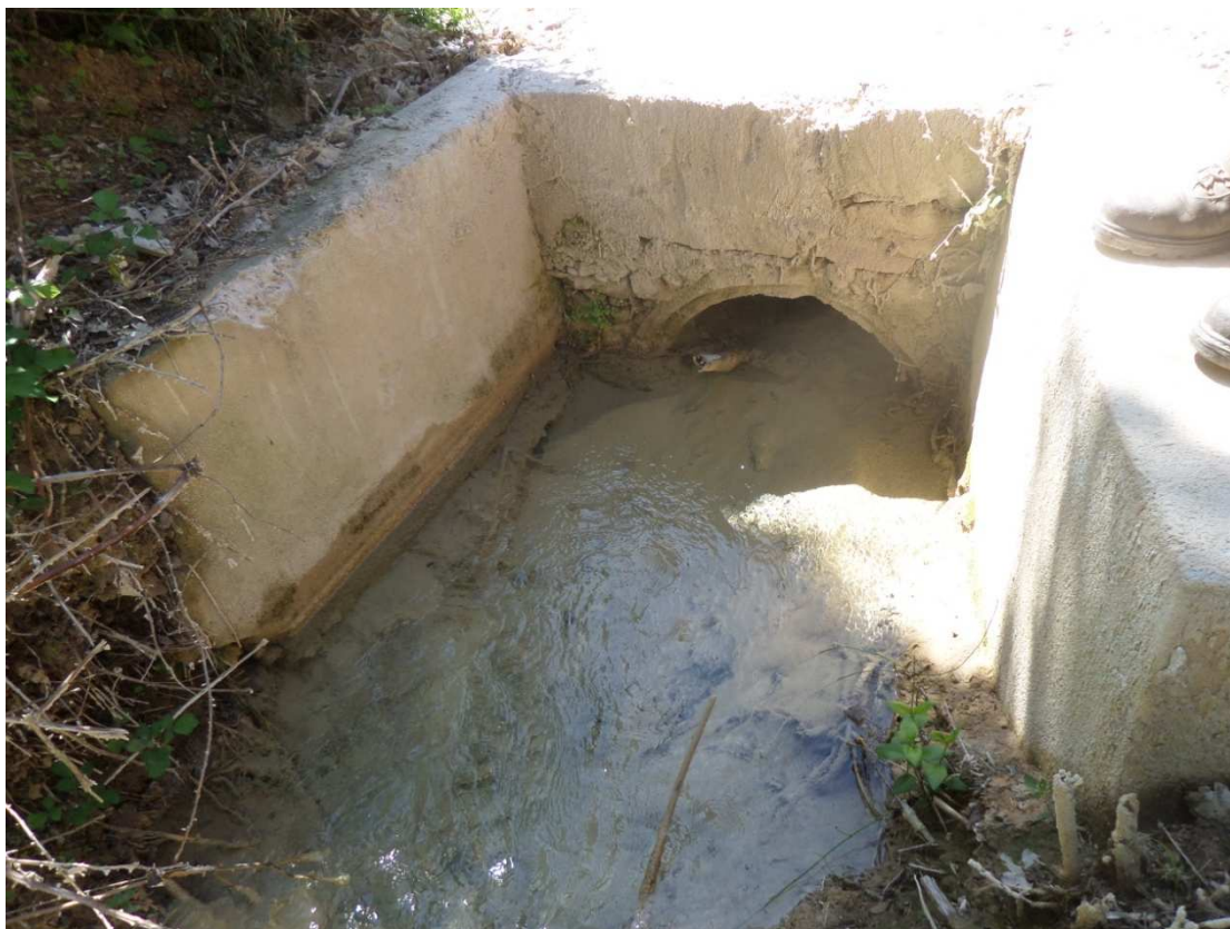
P10 : Buse béton DN 800
