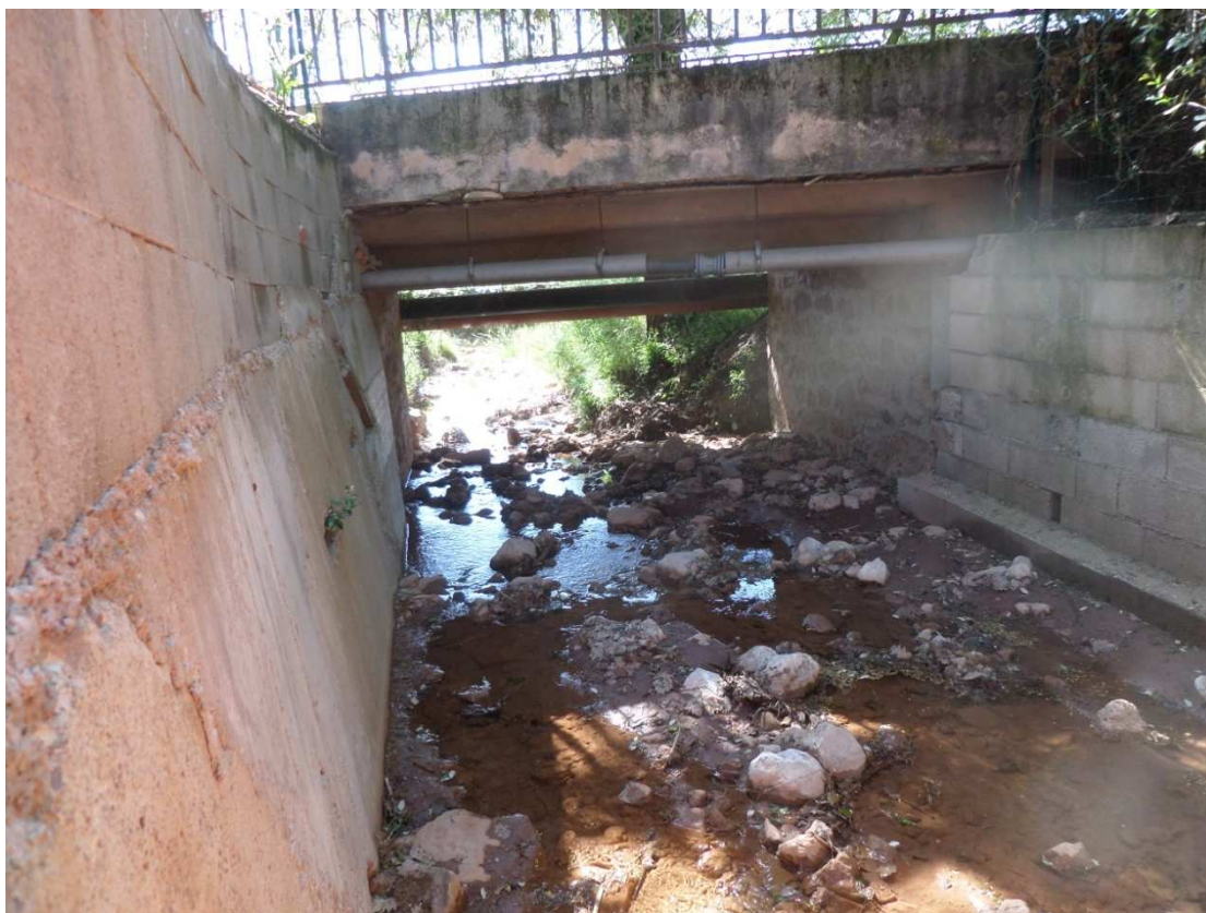
P3 : cadre / hauteur : 1,5m / largeur : 3,4m
