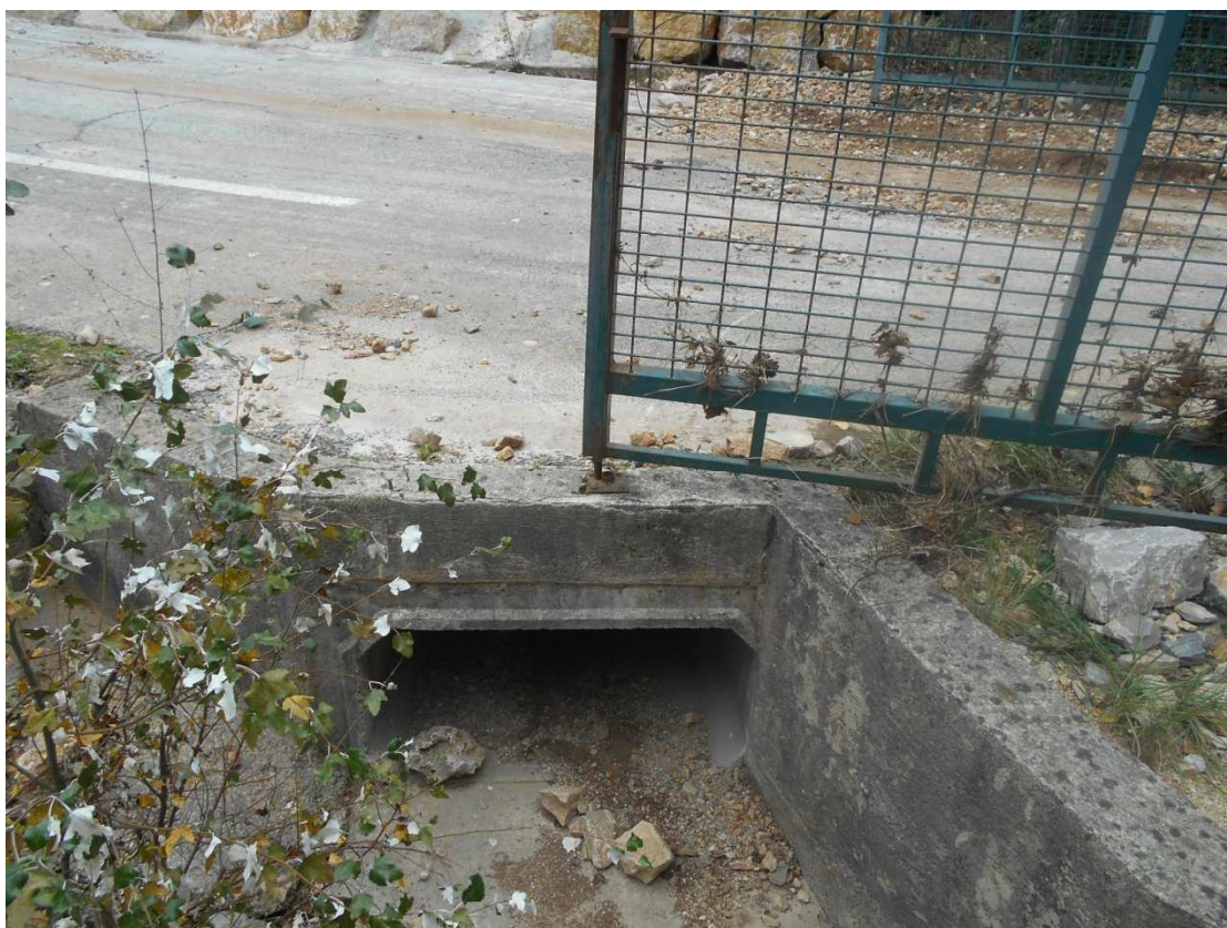
P94 : Cadre / hauteur : 0,55m / largeur : 1,1m
