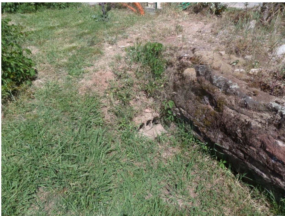
P82 : amont (buse DN400) ; aval (ourdi)
