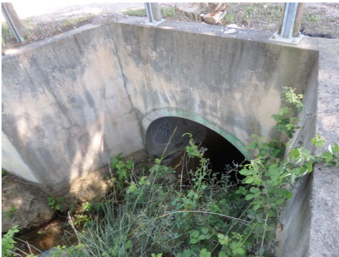
P31 : voute / hauteur : 1,6m / largeur : 2m
