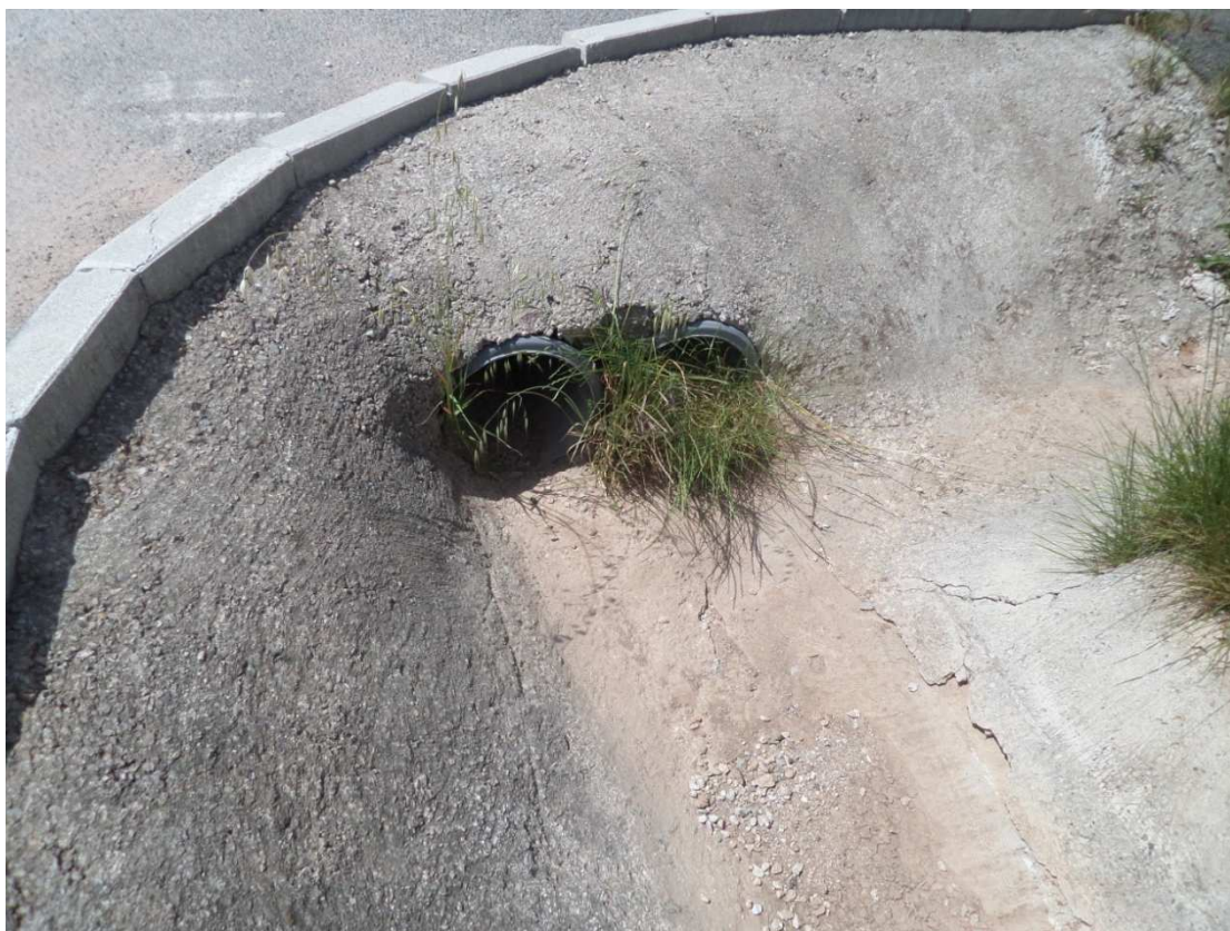
P79 : Amont (2 busesDN400) ; aval (buse DN1000)
