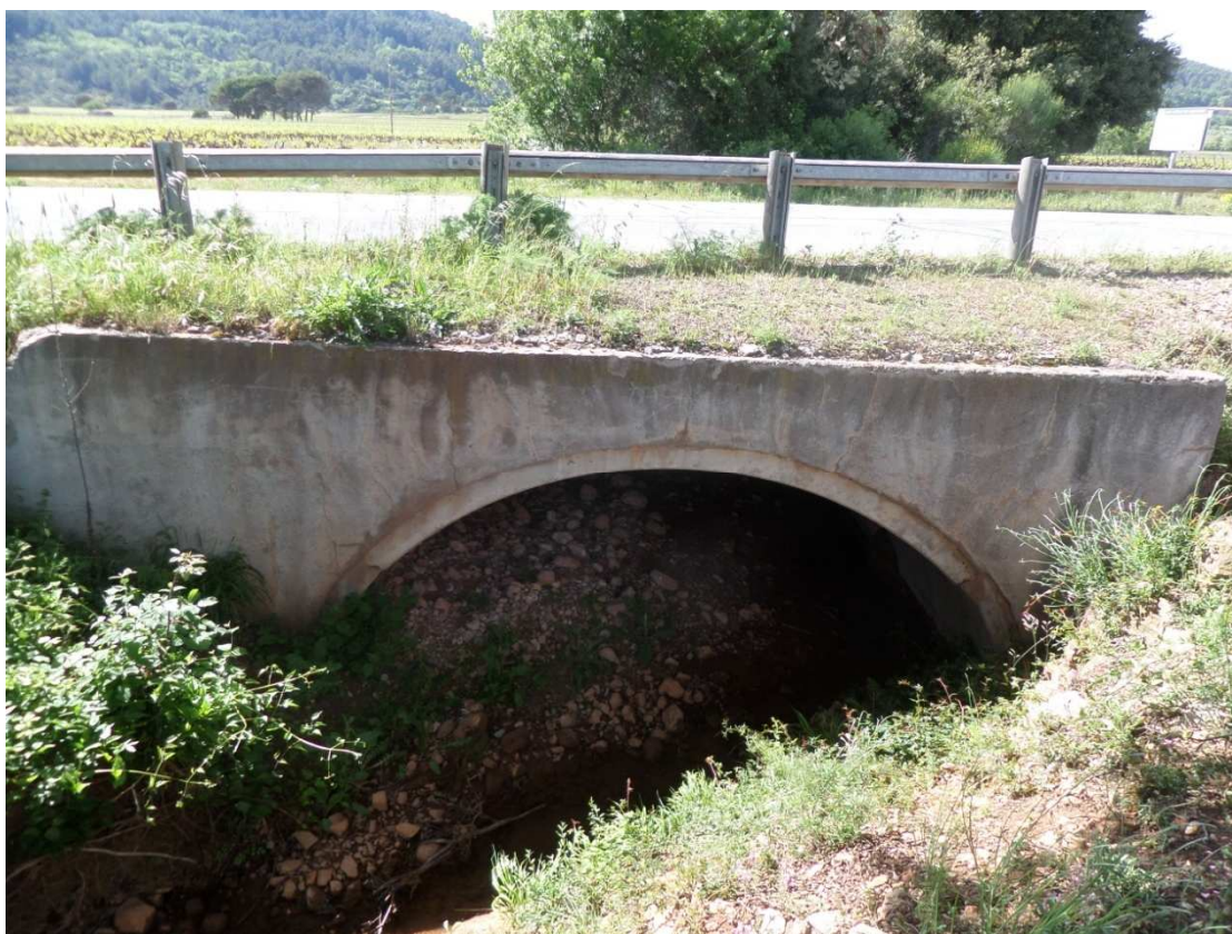
P44 : Voute / hauteur : 1,4m / largeur : 3,8m
