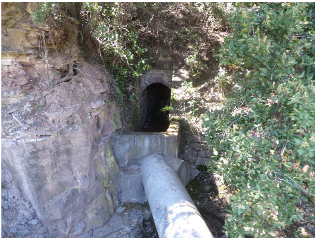
P33 : Voute / hauteur : 1m / largeur : 1,5m
