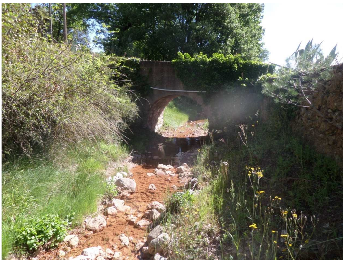
P4 : voute / hauteur : 2,2m / largeur : 3m
