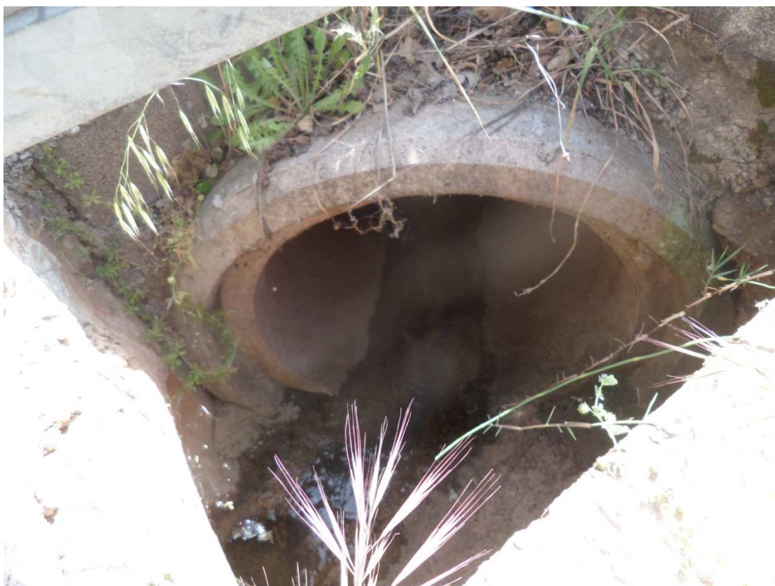
P66 : Buse béton DN800
