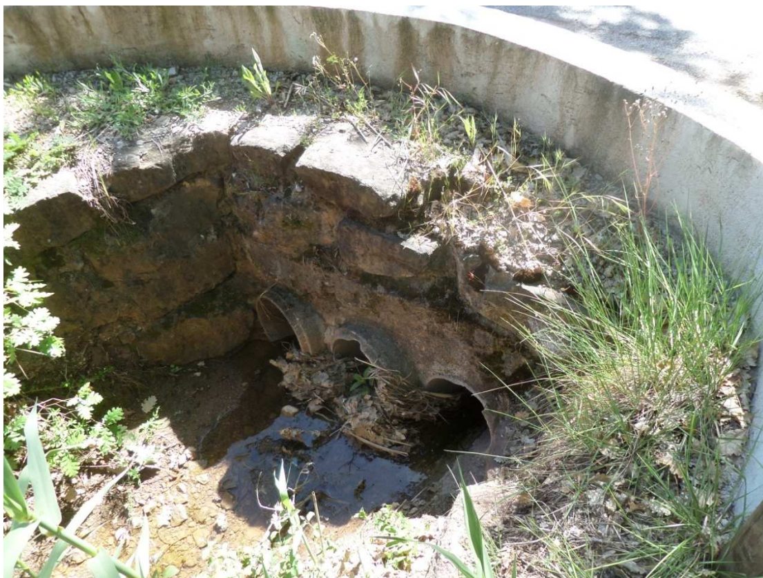
P37 : 3 buses béton DN 400
