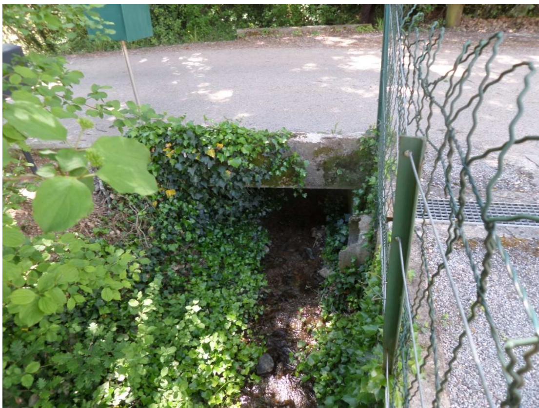
P13 : cadre / hauteur : 0,8m / largeur 1,5m
