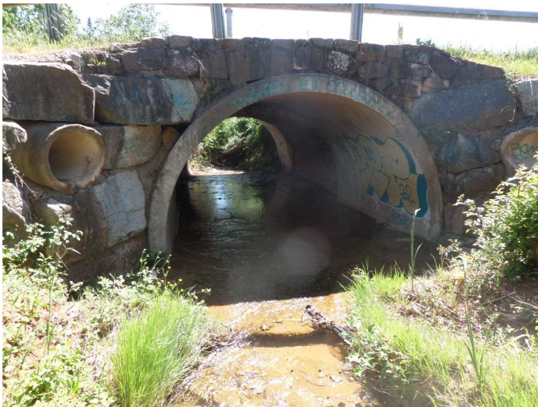
P26 : Voute / hauteur : 2,2m / largeur : 3,7m
