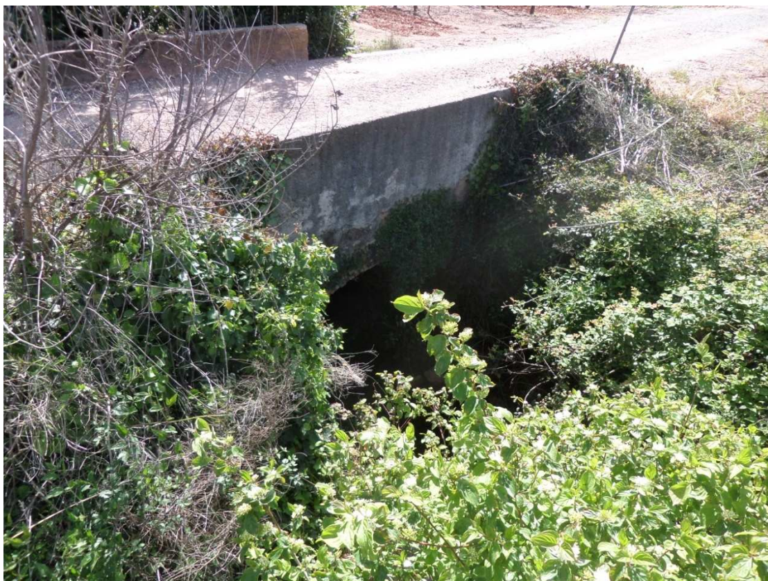
P43 : Voute / hauteur : 1,7m / largeur : 1,7m
