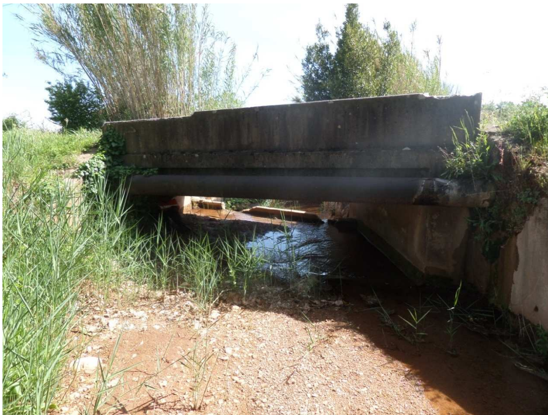
P42 : Cadre / hauteur : 1m / largeur : 3,65
