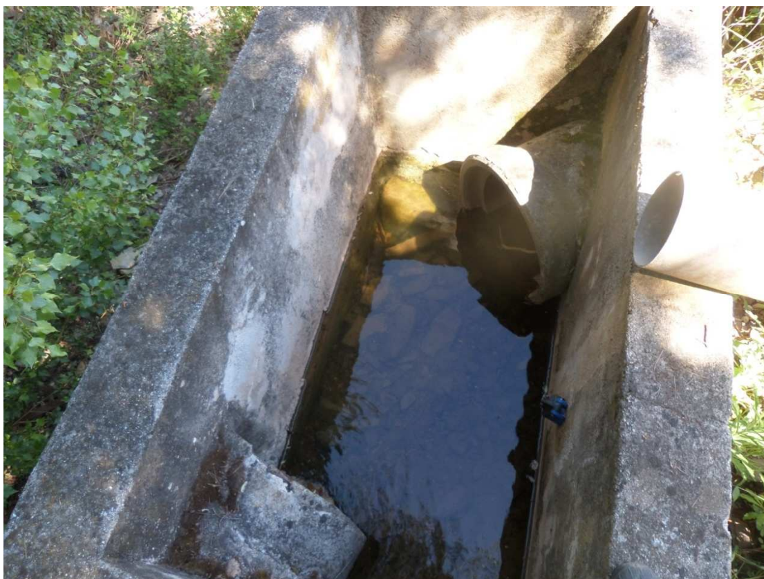
P34 : Buse béton DN 500
