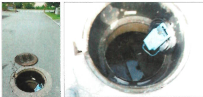
Figure 4 : Point de mesure site 3
