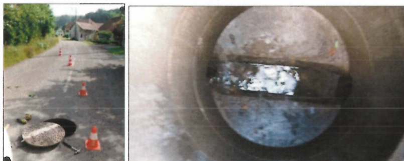
Figure 2 : Point de mesure site 1
