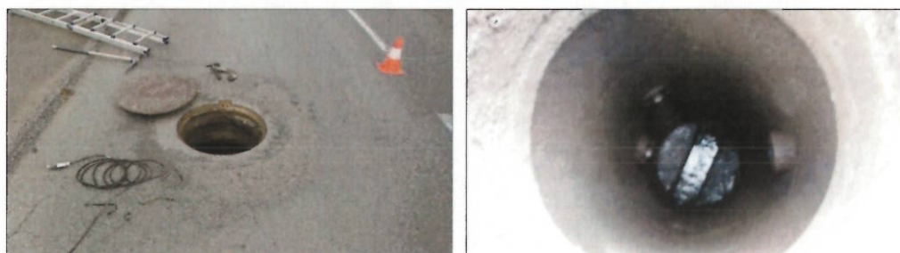
Figure 3 : Point de mesure site 2
