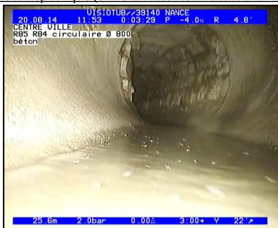
Dalot Rue de la République (entre la Place Henri Lissac à la rue du Casino)
