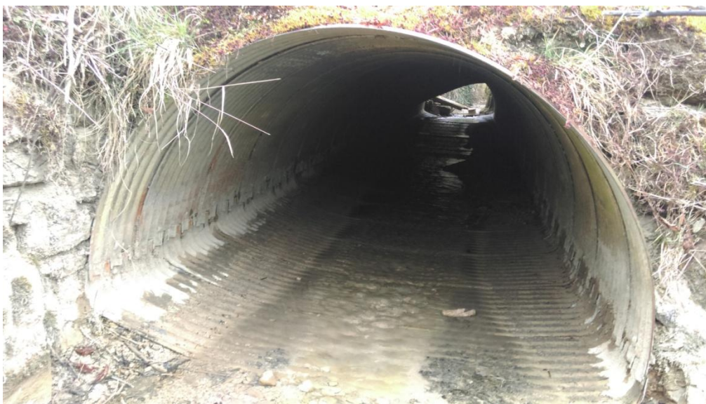
Photo 4 : Tronçon busé aval
