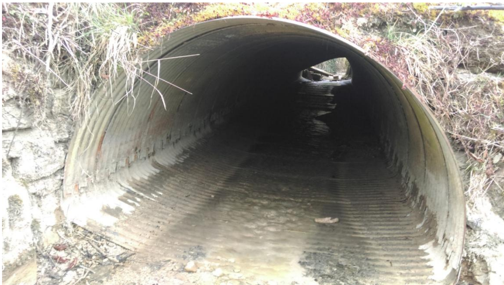
Photo 4 : Tronçon busé aval
