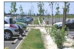
↑ La conception des parkings doit se faire en privilégiant le minimum de ruptures de revêtement pour ne pas favoriser la présence de plantes spontanées. La présence de bordures crée des recoins où la matière organique et les graines de « mauvaises herbes » s'accumulent et germent. Ainsi, il est préférable d'araser les surfaces afin de favoriser l'écoulement des eaux pour limiter l'accumulation de particules et de graines. Ici, les écoulements se font vers la noue centrale.
