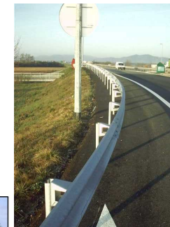
← Enrobé sous la glissière pour limiter le désherbage ou la fauche.
