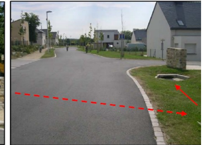
↑ Une rue centrale sans trottoir ni caniveau. Les eaux pluviales sont gérées par la zone enherbée et les joints limités.
