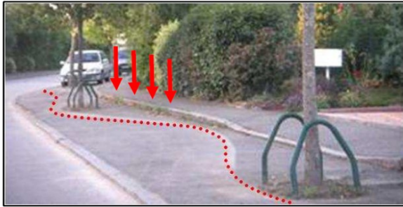
↑ L'emplacement des arbres dans les zones de stationnement ne permet pas d'accéder à la bordure du trottoir avec une balayeuse automotrice.
