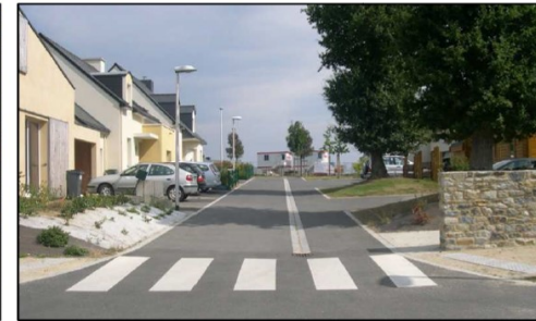
↑ Une ruelle d'un lotissement avec un caniveau central sans trottoir ni bordure.
