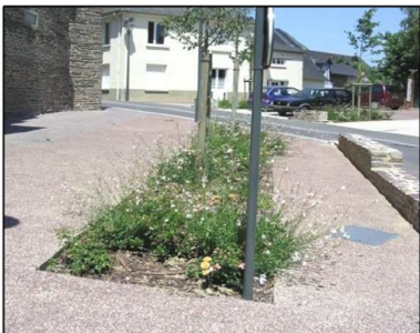
← Un massif encaissé dans le revêtement. Le paillage organique reste en place et le massif collecte toutes les eaux de ruissellement.
