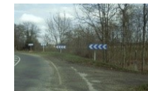
↓ Merlon en remplacement de la glissière.
