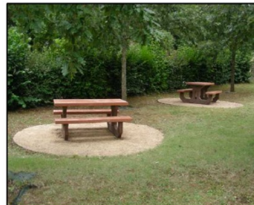
↑ Un revêtement coulé sous les tables limite l'entretien (plus de passage de rotofil).
