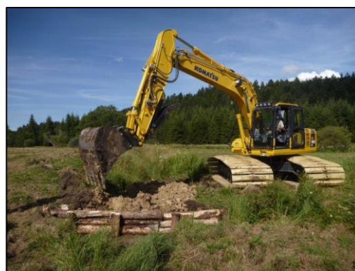
Figure 30: Illustration de protection de jonction ancien lit / nouveau lit. A gauche mise en place de rondins d'épicéa, à droite mise en place d'un substrat argilo-marneux et de terre végétale attenant aux rondins préalablement disposés (cliché Pierre Durllet, PNR Haut-Jura, restauration du Nachez, 39).
