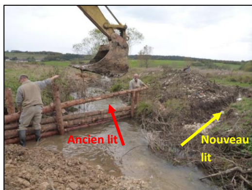
Figure 30: Illustration de protection de jonction ancien lit / nouveau lit. A gauche mise en place de rondins d'épicéa, à droite mise en place d'un substrat argilo-marneux et de terre végétale attenant aux rondins préalablement disposés (cliché Pierre Durllet, PNR Haut-Jura, restauration du Nachez, 39).
