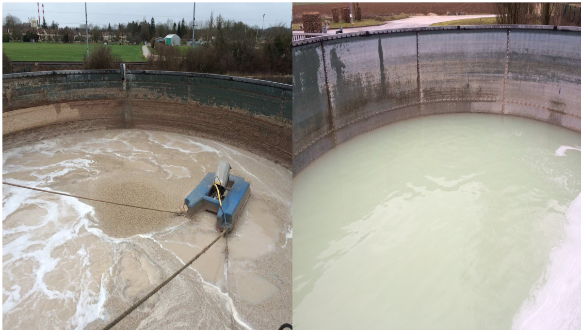
Figure 6 Bassins tampons (avant et après le traitement physico-chimique)
