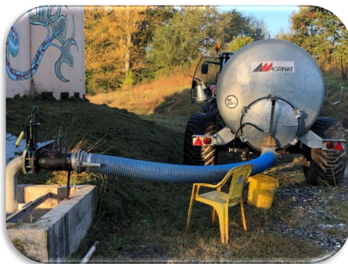
Figure 11 : Exemple d'extraction de boue d'un silo de stockage - Photo AE
