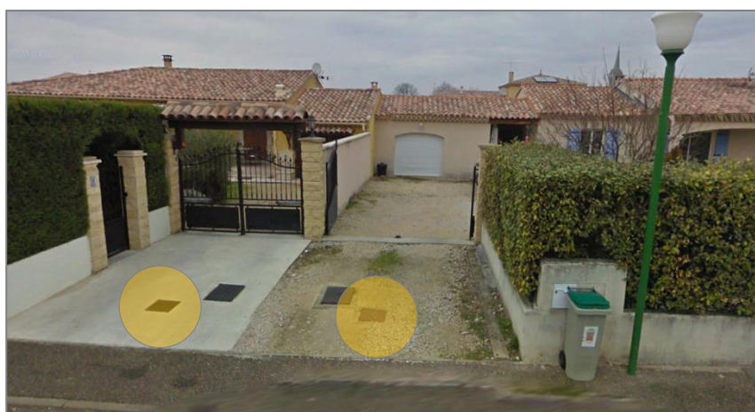
Figure 20 : Vue des boîtes d'eaux usées des 2 habitations sur le terrain
