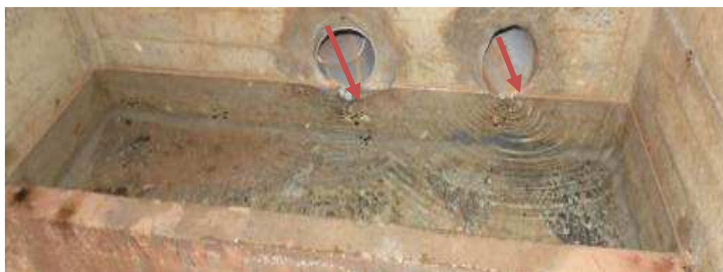
Photo 4 : intérieurs de l'ouvrage de captage
