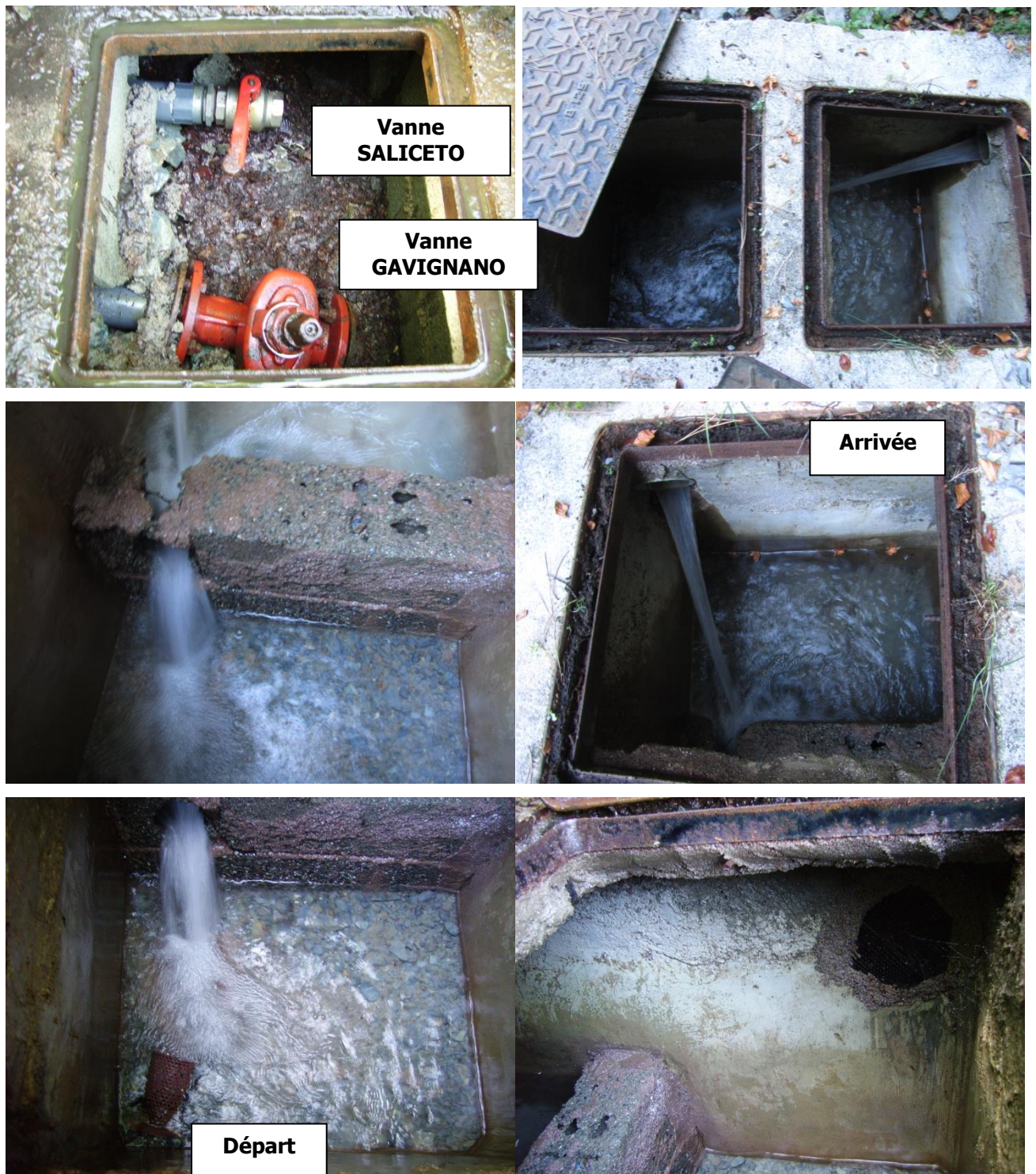
Figure 14 : Regard des vannes et bac de décantation
