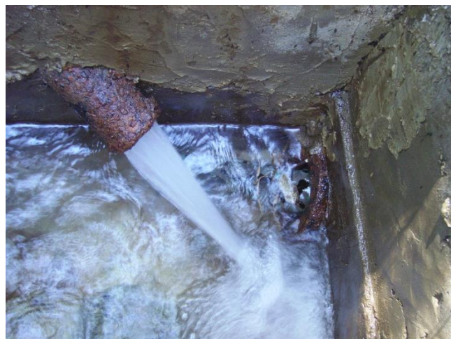
Figure 32 : Regard brise-charge n° 2 – Départ
