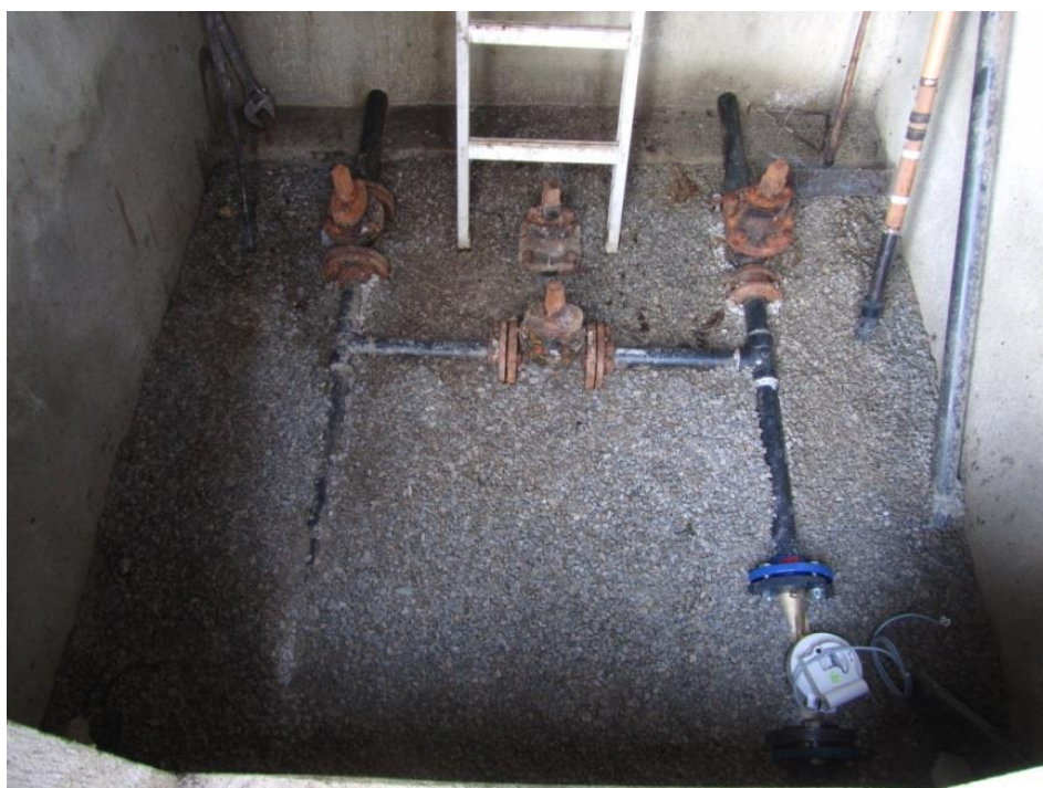
Figure 26 : Chambre des vannes
