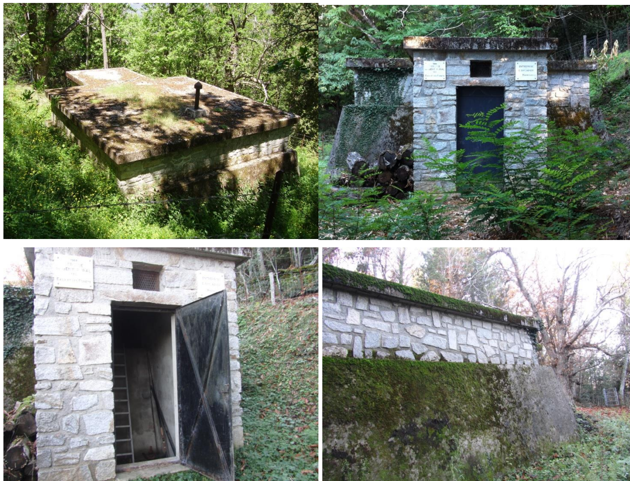
Figure 23 : Vue générale du réservoir
