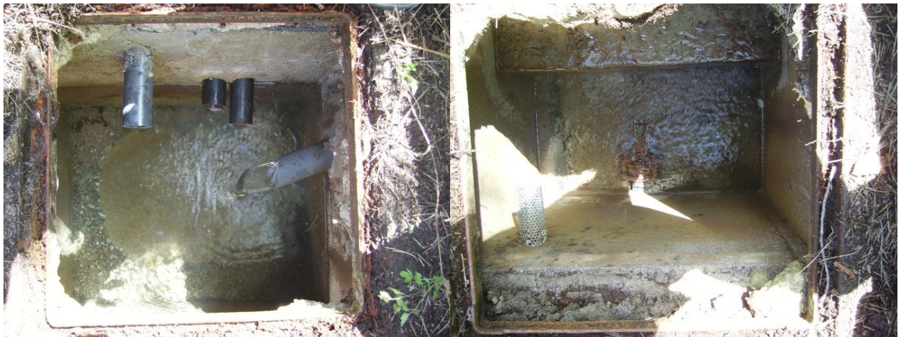
Figure 21 : Bac de décantation
