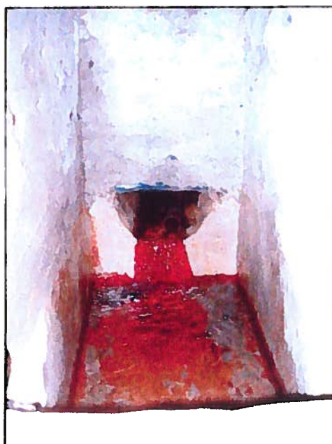
Fig. 13 – Chambre de captage de la source du bas
