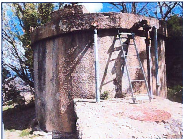
Photo 3 : Le nouveau réservoir
