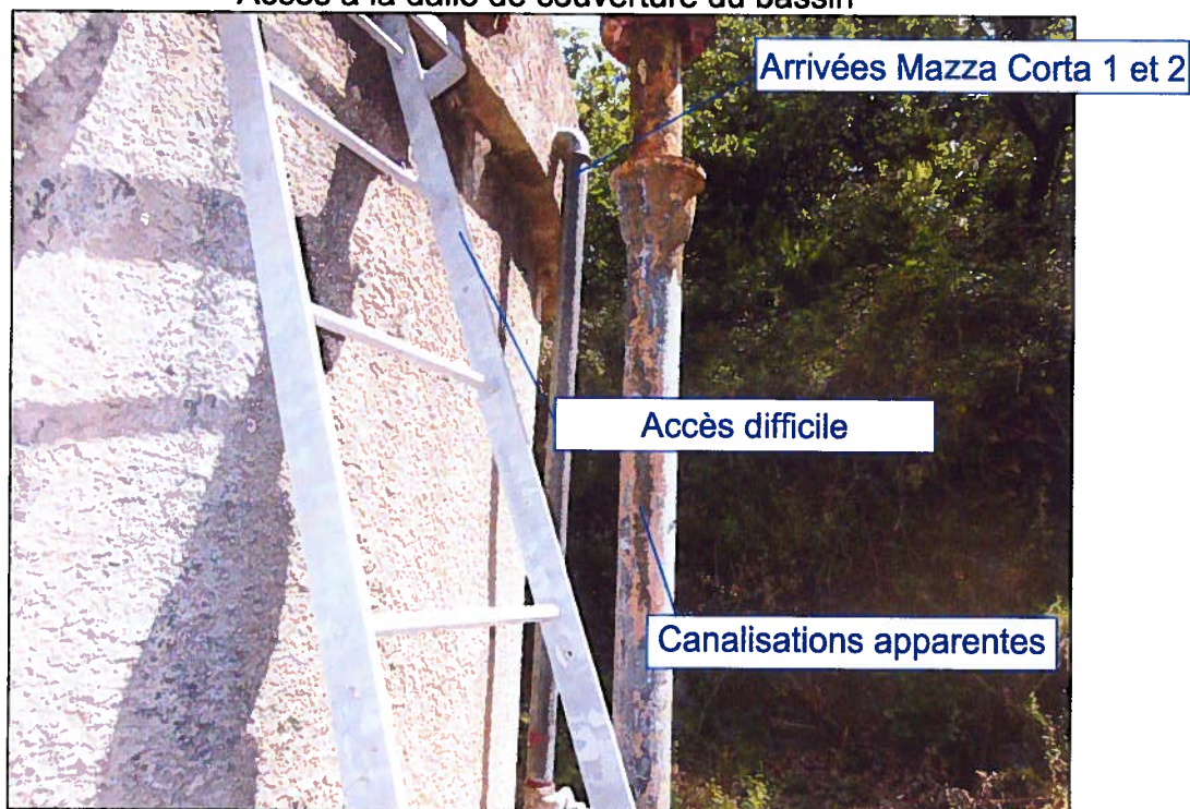
Accès à la dalle de couverture du bassin
