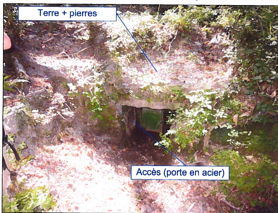
Extérieur du regard de captage
