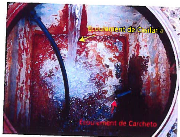
Détail du regard de captage de Casilaria
