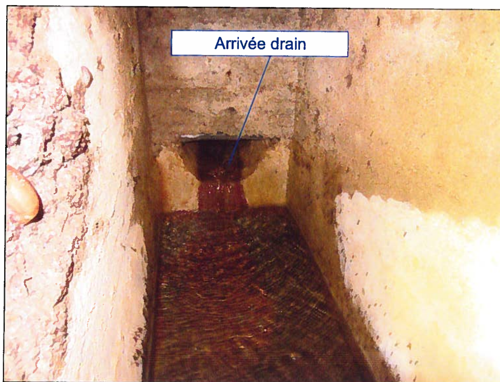
Intérieur du regard de captage
