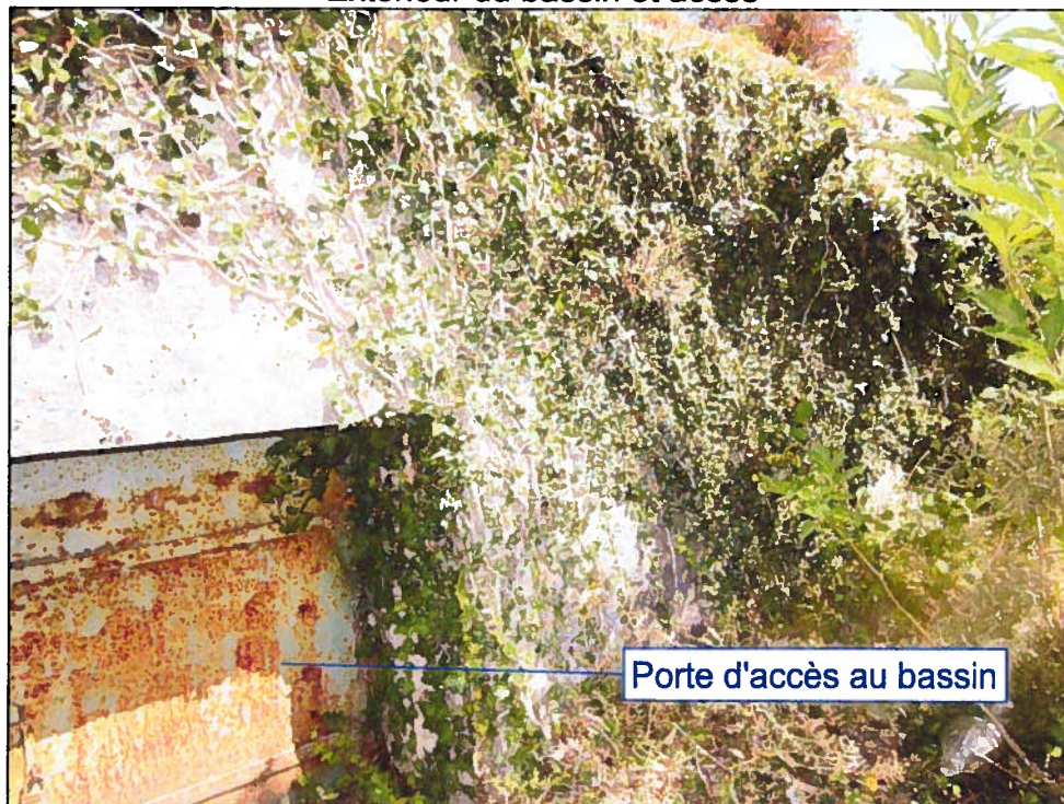
Extérieur du bassin et accès
