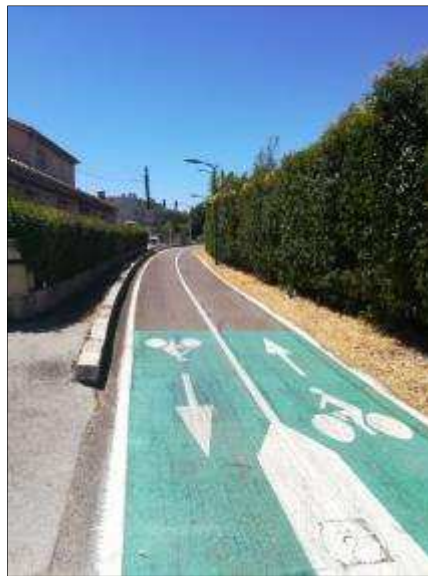
Piste cyclable entre la Garde et le Pradet (réfection de voiries / réseau d'assainissement en 2018)
