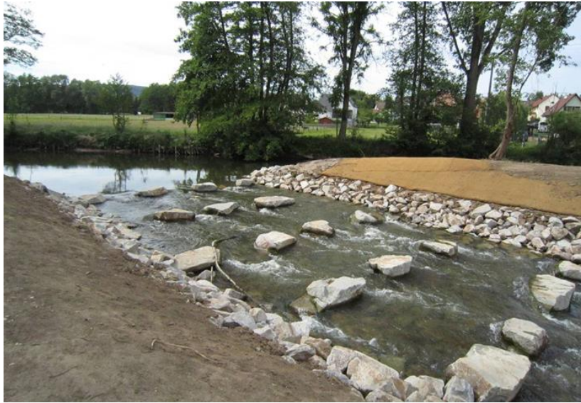
Fig. 50. Rampe en enrochements naturels sur la Zorn à Steinbourg
