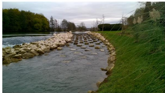
Fig. 51. Rampe en enrochements taillés sur le barrage Azans sur le Doubs
