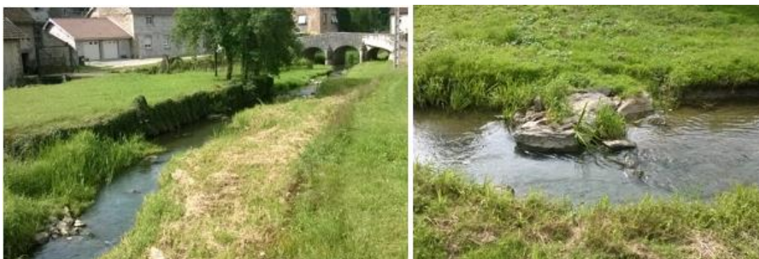
Fig. 66. Exemple d'épis de diversification sur la Colombine à Calmoutier
