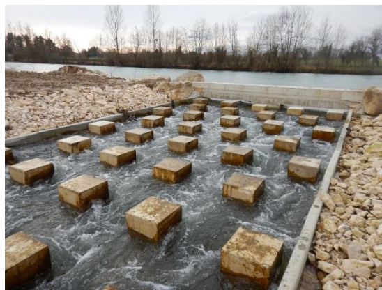
Fig. 52. Rampe à macrorugosités régulièrement réparties sur la Loue à Arc-et-Senans (39)
