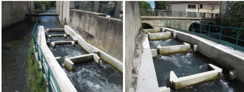
Fig. 58. Exemple de passe à bassins successifs à double fente (Mirebeau-sur-Bèze, MOE ARTELIA 2016)
