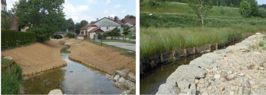
Fig. 68. Exemple de banquettes avec sous-berges sur le Dugeon
