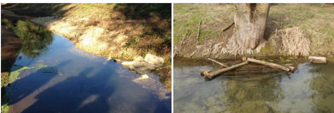
Fig. 66. Exemple d'épis de diversification sur la Colombine à Calmoutier
