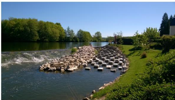
Fig. 51. Rampe en enrochements taillés sur le barrage Azans sur le Doubs
