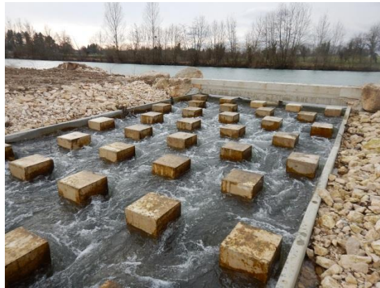
Fig. 48. Rampe à macrorugosités régulièrement réparties sur la Loue à Arc-et-Senans (39)
