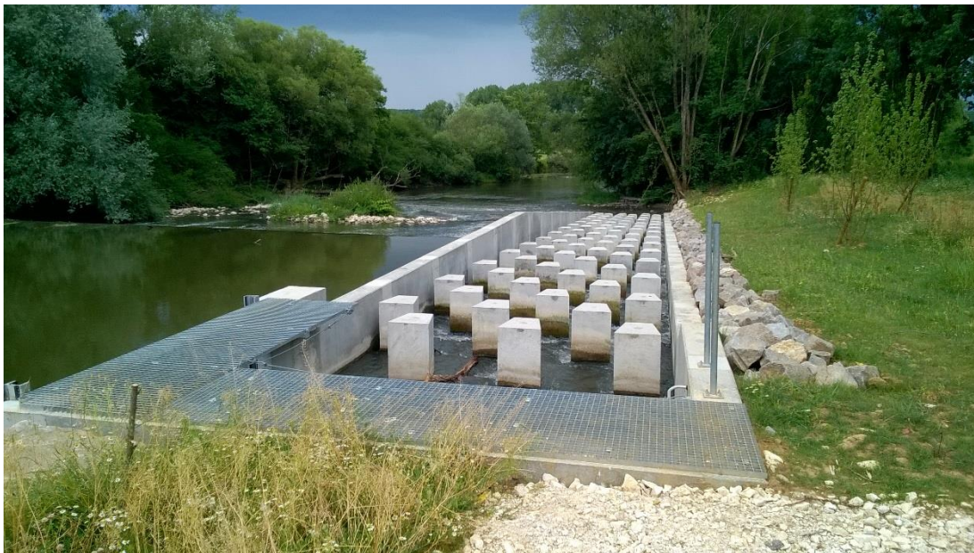
Fig. 49. Rampe à macrorugosités installée sur l'Allan à Méziré
