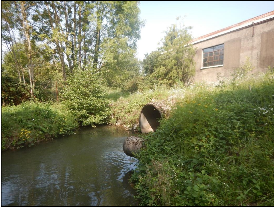
Fig. 15. Exutoire des eaux transitant dans l'usine
