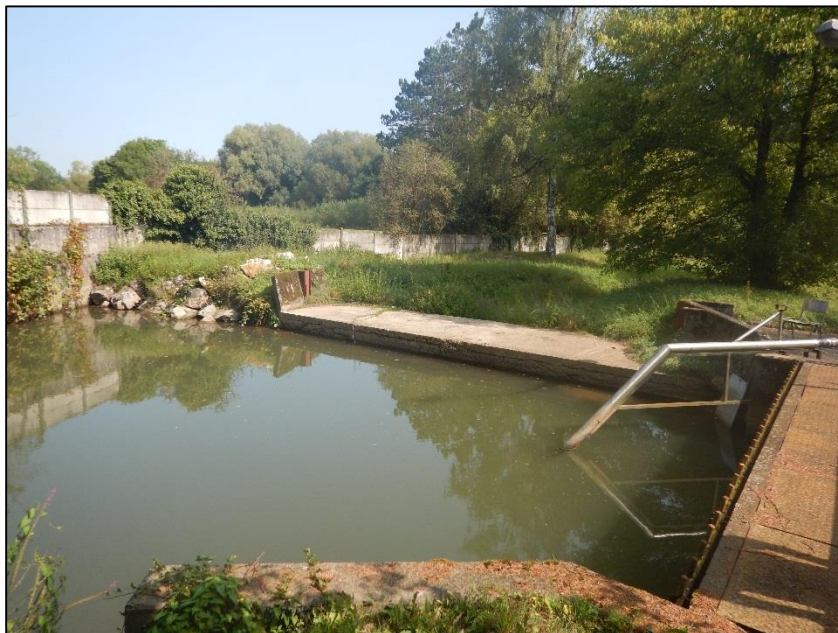
Fig. 10. Déversoir de décharge
