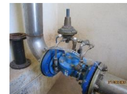
Stabilisateur régulation/adduction
