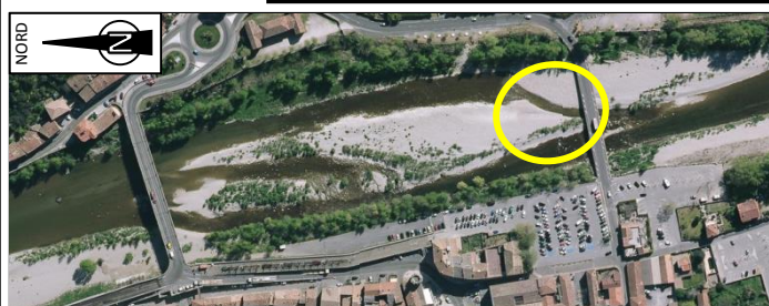
Photo 3 : Vue d'ensemble depuis le pont de la D910A
