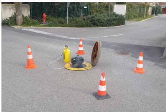
Figure 4 : Photographie de l'injection de fumée lors de tests à la fumée
