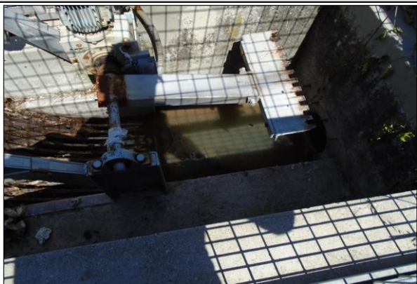
Ouvrages de prétraitement désableur-déshuileur
