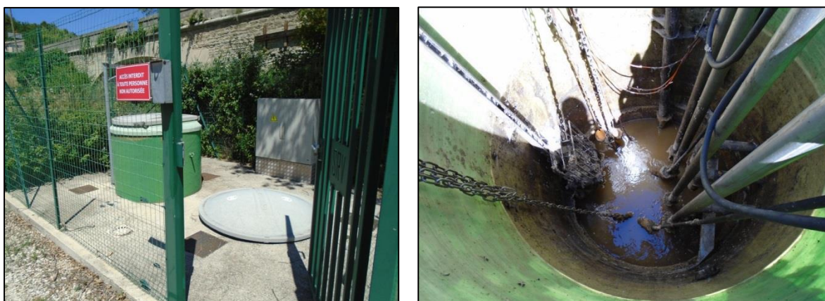
Figure 20 : Photographies du PR des Bastides
