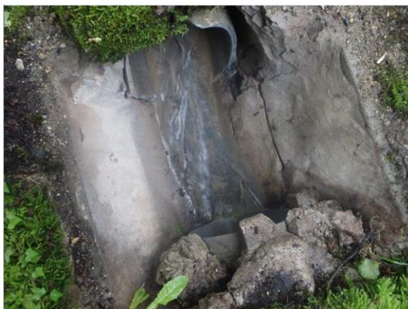
*Tampon/grille cassée, fissurée + Mauvaise jonction regard/canalisation – Regard n° 195 – La Verne –*
