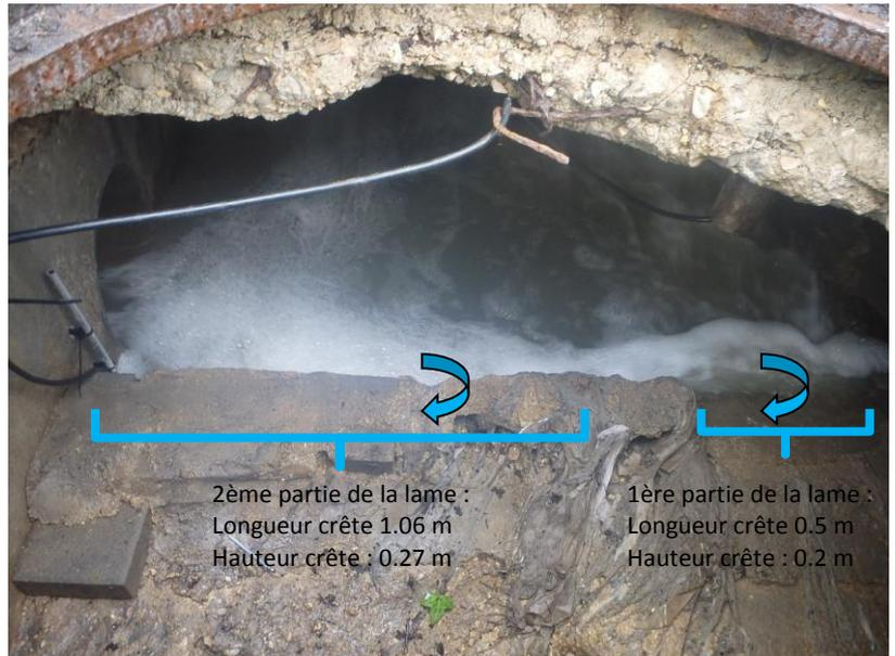
Les volumes déversés n'ont pu être extrapolés de la mesure de hauteur au droit de la lame. En effet (cf. photo ci-dessus), la lame déversante de l'ouvrage est très irrégulière (un moellon semble être parti sur la première partie de la lame). Ainsi, seule la fréquence de fonctionnement a pu être établie pour cet ouvrage.
