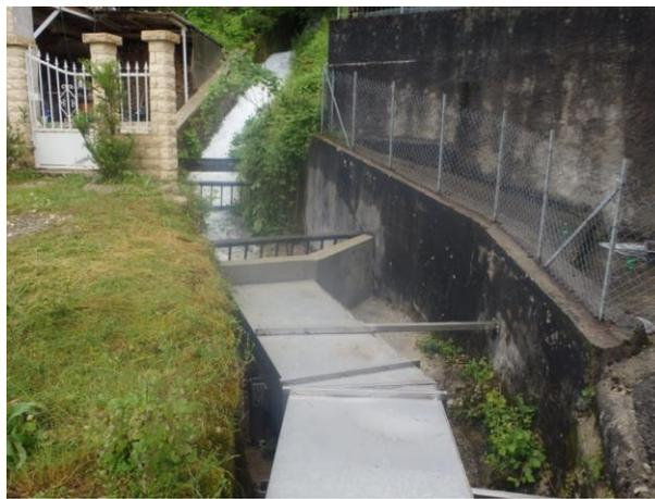
*Talweg après déconnexion (le dispositif permet de diriger les eaux vers le réseau pluvial)*
