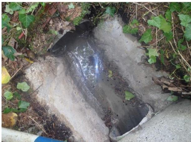
*Tampon/grille cassée, fissurée + Mauvaise jonction regard/canalisation – Regard n° 39 – La Verne*
