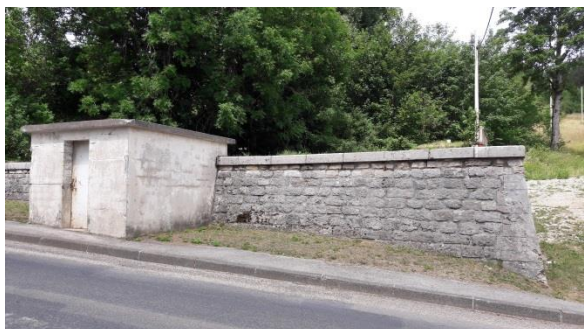
Bache de stockage
