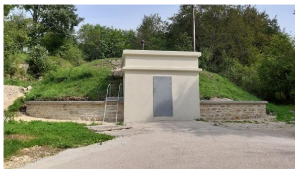
Réservoir de tête
