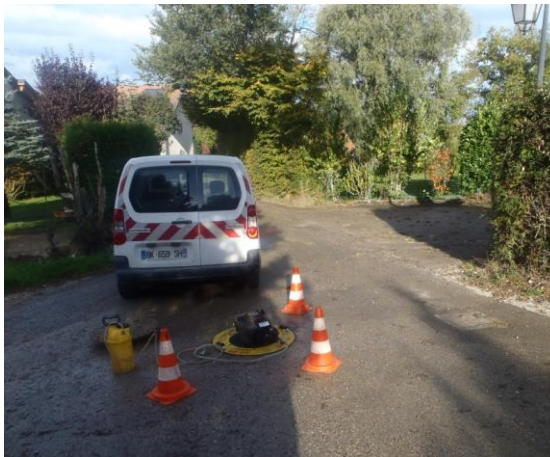
1 - Injection de fumée dans le réseau d'eaux usées
