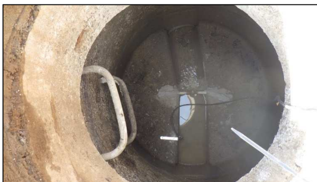
Photo 5 : Point de mesure Rue des Querelles
