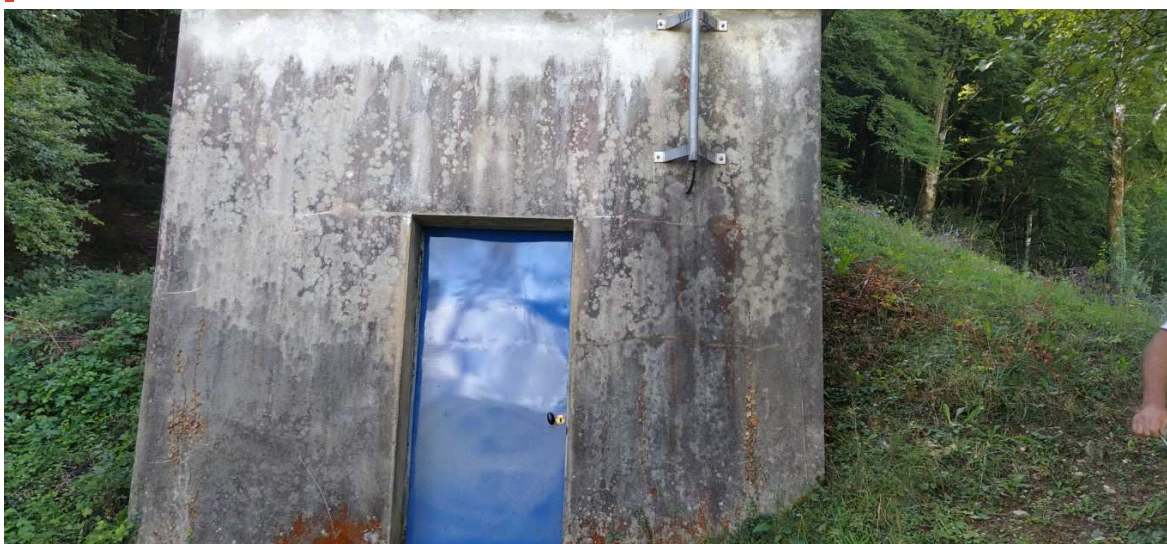
Accès chambre à vannes du réservoir
