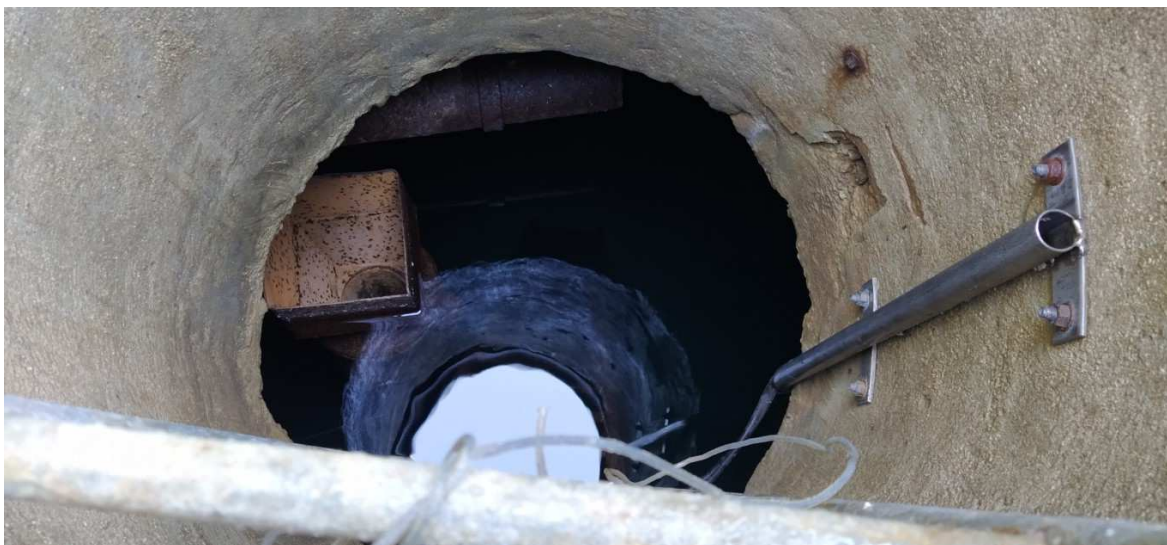
Vue intérieur accès cuve du réservoir
