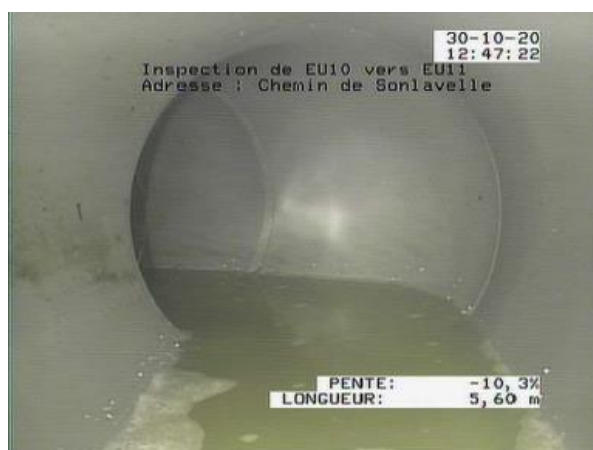
Figure 26 : Illustrations d'obstruction sur le tronçon de réseau – Chemin de Sonlavelle
