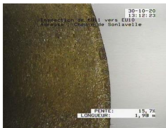
Figure 26 : Illustrations d'obstruction sur le tronçon de réseau – Chemin de Sonlavelle
