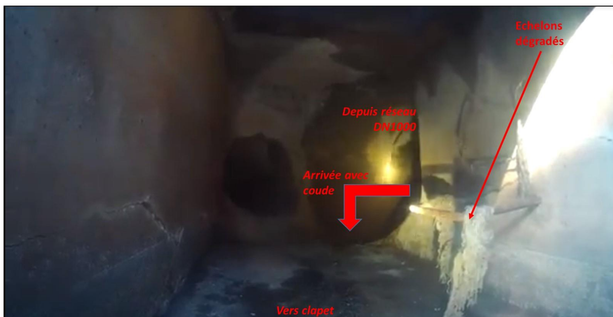
Figure 38. Vue de l'intérieur du regard en amont du clapet avant rejet dans la Savoureuse.
