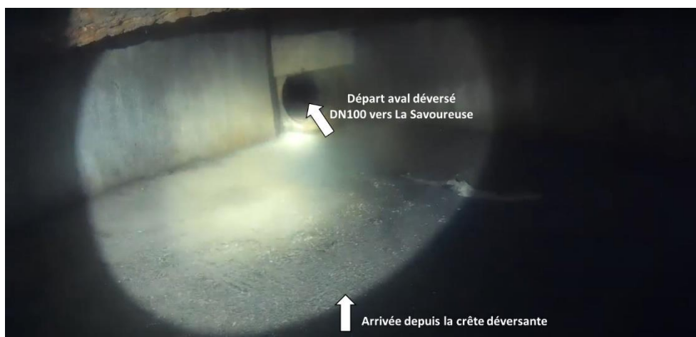
Figure 4. Vue de l'intérieur de l'amont du collecteur aval déversé depuis la chambre du DO15 Théâtre (Source : 3D EAU).
