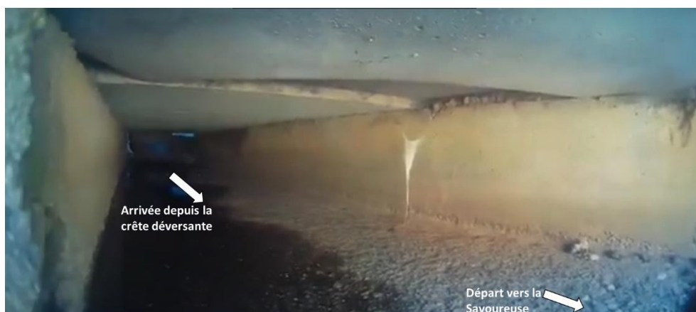
Figure 4. Vue de l'intérieur de l'aval du collecteur aval déversé depuis le rejet du DO16 Degombert (Source : 3D EAU).
