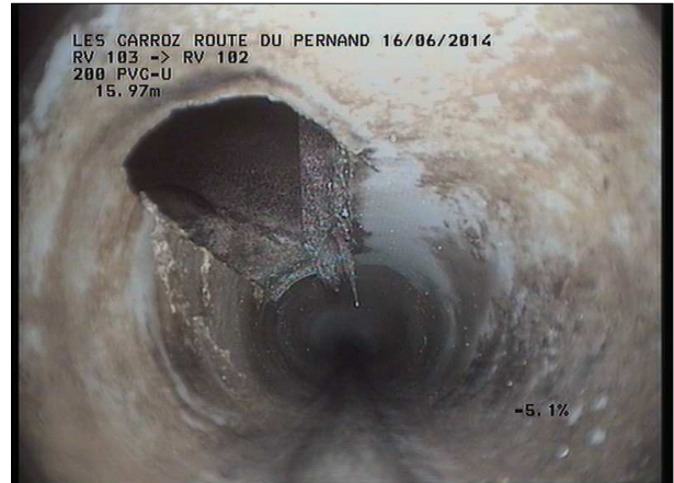
Photo: 5_2A, MPEG #: 160614_1, 00:01:50 16,3m, Fin de l'inspection RV 102
