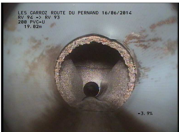
Photo: 14_3A, MPEG #: 160614_1, 00:01:37 19,74m, Fin de l'inspection RV 90 SCERCL
