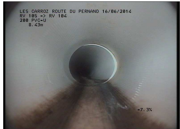
Photo: 3_2A, MPEG #: 160614_1, 00:00:46 8,82m, Profil en plan (modification angulaire) à gauche
