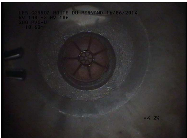
Photo: 1_2B, MPEG #: 160614_1, 00:00:56 10,62m, Fin de l'inspection RV 106 SOUS ENROBES
