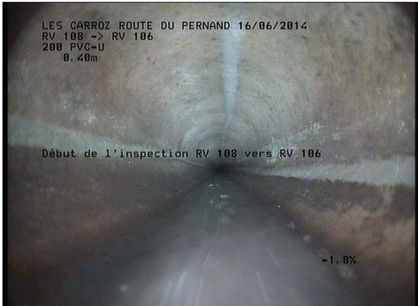
Photo: 1_1A, MPEG #: 160614_1, 00:00:00 0,4m, Début de l'inspection RV 108 vers RV 106
