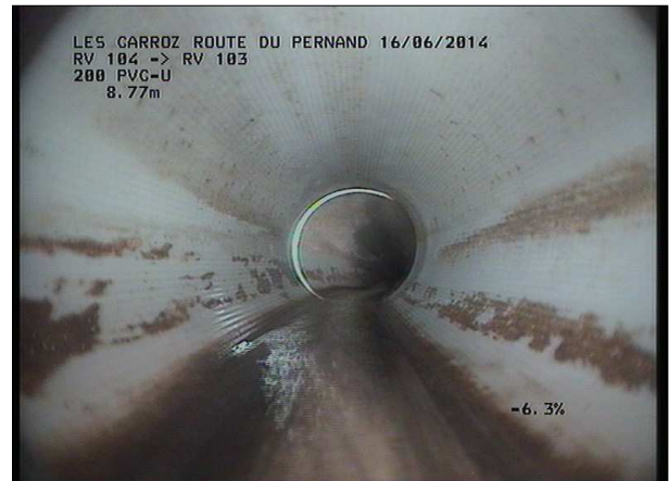
Photo: 4_6A, MPEG #: 160614_1, 00:01:55 9,36m, Profil en plan (modification angulaire) à droite
