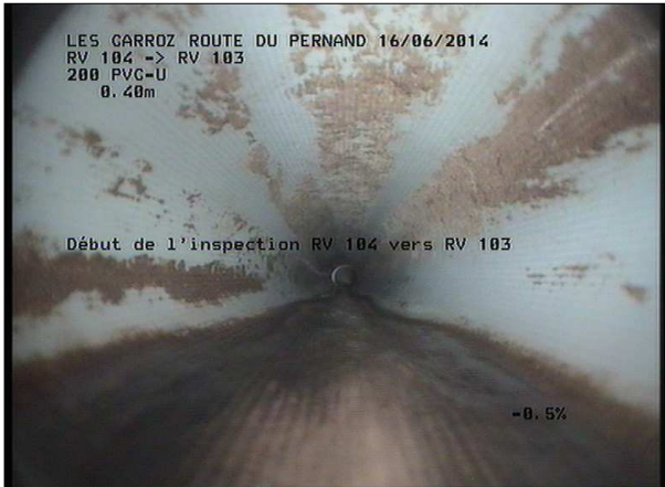
Photo: 4_1A, MPEG #: 160614_1, 00:00:00 0,4m, Début de l'inspection RV 104 vers RV 103
