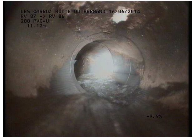
Photo: 21_4A, MPEG #: 160614_1, 00:03:04 11,4m, Coude à gauche
