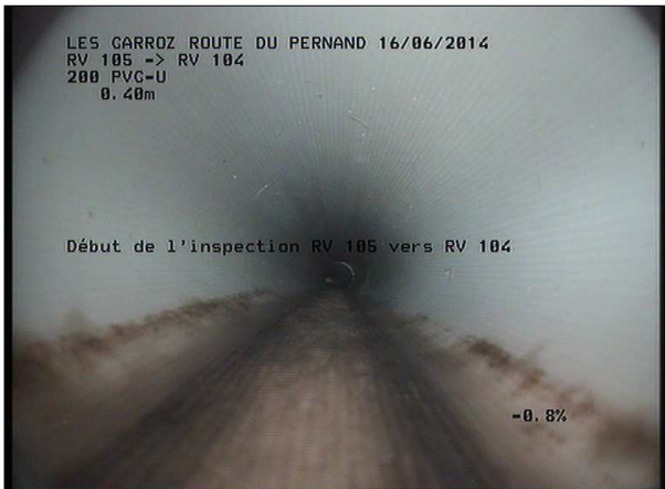
Photo: 3_1A, MPEG #: 160614_1, 00:00:00 0,4m, Début de l'inspection RV 105 vers RV 104
