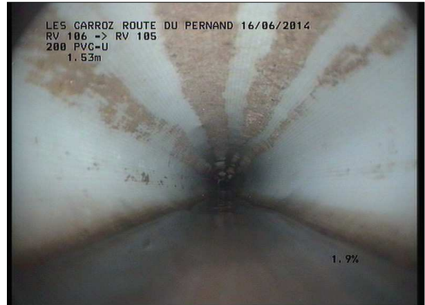
Photo: 2_2A, MPEG #: 160614_1, 00:00:13 1,53m, Profil long (contre-pente) + 1.9%
