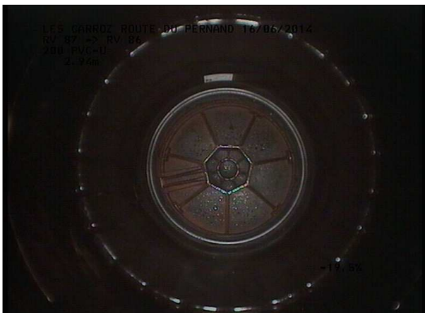
Photo: 21_2B, MPEG #: 160614_1, 00:00:25 2,94m, Passage dans regard en PLASTIQUE RV 87 BIS
