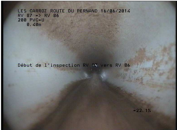
Photo: 21_1A, MPEG #: 160614_1, 00:00:00 0,4m, Début de l'inspection RV 87 vers RV 86
