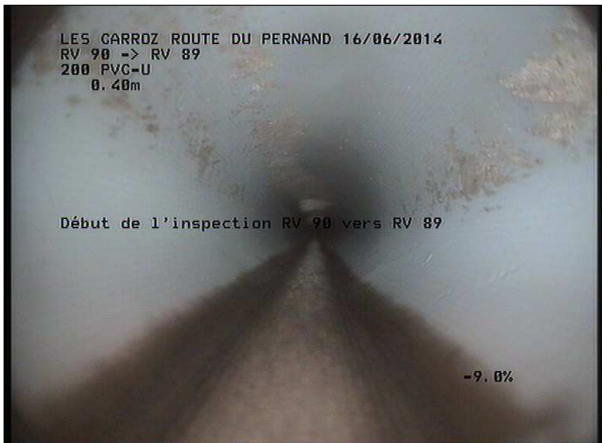
Photo: 18_1A, MPEG #: 160614_1, 00:00:00 0,4m, Début de l'inspection RV 83 SCERCL vers RV 81 SCERCL
