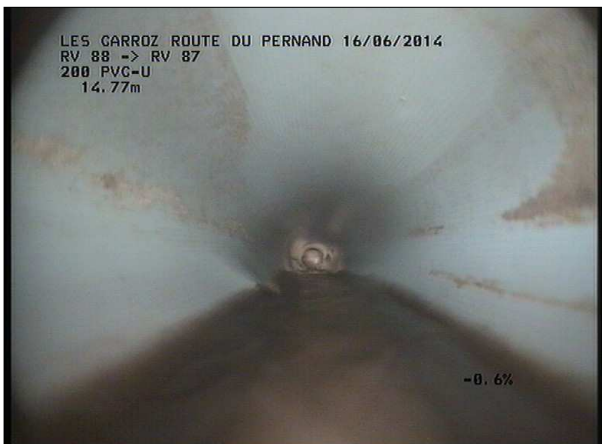
Photo: 20_3A, MPEG #: 160614_1, 00:01:17 15,09m, Ecrasement latéral avec déformation du fil d'eau à 07 h
