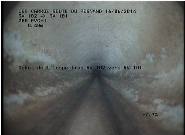
Photo: 6_1A, MPEG #: 160614_1, 00:00:00 0,4m, Début de l'inspection RV 102 vers RV 101
