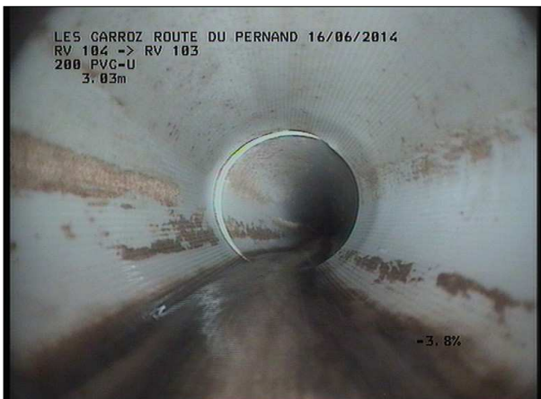
Photo: 4_3A, MPEG #: 160614_1, 00:00:38 3,43m, Profil en plan (modification angulaire) à droite
