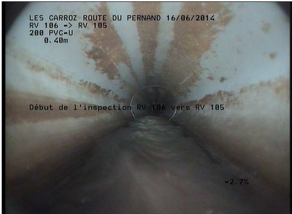
Photo: 2_1A, MPEG #: 160614_1, 00:00:00 0,4m, Début de l'inspection RV 106 vers RV 105
