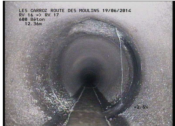
Photo: 16_2A, MPEG #: 180614_1, 00:00:52 12,36m, Raccordement direct à 01 h dans R 957
