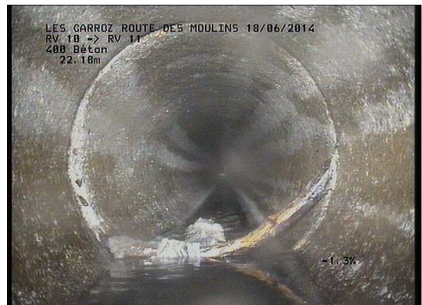
Photo: 10_5A, MPEG #: 180614_1, 00:03:19 23,1m, Pénétration d'élément extérieur de 03 à 08 h morceau de bois coincé dans un emboîtement
