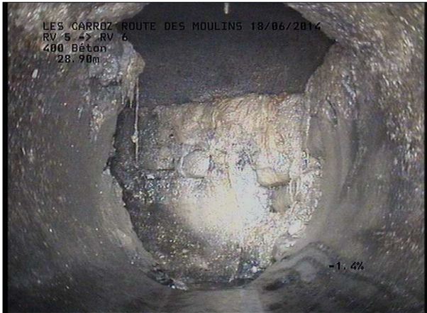
Photo: 5_8A, MPEG #: 180614_1, 00:03:47 28,9m, Fin de l'inspection R 283 sous enrobés
