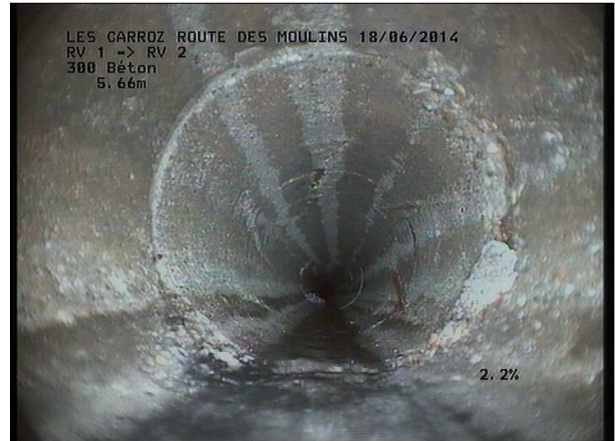
Photo: 1_4A, MPEG #: 180614_1, 00:01:15 5,66m, Profil long (contre-pente) + 2.2%
