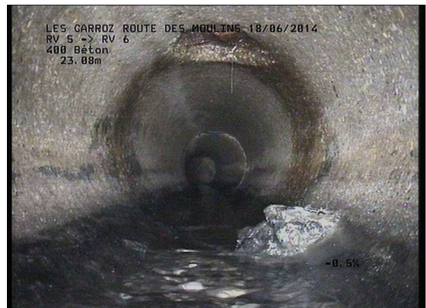
Photo: 5_5A, MPEG #: 180614_1, 00:02:39 23,08m, Dépôt de concrétions de 04 à 06 h.
