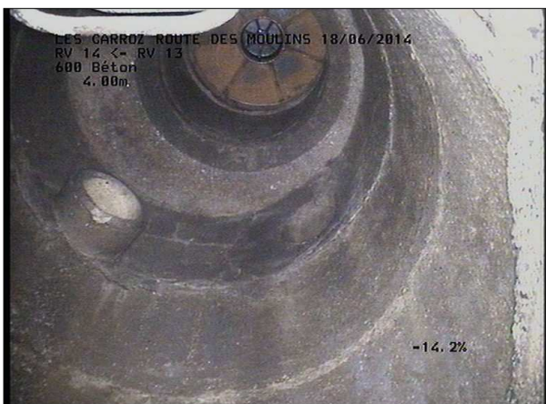
Photo: 13_2B, MPEG #: 180614_1, 00:00:46 4m, Fin de l'inspection R 247
