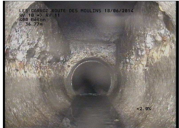
Photo: 10_6A, MPEG #: 180614_1, 00:05:15 37,61m, Fin de l'inspection R 264
