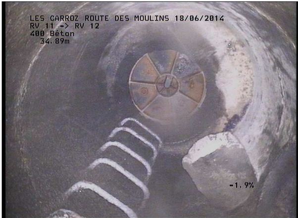
Photo: 11_9B, MPEG #: 180614_1, 00:05:24 34,89m, Fin de l'inspection R 258
