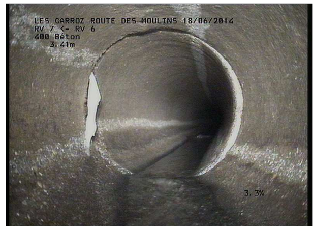
Photo: 6_3A, MPEG #: 180614_1, 00:00:41 3,95m, Profil en plan (modification angulaire) à droite
