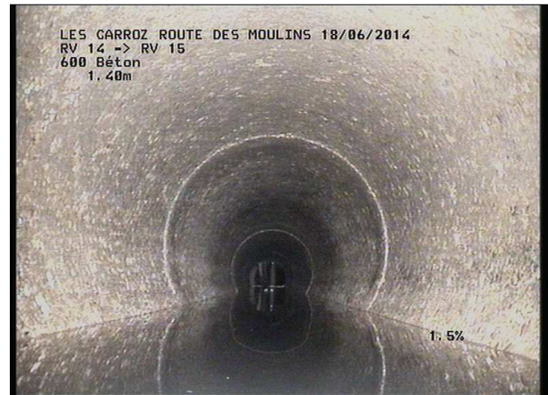
Photo: 14_2A, MPEG #: 180614_1, 00:00:42 8,71m, Profil long (contre-pente) + 1.4%
