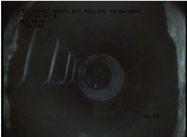
Photo: 2_11B, MPEG #: 180614_1, 00:05:41 46,36m, Fin de l'inspection R 291
