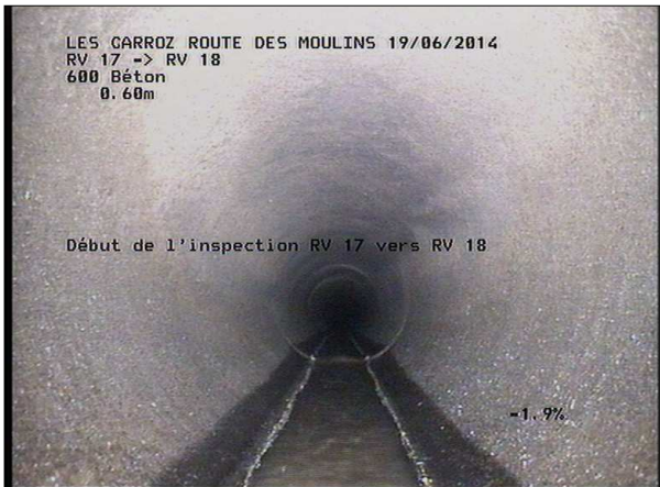
Photo: 17_1A, MPEG #: 180614_1, 00:00:00 0,6m, Début de l'inspection R 957 vers R 950
