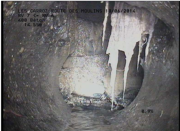
Photo: 6_6A, MPEG #: 180614_1, 00:03:09 15,19m, Fin de l'inspection R 283 sous enrobés
