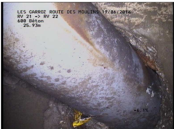
Photo: 21_4B, MPEG #: 180614_1, 00:01:58 25,93m, Traversée de voûte par tuyau
