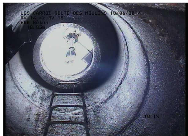
Photo: 14_3B, MPEG #: 180614_1, 00:03:22 18,83m, Fin de l'inspection R 245
