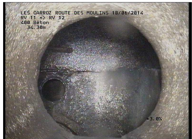
Photo: 11_9A, MPEG #: 180614_1, 00:05:24 34,89m, Fin de l'inspection R 258
