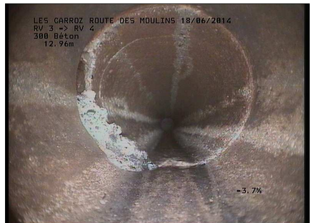
Photo: 3_7A, MPEG #: 180614_1, 00:02:37 13,28m, Dépôt de concrétions de 06 à 09 h.
