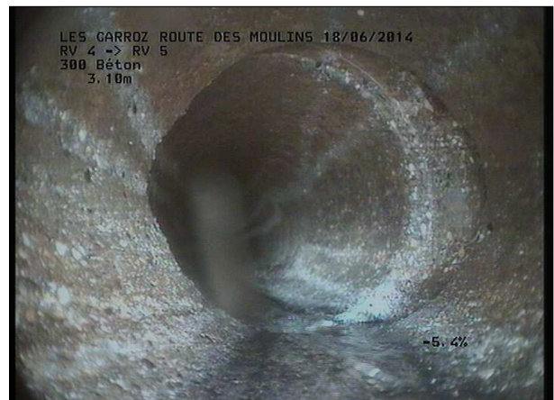
Photo: 4_3A, MPEG #: 180614_1, 00:00:38 3,46m, Profil en plan (modification angulaire) à gauche
