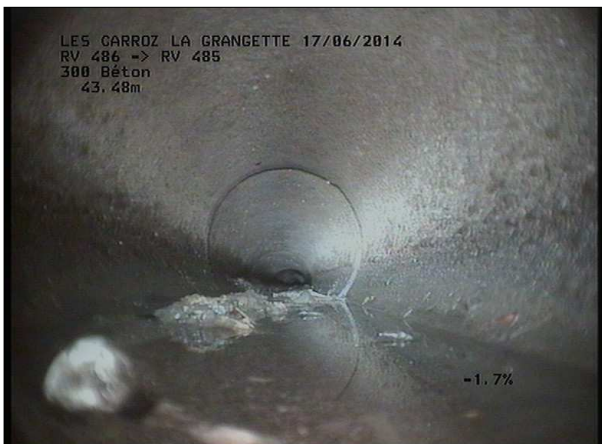
Photo: 16_14A, MPEG #: 160614_1, 00:07:43 43,48m, Dépôt de sédiments de 04 à 08 h.
