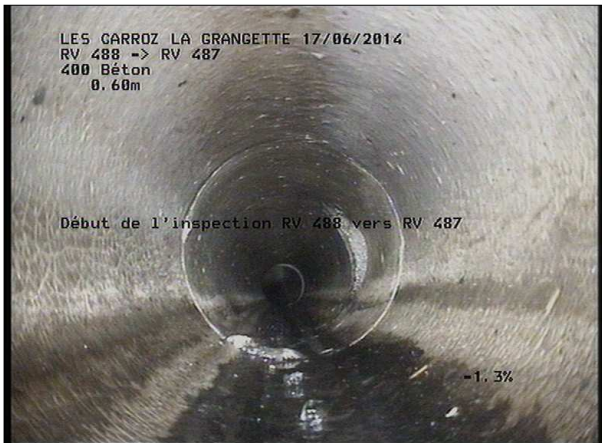
Photo: 13_1A, MPEG #: 160614_1, 00:00:00 0,6m, Début de l'inspection RV 488 vers RV 487
