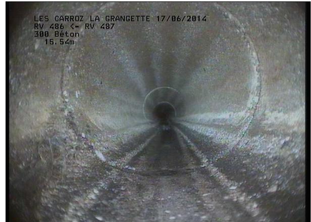
Photo: 15_8A, MPEG #: 160614_1, 00:00:36 15,77m, Racines et radicelles à 08 h.
