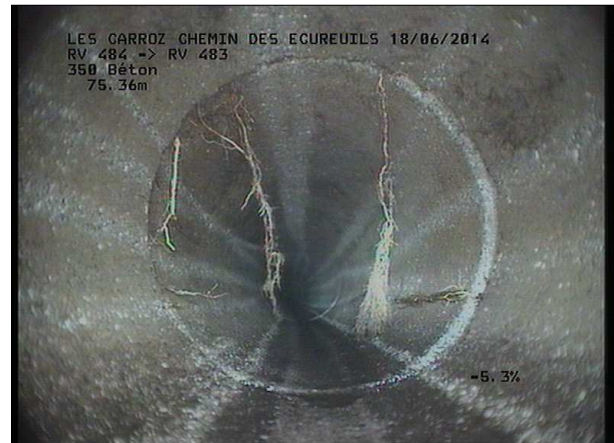
Photo: 23_18A, MPEG #: 160614_1, 00:12:19 75,65m, Radicelles de 12 à 12 h.
