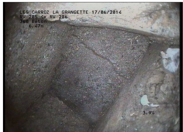
Photo: 17_3B, MPEG #: 160614_1, 00:00:42 6,47m, Interruption de l'inspection dans REGARD BORGNE
