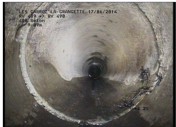
Photo: 11_3A, MPEG #: 160614_1, 00:01:16 9,48m, Racines et radicelles à 04 h.
