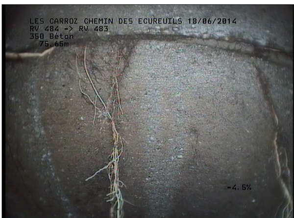
Photo: 23_18B, MPEG #: 160614_1, 00:12:19 75,65m, Radicelles de 12 à 12 h.
