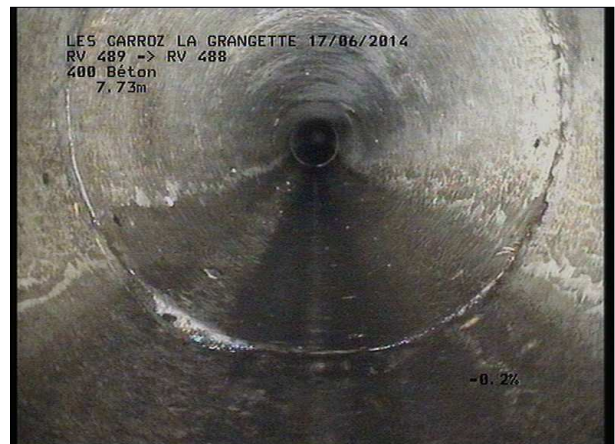
Photo: 12_5A, MPEG #: 160614_1, 00:01:58 8,25m, Radicelles à 05 h.
