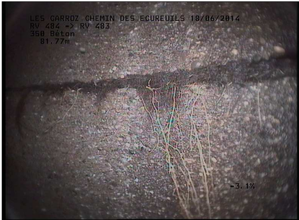
Photo: 23_21B, MPEG #: 160614_1, 00:13:54 81,77m, Radicelles de 12 à 12 h.
