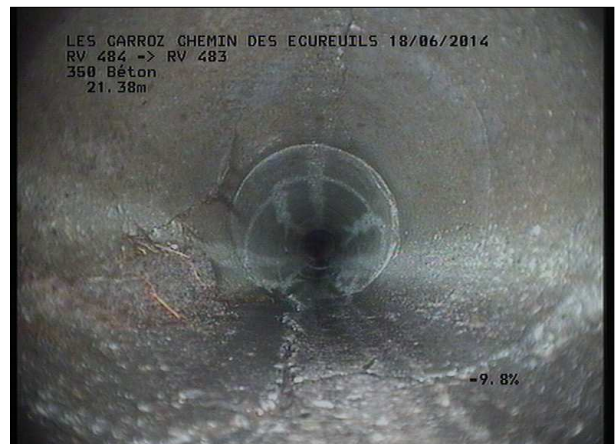
Photo: 23_5A, MPEG #: 160614_1, 00:02:47 21,57m, Racines et radicelles de 06 à 12 h.
