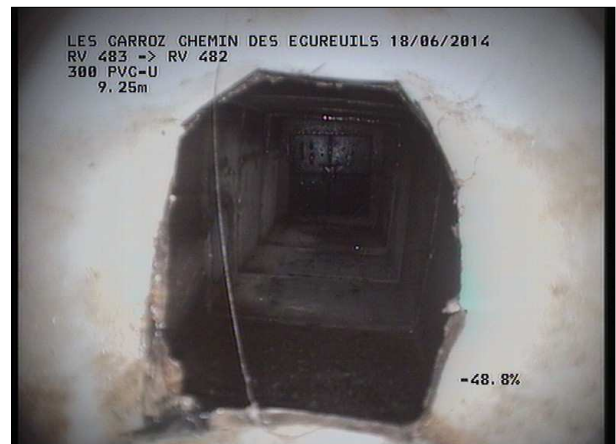
Photo: 24_3B, MPEG #: 160614_1, 00:00:45 9,25m, Passage dans regard section carrée
