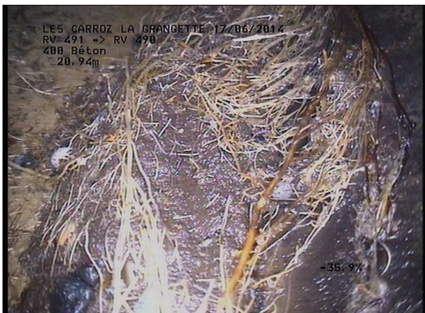
Photo: 10_15B, MPEG #: 160614_1, 00:06:23 20,94m, Racines et radicelles à 07 h.
