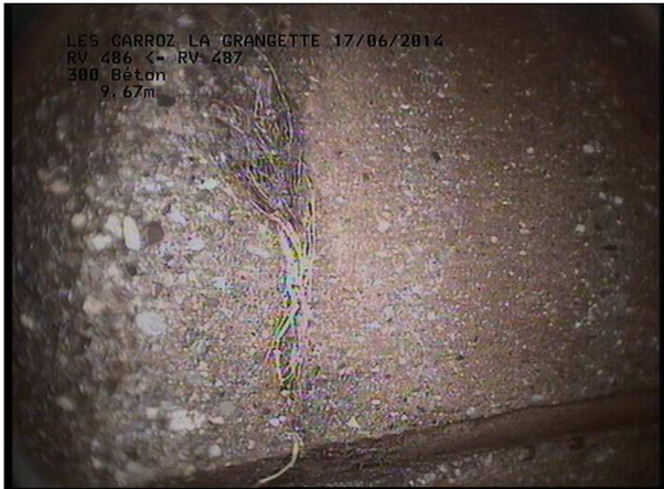
Photo: 15_5B, MPEG #: 160614_1, 00:00:36 9,67m, Racines et radicelles à 04 et 09 h.
