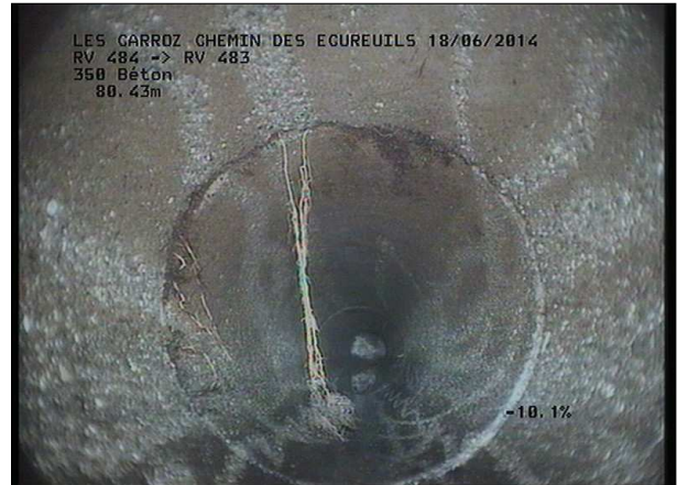
Photo: 23_20A, MPEG #: 160614_1, 00:13:27 80,43m, Radicelles de 08 à 12 h.
