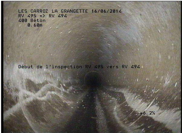
Photo: 6_1A, MPEG #: 160614_1, 00:00:00 0,6m, Début de l'inspection RV 495 vers RV 494
