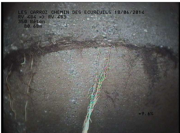
Photo: 23_20B, MPEG #: 160614_1, 00:13:27 80,43m, Radicelles de 08 à 12 h.
