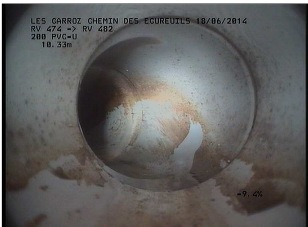
Photo: 25_3A, MPEG #: 160614_1, 00:01:26 10,59m, Coude à gauche
