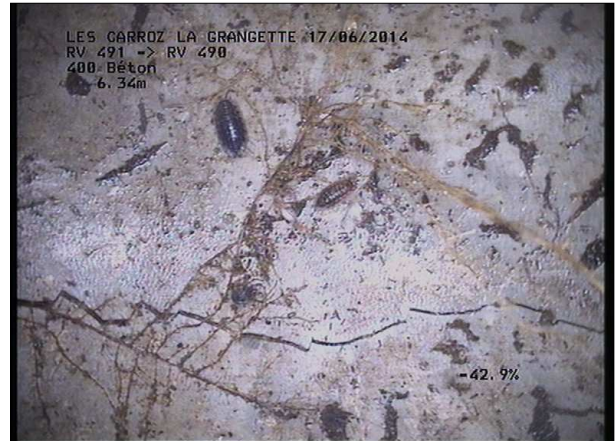
Photo: 10_6B, MPEG #: 160614_1, 00:02:16 6,34m, Racines et radicelles à 01 h.
