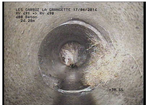
Photo: 10_16A, MPEG #: 160614_1, 00:06:56 25,07m, Racines et radicelles de 02 à 05 h.
