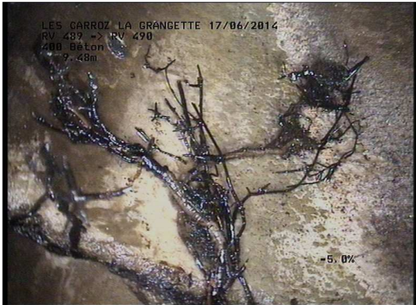
Photo: 11_3B, MPEG #: 160614_1, 00:01:16 9,48m, Racines et radicelles à 04 h.
