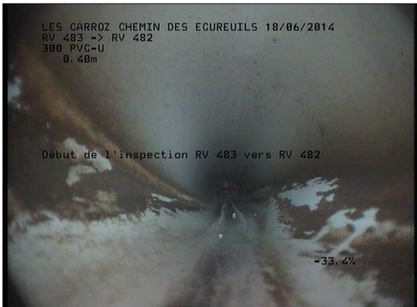
Photo: 24_1A, MPEG #: 160614_1, 00:00:00 0,4m, Début de l'inspection RV 480 SCERCL vers RV 470 SCERCL
