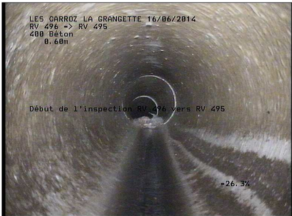
Photo: 5_1A, MPEG #: 160614_1, 00:00:00 0,6m, Début de l'inspection RV 496 vers RV 495
