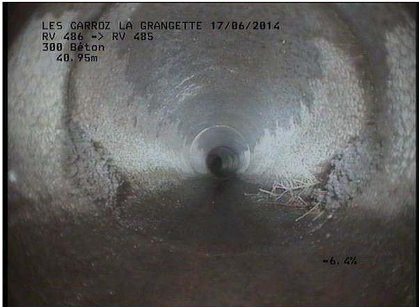
Photo: 16_13A, MPEG #: 160614_1, 00:06:14 41,16m, Racines et radicelles de 04 à 05 h.
