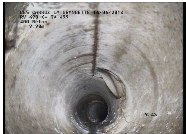
Photo: 2_6A, MPEG #: 160614_1, 00:02:25 9,9m, Armatures visibles à 12 h.
