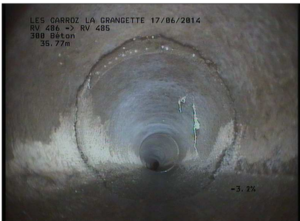
Photo: 16_12A, MPEG #: 160614_1, 00:05:45 36,04m, Epaufrure de 11 à 01 h.
