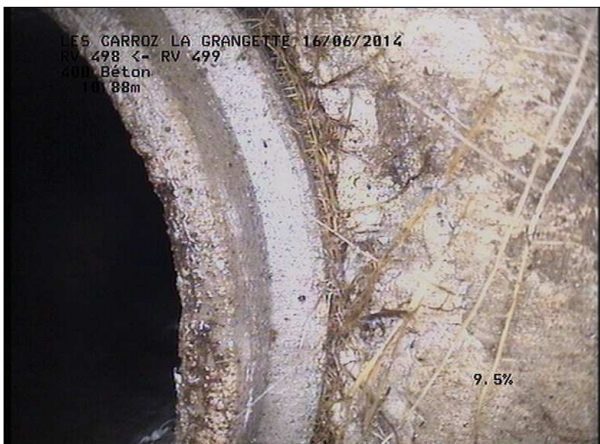
Photo: 2_7B, MPEG #: 160614_1, 00:02:45 10,88m, Racines et radicelles de 12 à 03 h.
