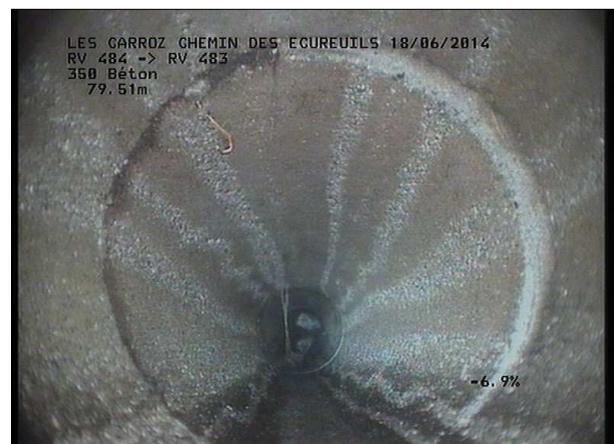
Photo: 23_19A, MPEG #: 160614_1, 00:13:02 79,72m, Radicelles à 11 h.
