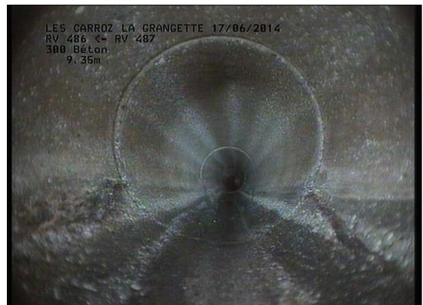
Photo: 15_5A, MPEG #: 160614_1, 00:00:36 9,67m, Racines et radicelles à 04 et 09 h.
