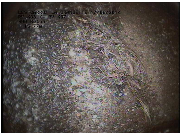
Photo: 15_8B, MPEG #: 160614_1, 00:00:36 15,77m, Racines et radicelles à 08 h.
