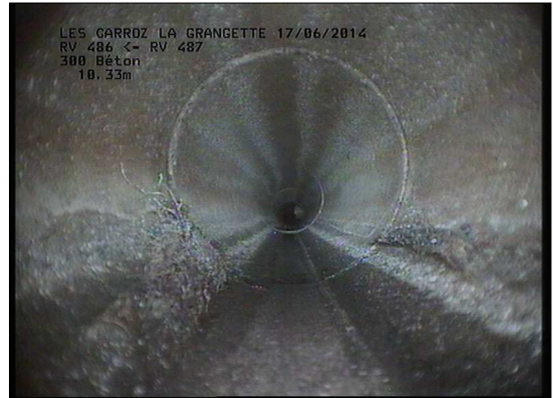
Photo: 15_6A, MPEG #: 160614_1, 00:00:36 10,66m, Racines et radicelles à 03 et 09 h.
