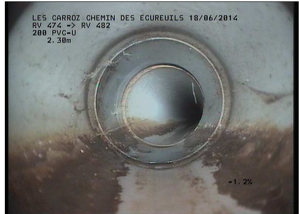
Photo: 25_2A, MPEG #: 160614_1, 00:00:28 2,56m, Coude à droite
