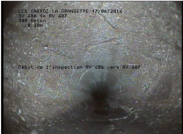
Photo: 15_1A, MPEG #: 160614_1, 00:00:00 0,2m, Début de l'inspection RV 486 vers RV 487
