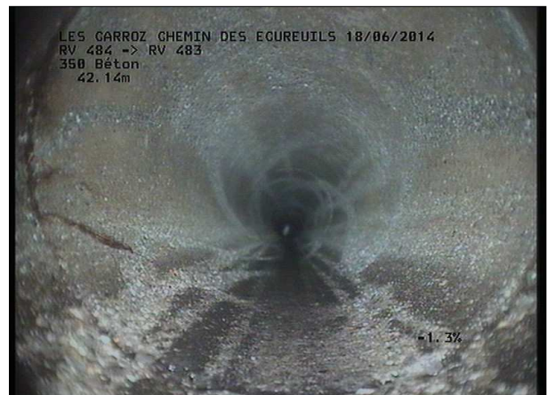
Photo: 23_9A, MPEG #: 160614_1, 00:06:08 42,34m, Radicelles à 09 h.
