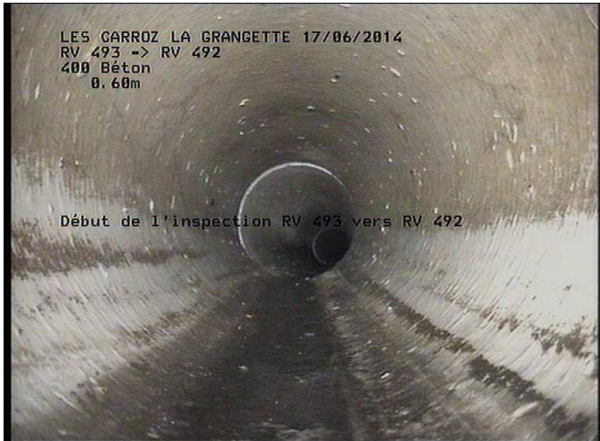
Photo: 8_1A, MPEG #: 160614_1, 00:00:00 0,6m, Début de l'inspection RV 493 vers RV 492
