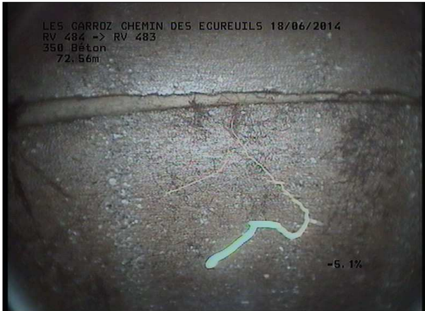
Photo: 23_15B, MPEG #: 160614_1, 00:10:49 72,56m, Radicelles à 01 h.
