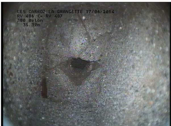
Photo: 15_10B, MPEG #: 160614_1, 00:00:36 35,39m, Interruption de l'inspection dans REGARD BORGNE
