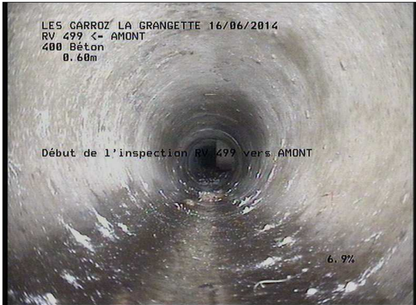
Photo: 3_1A, MPEG #: 160614_1, 00:00:00 0,6m, Début de l'inspection RV 499 vers AMONT
