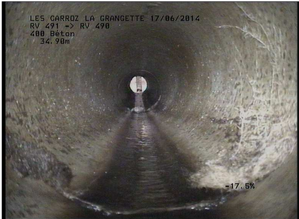
Photo: 10_20A, MPEG #: 160614_1, 00:08:56 35,09m, Racines et radicelles de 04 à 08 h.
