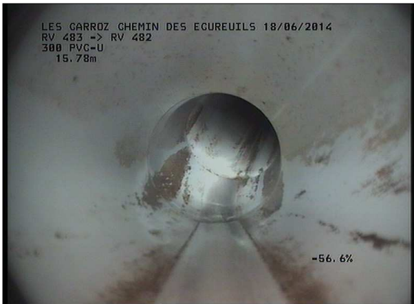
Photo: 24_4A, MPEG #: 160614_1, 00:01:40 15,78m, Coude pour retour horizontal
