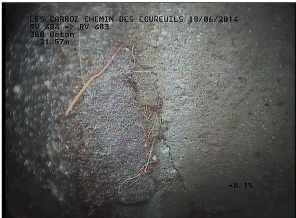
Photo: 23_5B, MPEG #: 160614_1, 00:02:47 21,57m, Racines et radicelles de 06 à 12 h.
