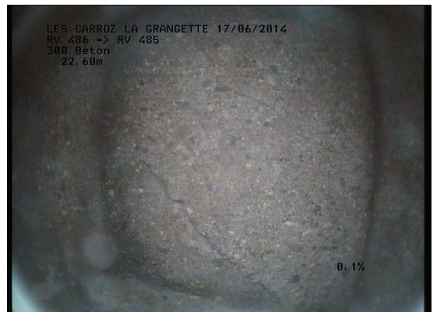
Photo: 16_5B, MPEG #: 160614_1, 00:02:26 22,6m, Passage dans regard borgne
