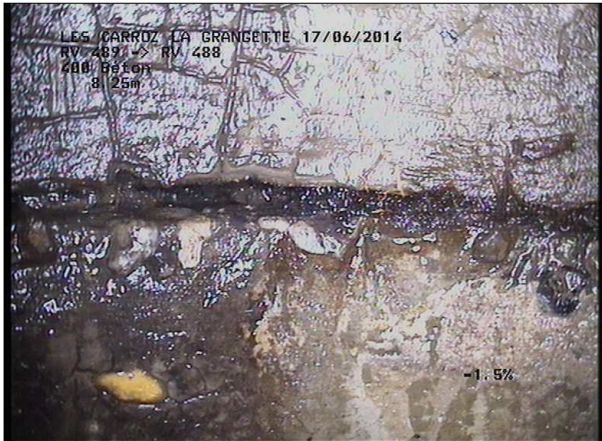
Photo: 12_5B, MPEG #: 160614_1, 00:01:58 8,25m, Radicelles à 05 h.
