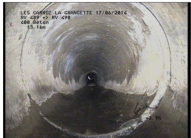
Photo: 11_5A, MPEG #: 160614_1, 00:02:20 13,58m, Racines et radicelles à 05 h.
