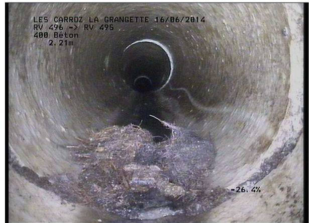
Photo: 5_2A, MPEG #: 160614_1, 00:00:17 2,49m, Racines et radicules de 05 à 07 h.
