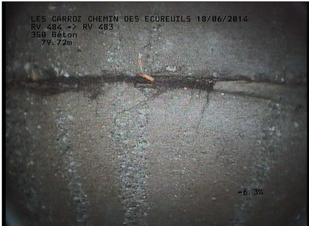
Photo: 23_19B, MPEG #: 160614_1, 00:13:02 79,72m, Radicelles à 11 h.
