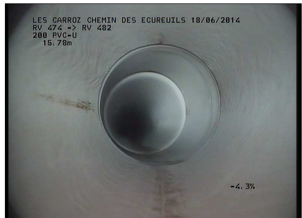
Photo: 25_4A, MPEG #: 160614_1, 00:02:11 16,07m, Coude à gauche
