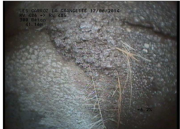
Photo: 16_13B, MPEG #: 160614_1, 00:06:14 41,16m, Racines et radicelles de 04 à 05 h.
