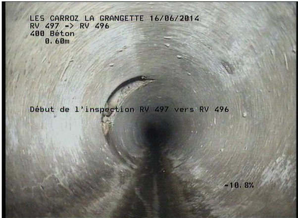
Photo: 4_1A, MPEG #: 160614_1, 00:00:00 0,6m, Début de l'inspection RV 497 vers RV 496
