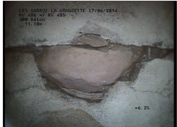
Photo: 16_4B, MPEG #: 160614_1, 00:01:19 11,1m, Eclatement à 12 h rebouché avec cailloux
