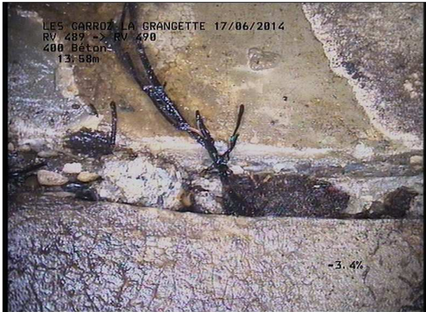
Photo: 11_5B, MPEG #: 160614_1, 00:02:20 13,58m, Racines et radicelles à 05 h.
