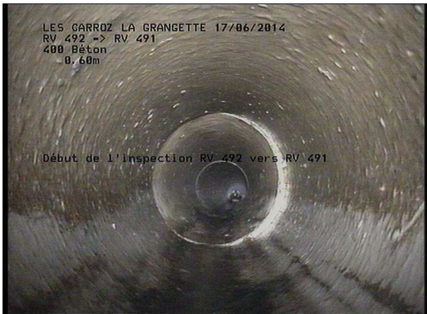
Photo: 9_1A, MPEG #: 160614_1, 00:00:00 0,6m, Début de l'inspection RV 492 vers RV 491
