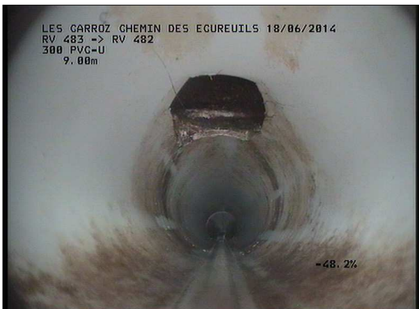
Photo: 24_3A, MPEG #: 160614_1, 00:00:45 9,25m, Passage dans regard section carrée
