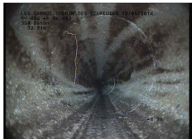
Photo: 23_7A, MPEG #: 160614_1, 00:04:13 33,24m, Radicelles à 11 h.
