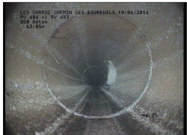
Photo: 23_13A, MPEG #: 160614_1, 00:09:23 62,33m, Radicelles à 10 h.
