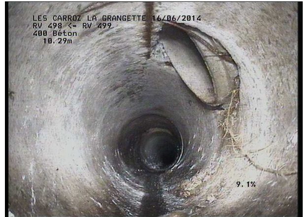
Photo: 2_8A, MPEG #: 160614_1, 00:02:45 10,88m, Racines et radicelles de 12 à 03 h.
