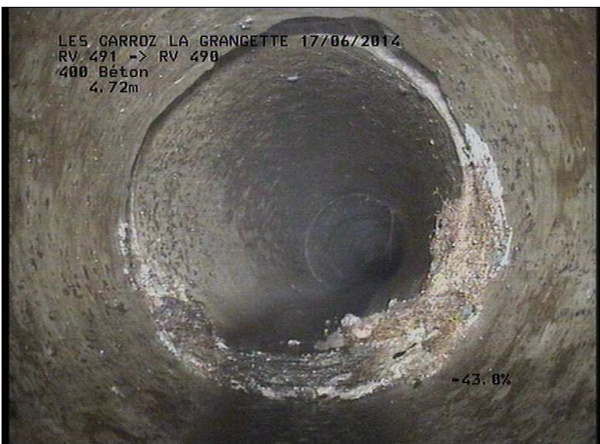
Photo: 10_5A, MPEG #: 160614_1, 00:01:46 5,23m, Dépôt de concrétions de 02 à 07 h plus racines
