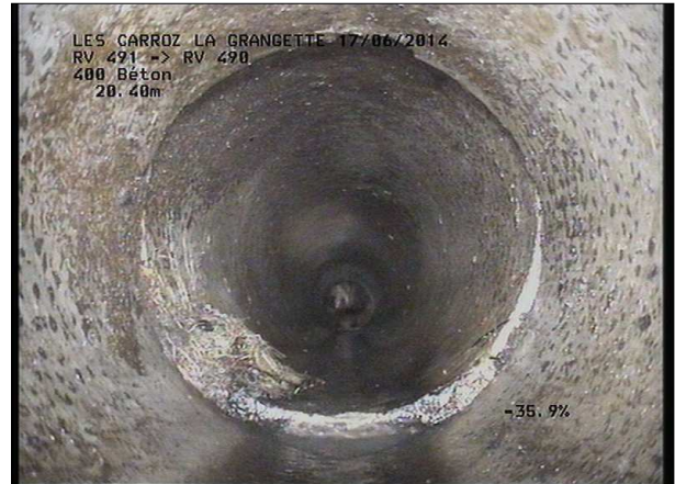
Photo: 10_15A, MPEG #: 160614_1, 00:06:23 20,94m, Racines et radicelles à 07 h.
