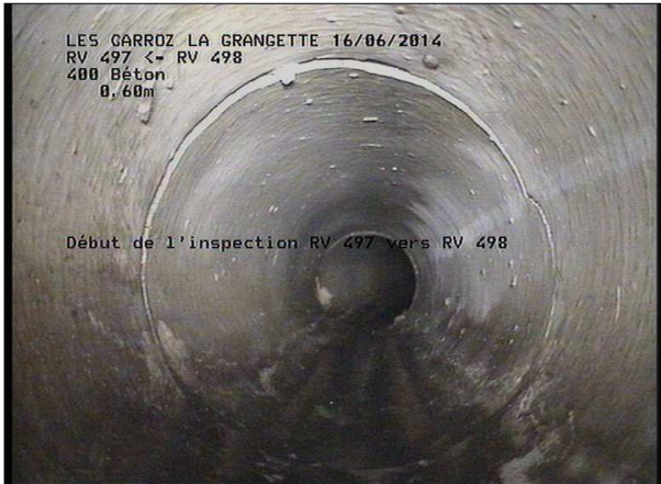
Photo: 1_1A, MPEG #: 160614_1, 00:00:00 0,6m, Début de l'inspection RV 497 vers RV 498
