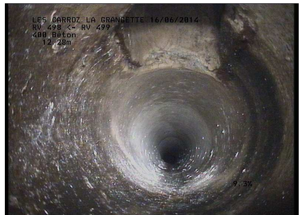
Photo: 2_9A, MPEG #: 160614_1, 00:03:58 12,72m, Raccordement direct à 12 h dans REGARD BORGNE
