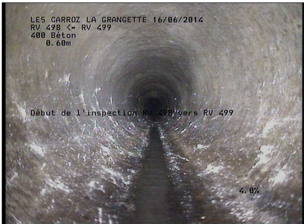
Photo: 2_1A, MPEG #: 160614_1, 00:00:00 0,6m, Début de l'inspection RV 498 vers RV 499
