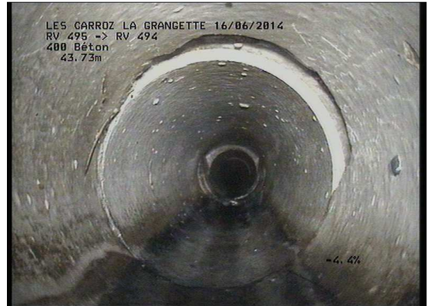
Photo: 6_12A, MPEG #: 160614_1, 00:07:51 44,32m, Epaufrure de 10 à 03 h.
