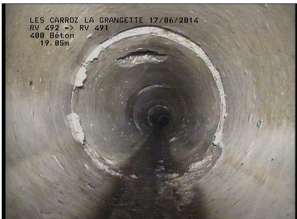
Photo: 9_7A, MPEG #: 160614_1, 00:03:06 19,65m, Dépôt de concrétions de 12 à 12 h.
