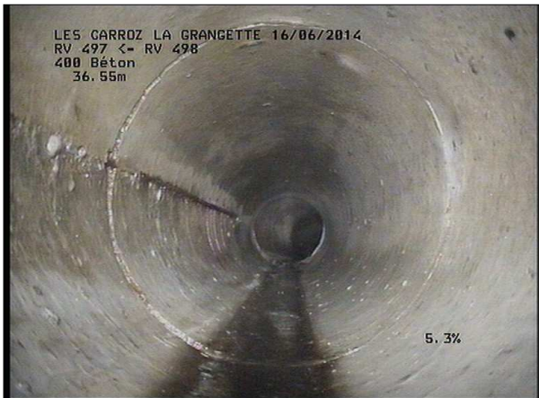
Photo: 1_15A, MPEG #: 160614_1, 00:08:38 37,73m, Armatures visibles à 09 h.
