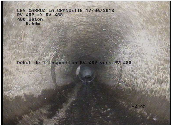
Photo: 12_1A, MPEG #: 160614_1, 00:00:00 0,6m, Début de l'inspection RV 489 vers RV 488
