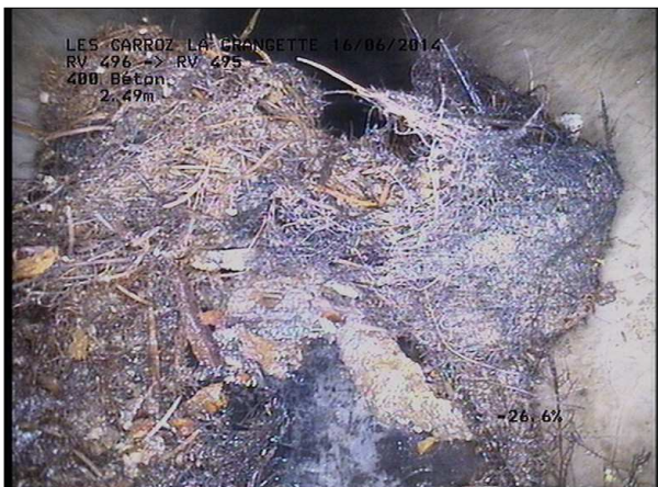
Photo: 5_2B, MPEG #: 160614_1, 00:00:17 2,49m, Racines et radicules de 05 à 07 h.
