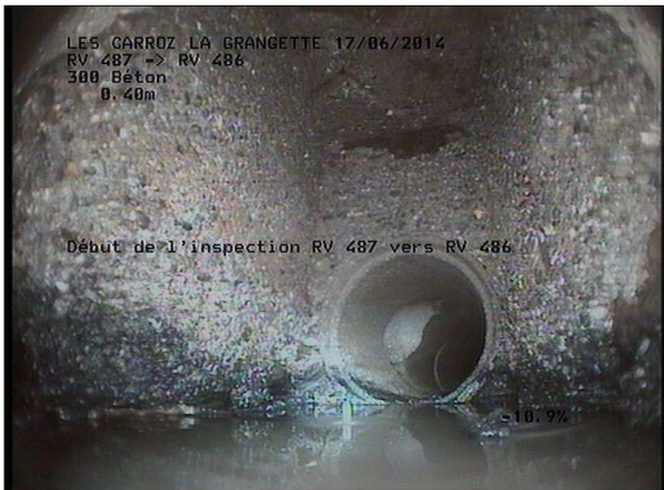
Photo: 14_1A, MPEG #: 160614_1, 00:00:00 0,4m, Début de l'inspection RV 487 vers RV 486
