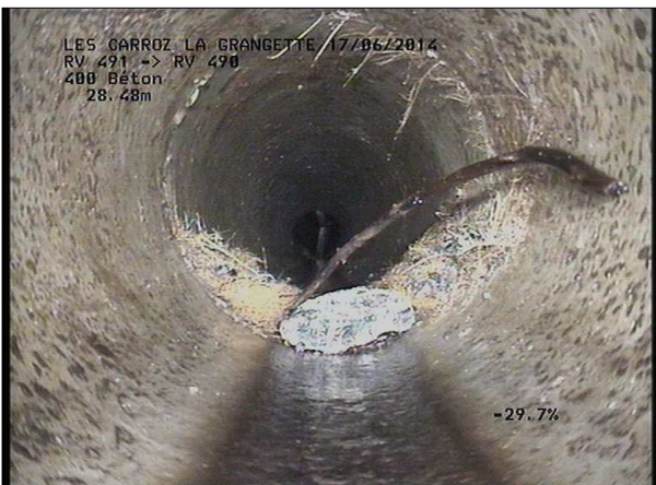
Photo: 10_18A, MPEG #: 160614_1, 00:07:57 29,25m, Racines et radicelles de 03 à 08 h.
