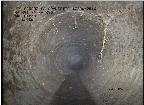
Photo: 10_6A, MPEG #: 160614_1, 00:02:16 6,34m, Racines et radicelles à 01 h.
