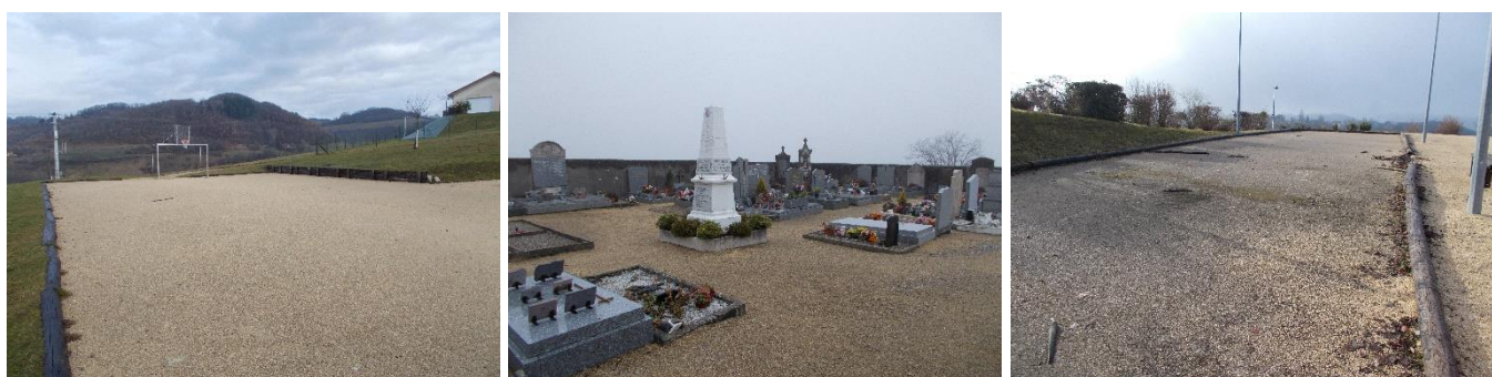
Figure 45 : Exemple de surfaces perméables de classe 1 : Le terrain multisport (à gauche), Le cimetière (au centre), le terrain de boules (à droite)
