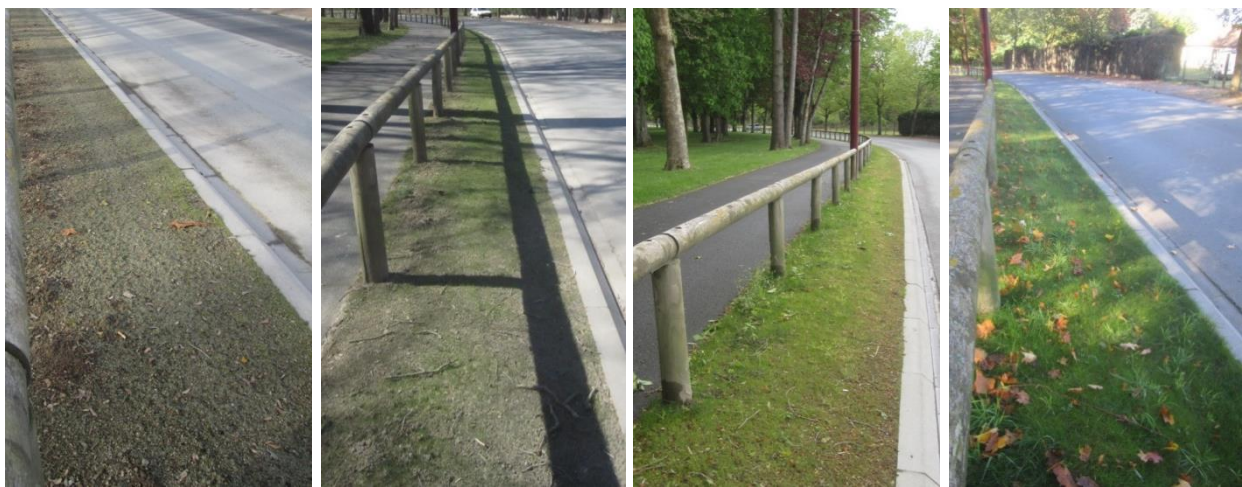
Figure 64 : Enherbement par hydroseeding sur la commune de Commentry (03), De gauche à droite : février 2017, mars 2017, mai 2017 et octobre 2017
