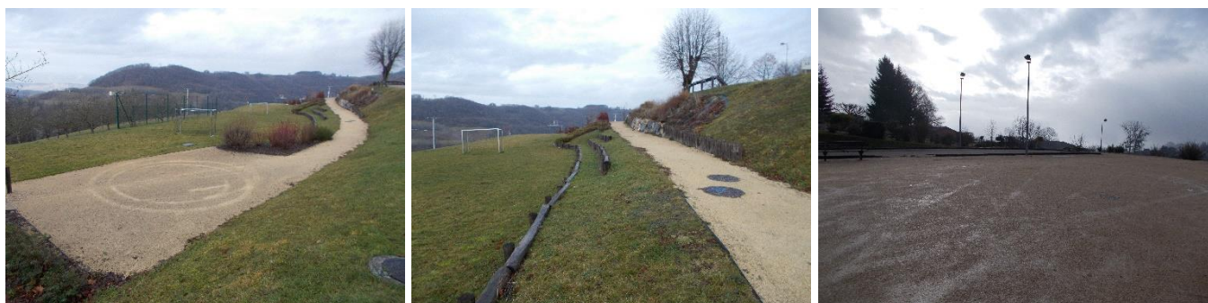
Figure 56 : Exemple de sites d'application du débroussaillage en classe 2 : Espace piéton en stabilisé à proximité des terrains multisports (à gauche), Parking du terrain de boule (à droite)
