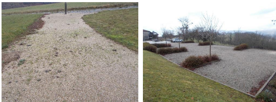
Figure 47 : Exemple de surfaces perméables de classe 3 : Cheminement piéton à proximité du terrain multisport (à gauche), Parking des terrains de sport (à droite)
