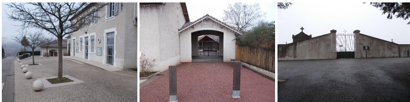
Figure 21 : Exemple de surfaces imperméables classées en code 1 : La mairie (à gauche), l'entrée de l'école (au centre), l'entrée du cimetière (à droite)
