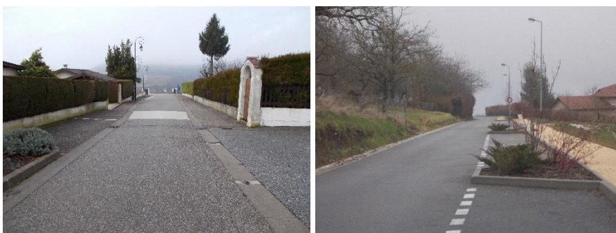
Figure 33 : Exemple de sites d’application du micro-balayage en classe 2 : route de Vinay (à gauche), D201 (à droite)
