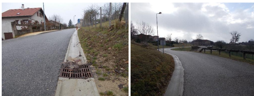
Figure 22 : Exemple de surfaces imperméables classées en code 2 : Route D201 (à gauche), Route de Vinay (à droite)
