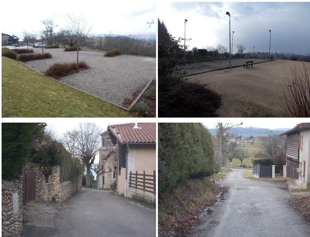
Figure 18 : Exemple de sites classés en code 3 : Parking en gravier du stade (en haut à gauche), Parking en stabilisé du jeu de boule (en haut à droite), chemin Piambert (en bas à gauche), Le Petit Chemin (en bas à droite)
