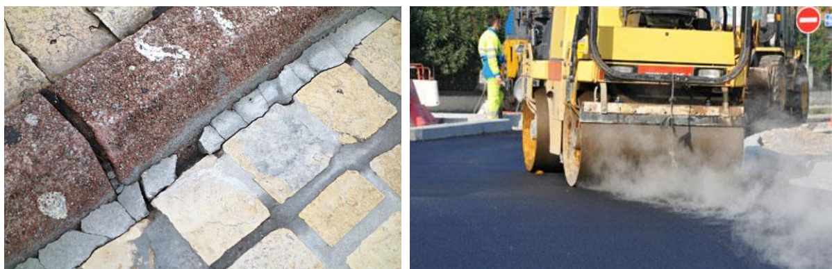
Figure 79 : Illustration d'une réfection de voirie
