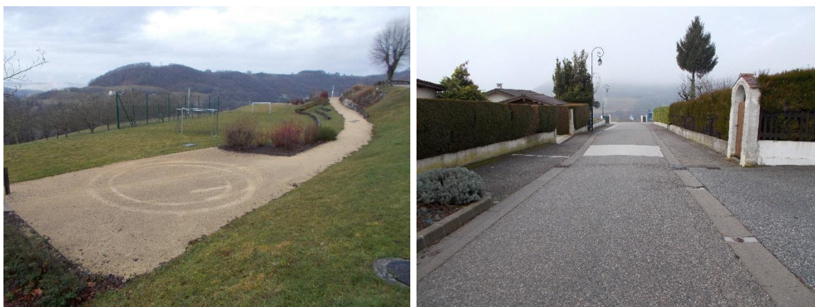
Figure 17 : Exemple de sites classés en code 2 : Plkacette à proximité du stade enherbé (en bas à gauche), la D201 (en bas à droite)
