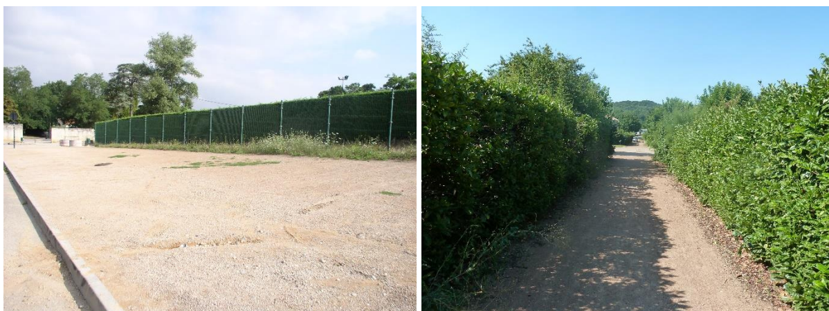
Figure 65 : Exemple de surfaces perméables difficiles à entretenir sur une autre commune
