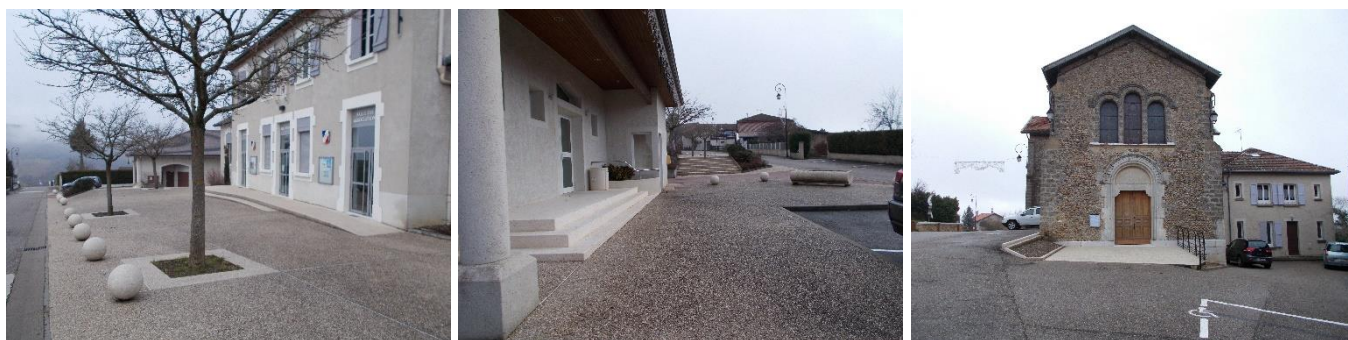
Figure 32 : Exemple de sites d’application du micro-balayage en classe 1 : Parvis de la mairie (à gauche), Parvis de salle des fêtes (au centre), Parvis de l’église (à droite)
