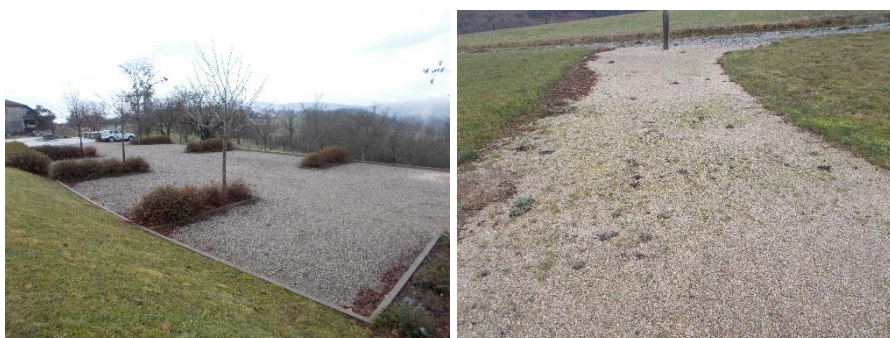
Figure 53 : Exemple de sites d'application du combiné mécanique en classe 3 : Cheminement piéton à proximité du terrain multisport (à droite), Parking des terrains de sport (à gauche).
