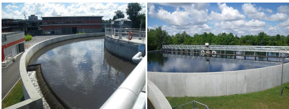
Figure 6 : Vues de la STEP de Bourgoin-Jallieu
