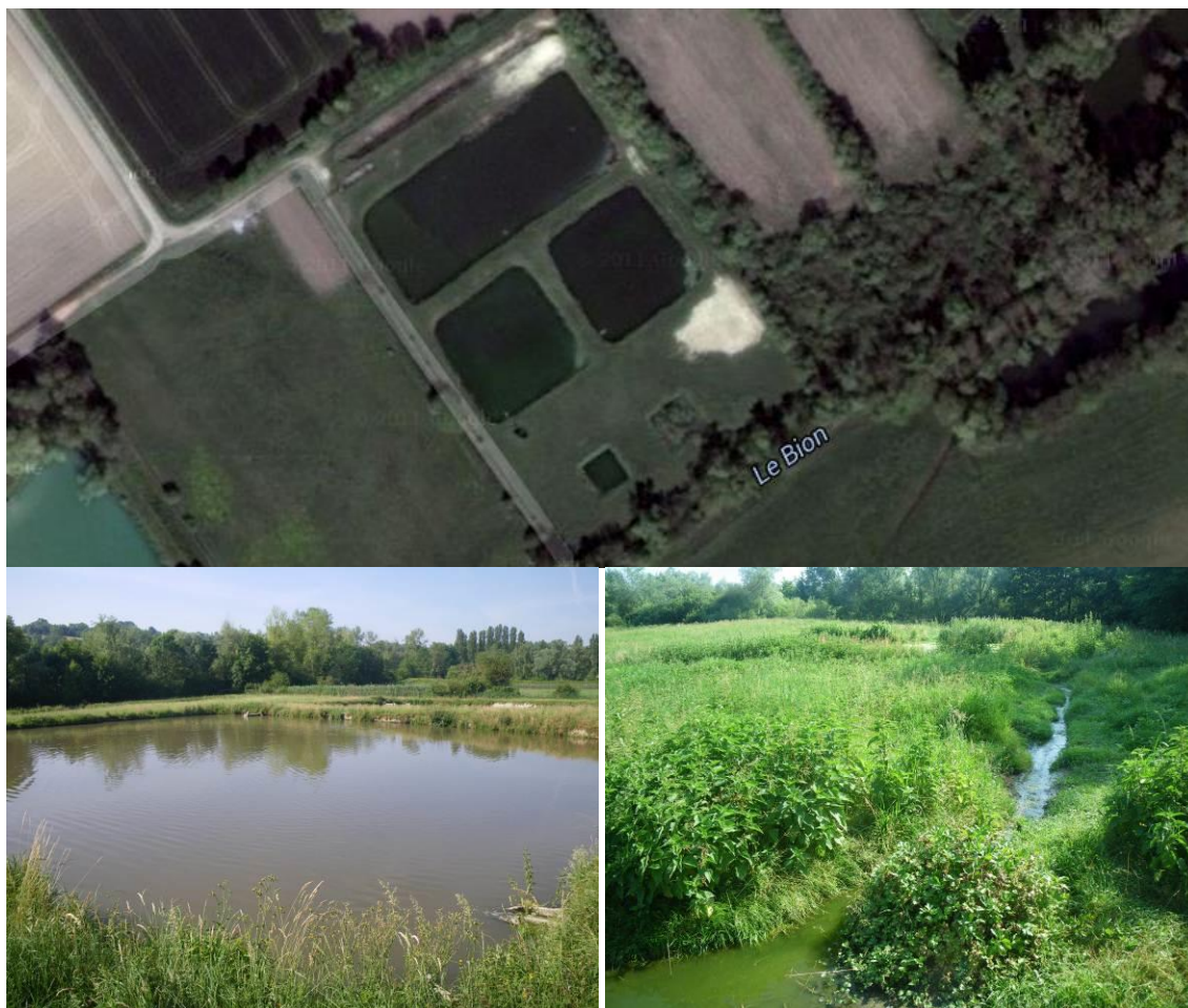
Figure 9 : Vues de la STEP de Crachier
