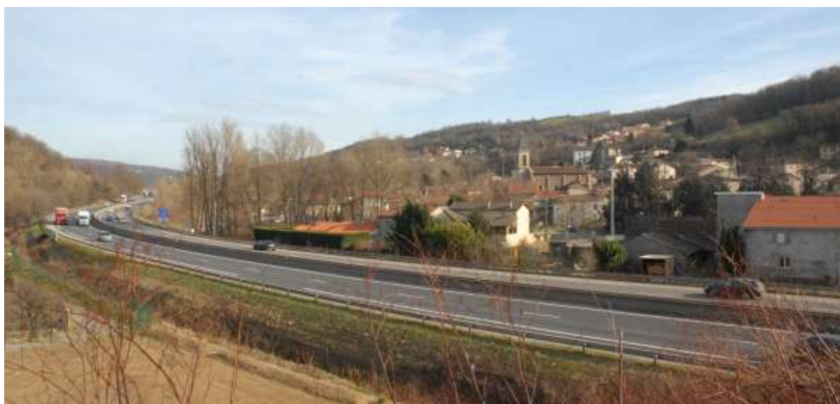
Fig. 22. Vue sur la vallée longée par l'A47 depuis le pont, proche de l'intersection des routes RD488 et RD103E.
