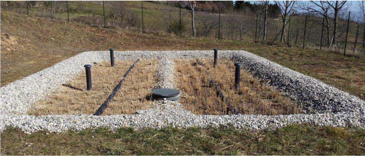
Photo 16 : Filtres du deuxième étage
