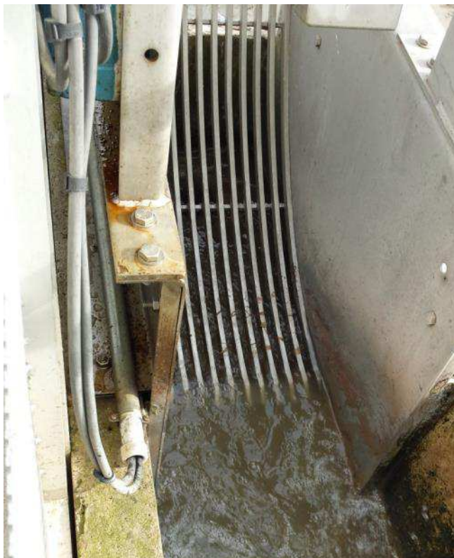
Photo 20 : Dégrilleur mécanique
