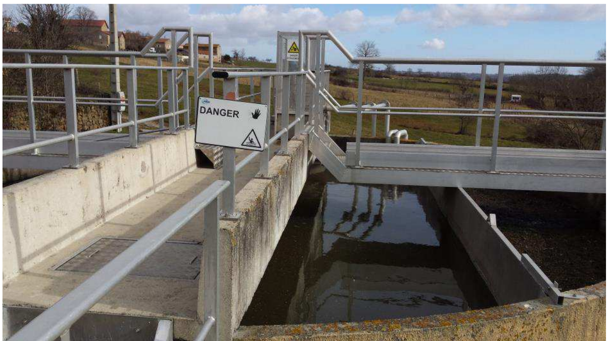
Photo 24 : Décanteur digesteur
