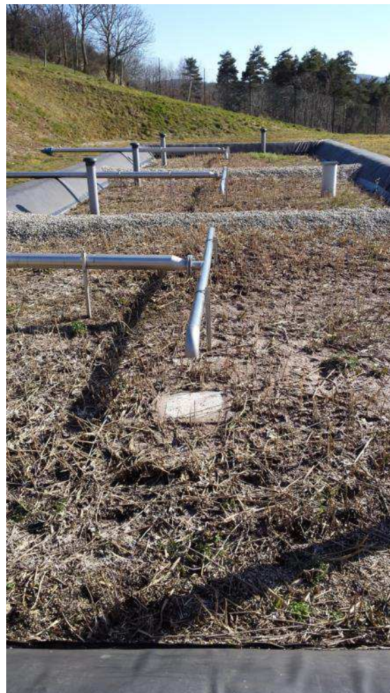
Photo 10 : Premier étage avec 3 filtres
