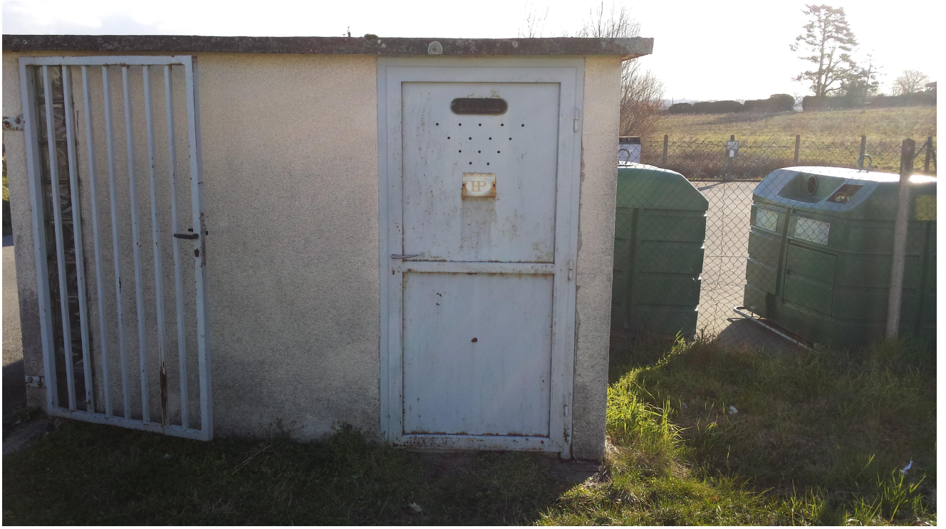
Photo n°4 : Vue extérieure du local du Pontet
