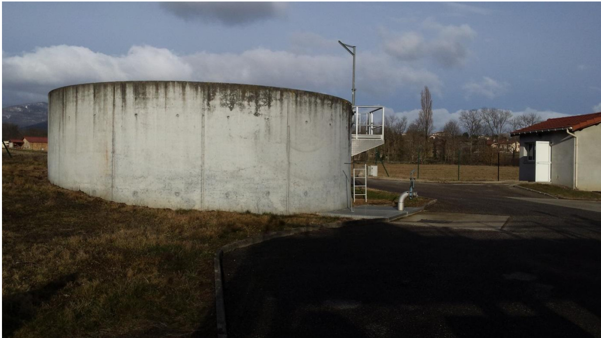
Photo n°11 : Silo à boues
