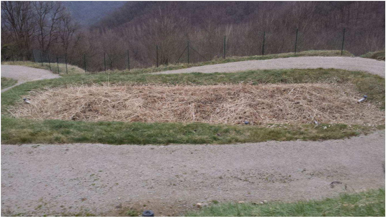
Photo n°8 : Deuxième étage de filtre planté de roseaux
