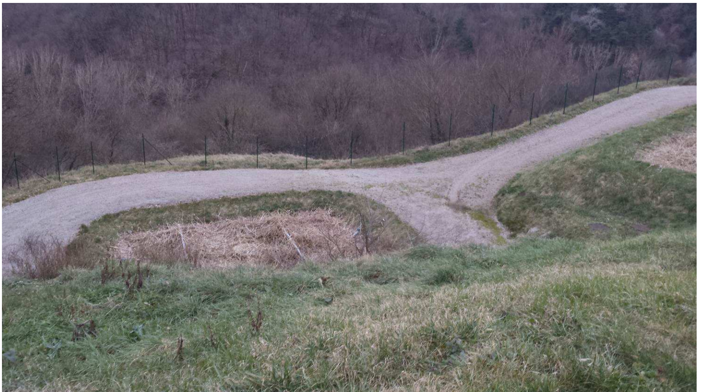
Photo n°8 : Deuxième étage de filtre planté de roseaux
