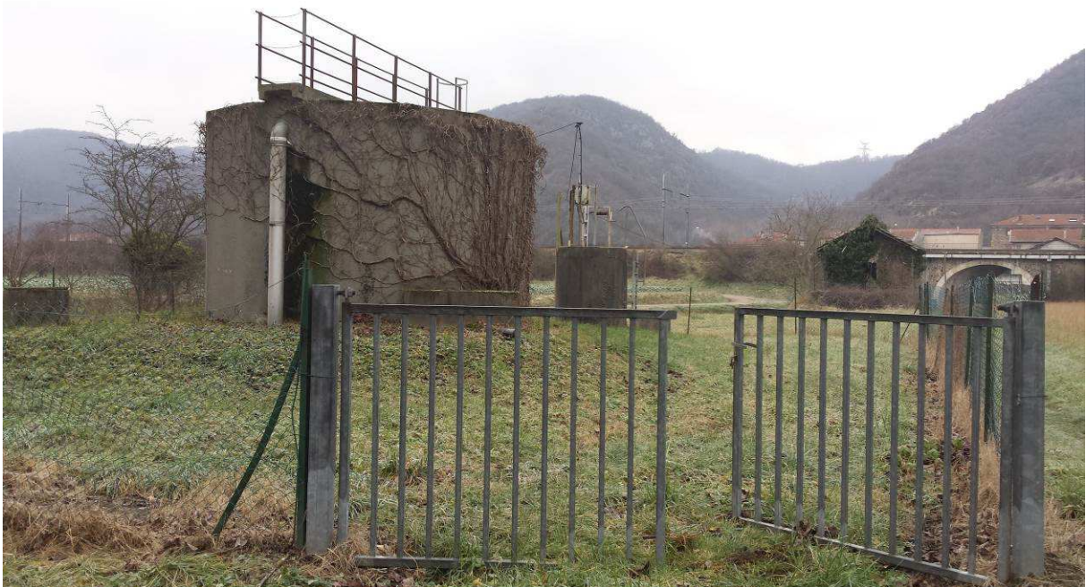
Photo n°2 : Vue générale de la station – Décanteur digesteur et poste de relevage au deuxième plan
