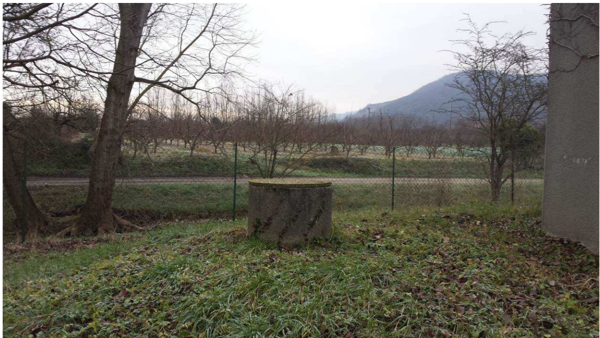
Photo n°4 : Regard de sortie avant rejet au milieu naturel
