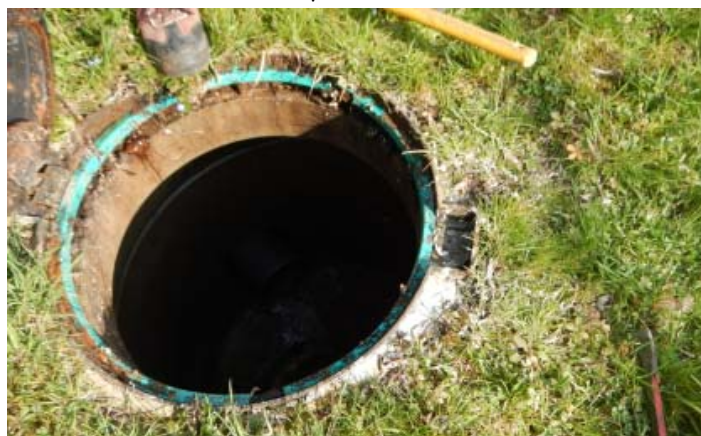
Figure 26 : Traces de débordement au niveau des points 12 et 51
