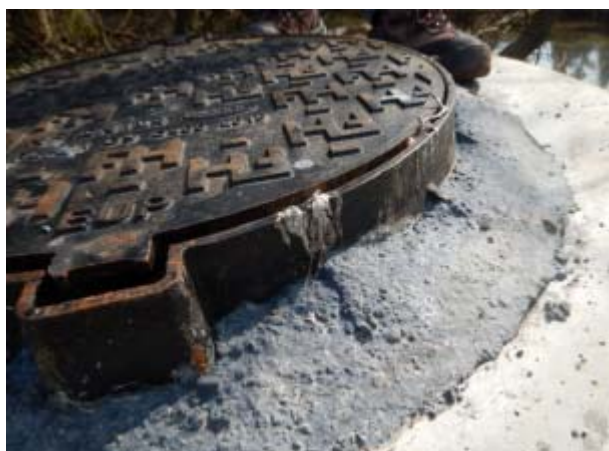
Figure 27 : Traces de débordement au niveau du regard de la parcelle AD30
