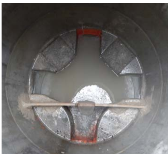
Figure 12 : Exemple de seuil de mesure, point 20 le 01/04/2015
