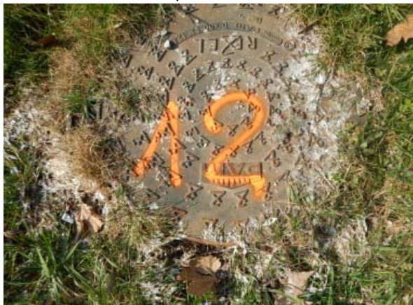
Figure 26 : Traces de débordement au niveau des points 12 et 51
