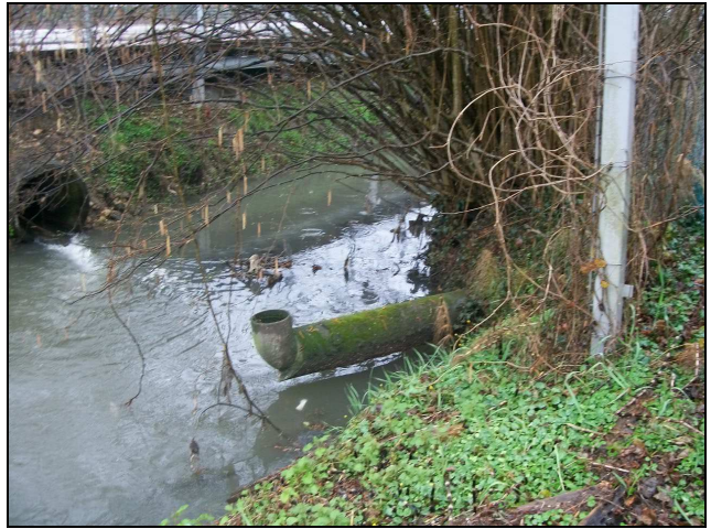
Exutoire du DO Anémone 2
