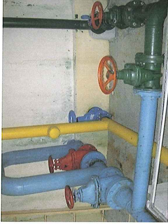
Réservoir de l'Agnelas - Voiron
