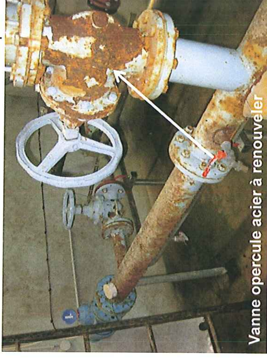
Réservoir du Grand Vivier – Saint Aupre
