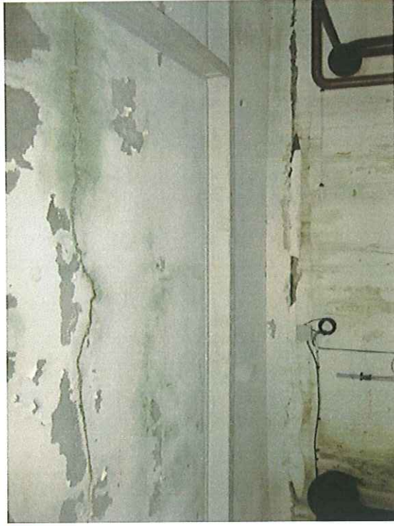
Réservoir de Gachetière - Voreppe
