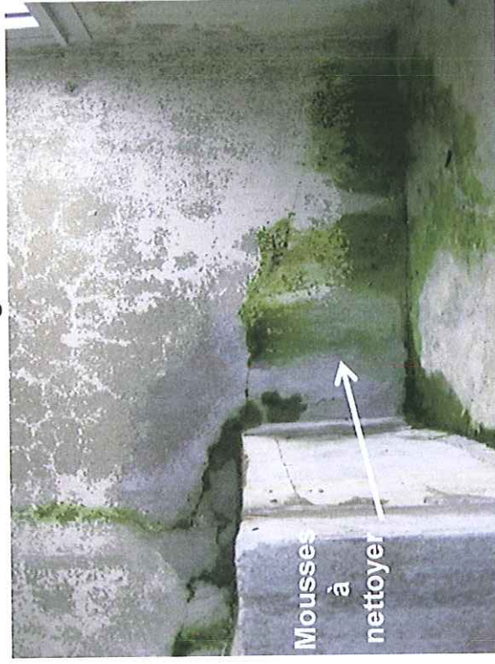
Réservoir de l'Agnelas – Voiron
