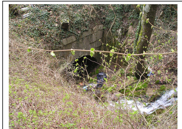
Photo : Vue d'aval
