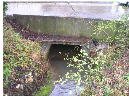
Photo : Vue d'amont
