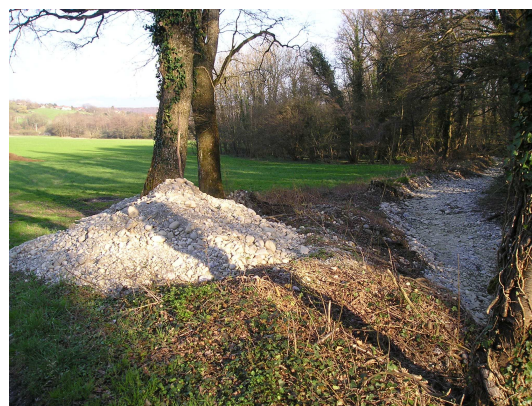
Photo : Curage dans le lit du Grand Echaud
