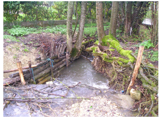
Photo : Berges à l'amont de l'ouvrage
