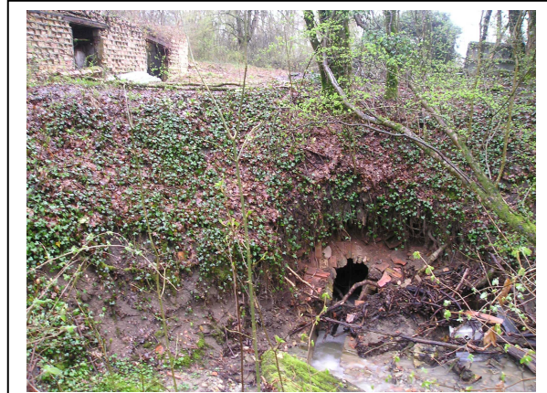
Photo : Vue d'amont
