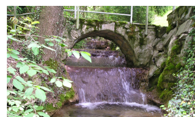
Photo : Trois ouvrages de l'aval vers l'amont
