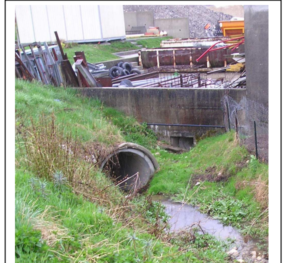
Photo : Vue d'amont
