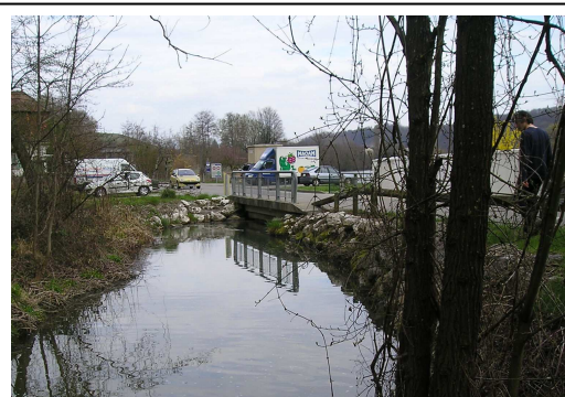
Photo : Ouvrage CH17 vu d'amont
