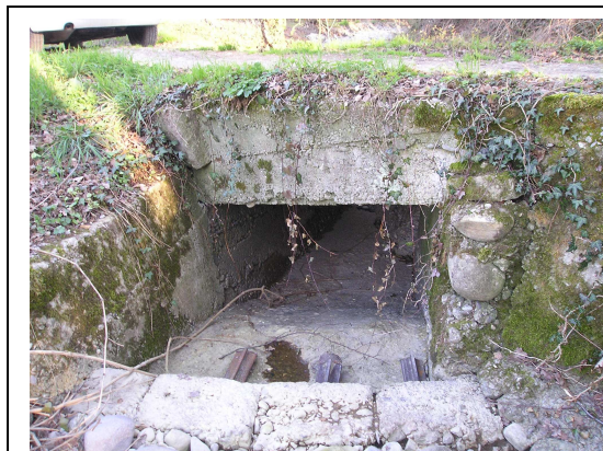
Photo : Ouvrage CO16 vu d'amont
