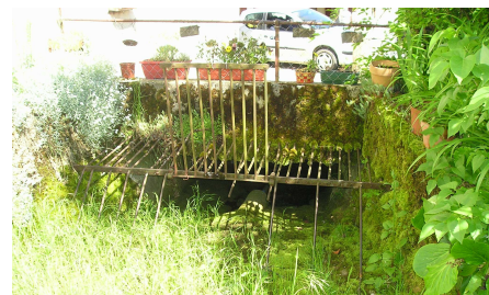
Photo : Ouvrage Fa20 vu d'amont
