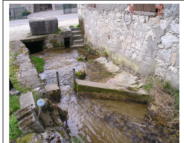
Photo : Vue d'amont
