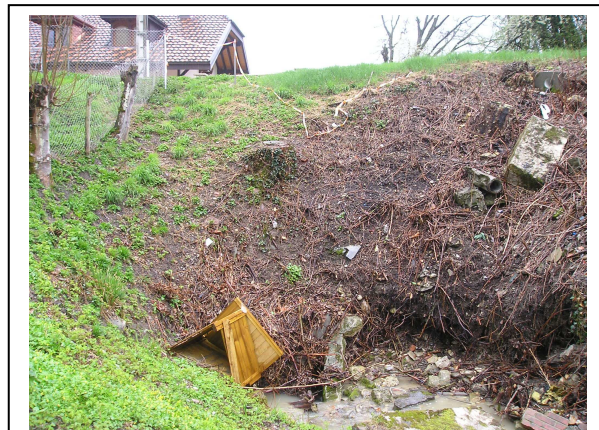
Photo : Vue d'amont
