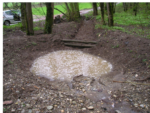
Photo : Bassin en amont de Pou3
