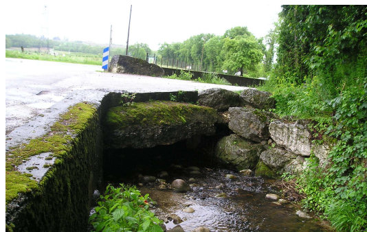
Photo : Vue d'amont
