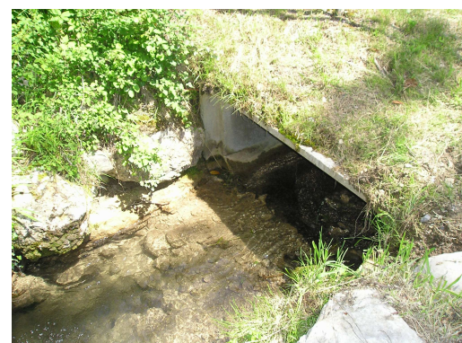
Photo : Ouvrage Fa4 vu d'amont
