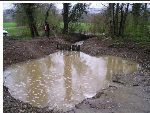
Photo : Bassin en amont de Pou2
