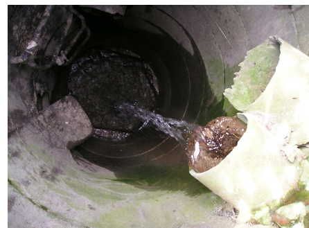
Photo : Sortie des buses dans le puits
