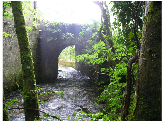
Photo : Vue d'aval
