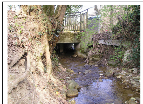
Photo : Ouvrage CH08 vu d'amont
