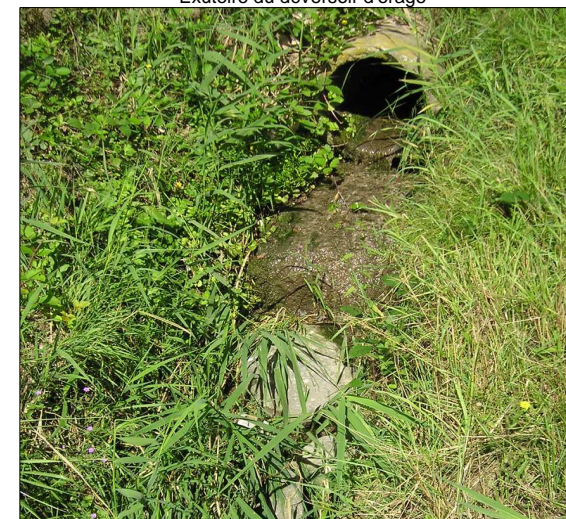
Exutoire du déversoir d'orage
