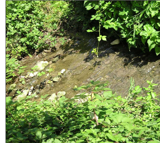
Aval rejet STEP - déversoir d'orage
