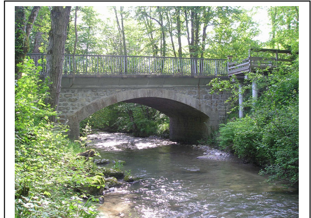
Photo : Vue d'amont
