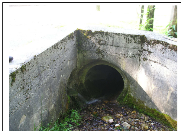
Photo : Vue d'amont
