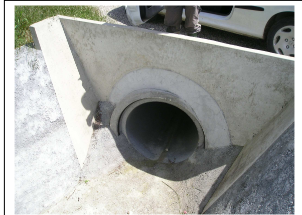
Photo : Vue d'aval
