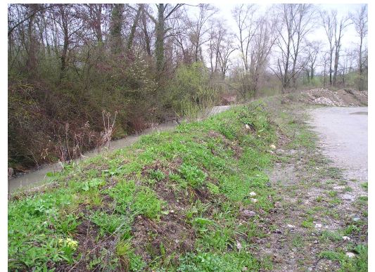
Photo : Digue de protection de la gravière
