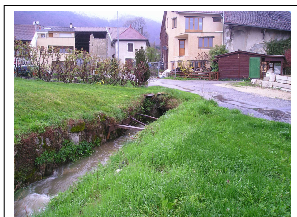
Photo : Vue d'aval
