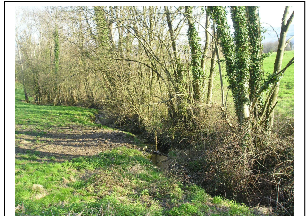
Photo : Ruisseau du Chatelet en aval de l'ouvrage CO8
