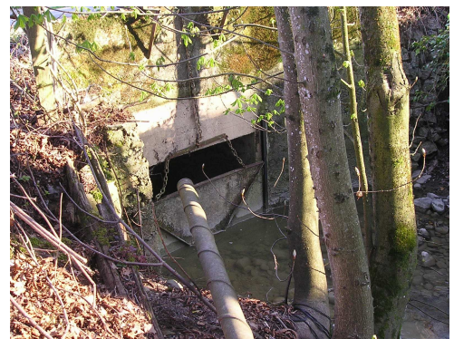
Photo : Ouvrage CO12 vu d'amont
