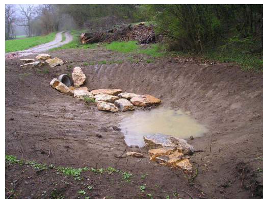
Photo : Bassin en amont de Pou4
