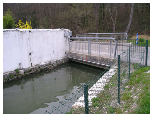
Photo : Ouvrage CH17 vu d'aval
