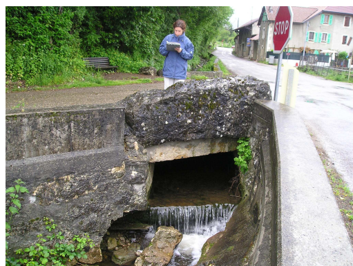
Photo : Vue d'aval
