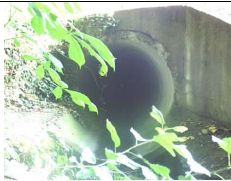
Photo, point :6 Coordonnée GPS : 46.25993 6.11 Type : tuyau Nature : béton Dimension : \phi 1000 Localisation : Ouye Remarque : passe sous la route du jura .Vue amont
