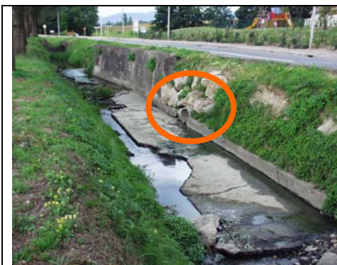
Photo, point : 49 Coordonnée GPS : 46.25102 6.10318 Type : bétonnage du lit du Nant
