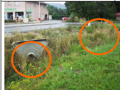
Photo, point : 66 Coordonnée GPS : 46.24646 6.08184 Type : collecteur principale Nature : béton Localisation : sortie avale Remarque : encombrement par la végétation
