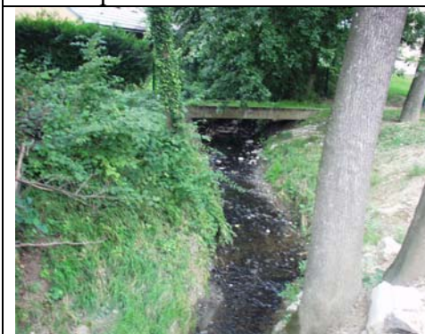
Photo, point : 53 Coordonnée GPS : 46.25141 6.10015 Type : ponton pour traversée piétonne du Nant.
