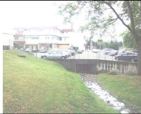
Point : 11 Coordonnées GPS : 46.25832 6.11096 Type : ouvrage souterrain +grille Nature : béton + acier Localisation : l'ouye Remarque : L'ouvrage passe sous le parking du centre de Ferney et ressort cf. point 9
