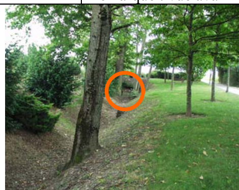
Photo, point : 52 Coordonnée GPS : 46.24958 6.10073 Type : fossé, Remarque : draine les eaux du point bas au sud et rejoint le Nant en passant sous la route
