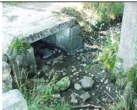
Photo, point :34 Coordonnée GPS : 46.26626 6.11648 Type : traverse chemin agricole Nature : pierre Dimension : L= 1,50m ; H= 90 cm Localisation : juste en aval de la confluence entre le Gobé et Gobé2 Remarque : zone inondable (Voir Schéma)
