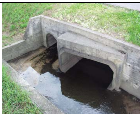
Photo, point : 50 Coordonnée GPS : 46.25066 6.10265 Type : ouvrage de traversée : 1 tuyau ; 1 canalisation rectangulaire ; Nature : béton Dimension : \phi 1000 ; L= 2m H=0.9m Remarque : vue aval
