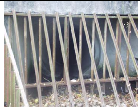
Point : 11 Coordonnées GPS : 46.25832 6.11096 Type : ouvrage souterrain +grille Nature : béton + acier Localisation : l'ouye Remarque : L'ouvrage passe sous le parking du centre de Ferney et ressort cf. point 9
