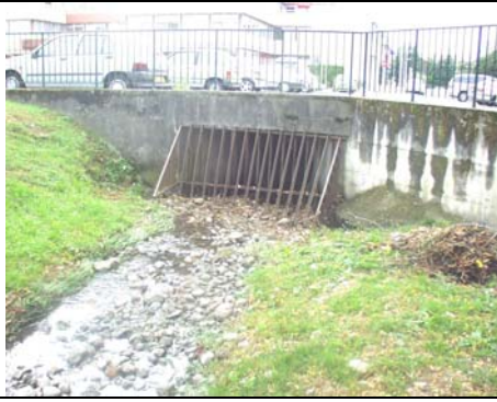
Photo, point :11 Coordonnée GPS : 46.25832 6.11096 Type : ouvrage de traversée (entrée avec grille) Dimension : \Phi 1200
