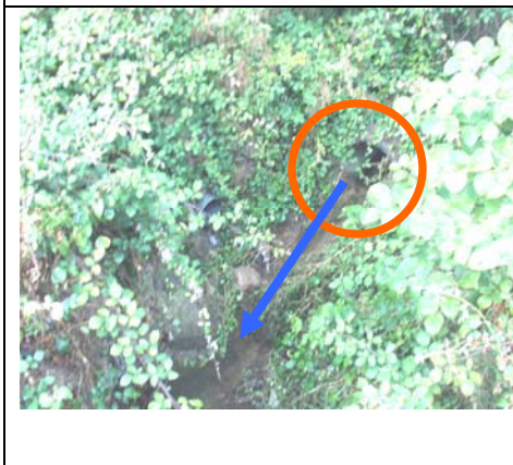
Photo, point : 66 Coordonnée GPS : 46.24646 6.08184 Type : collecteur principale Nature : béton Localisation : sortie avale Remarque : encombrement par la végétation
