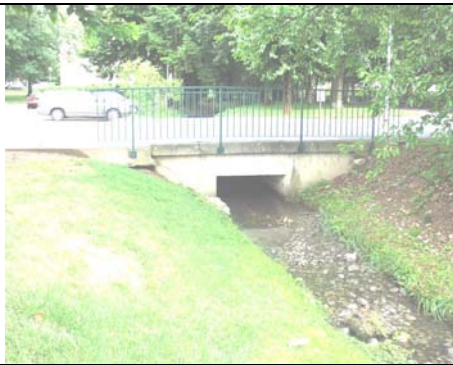
Photo, point :7 Coordonnée GPS : 46.25923 6.10989 Type : ouvrage de traversée Nature :béton Dimension : section hydraulique L=1.3m H=0.5m Localisation : ouye vue avale
