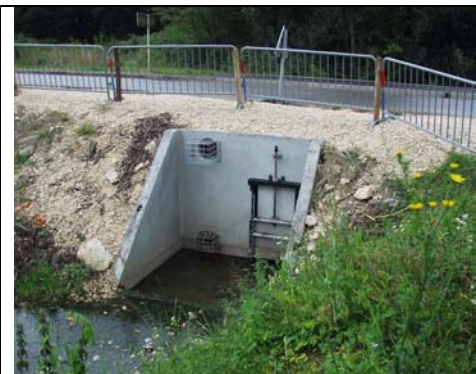
Photo, point : 62 b Coordonnée GPS : Type : ouvrage vanné Localisation : vue côté amont
