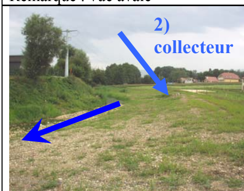
Photo, point : 62 c 1) Zone de rétention à l'amont de l'ouvrage vanné 2
