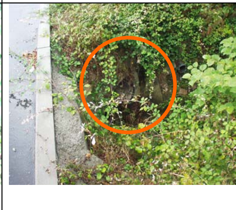
Photo, point : 66 Type : traversée sous la route qui mène à Netto (autour rond point) Nature : béton Dimension : \phi 700 Localisation : vue côté amont Remarque : encombrement par la végétation
