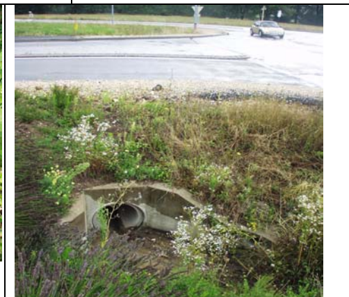
Photo, point : 67 Coordonnée GPS : 46.24633 6.0817 Type : traversée route Nature : béton Dimension : \phi 500 Localisation : vue côté amont
