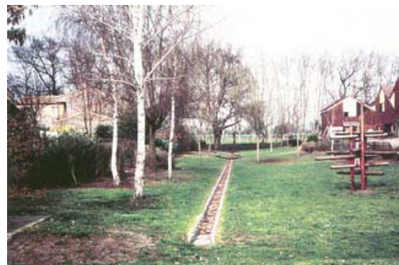
Photo 6 : Noue avec cunette de fond
