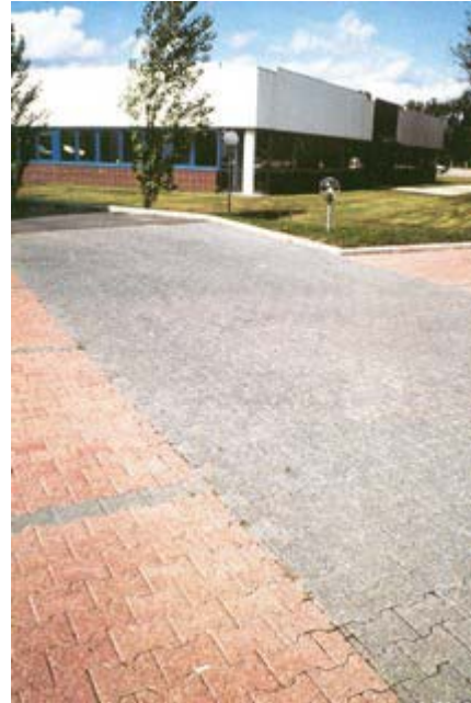
Photo 4 : parking réservoir à pavés drainants
