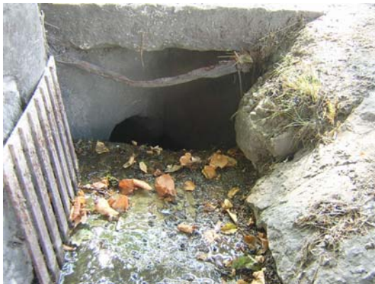
Photo 7 : entrée en conduite du fossé
