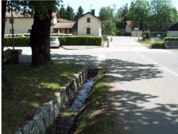
Photo 9 : entrée en conduite du fossé et zone de débordement
