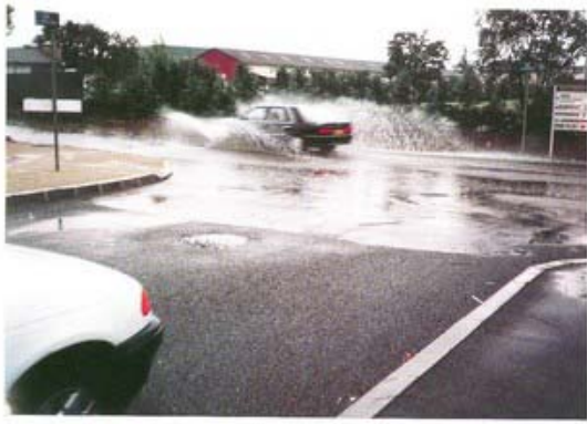
Photo 3 : Chaussée drainante (premier plan), non drainante (arrière plan)
