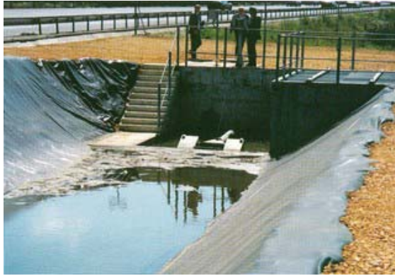
Photo 1 : bassin sec (autoroute) avec dispositif imperméabilisant
