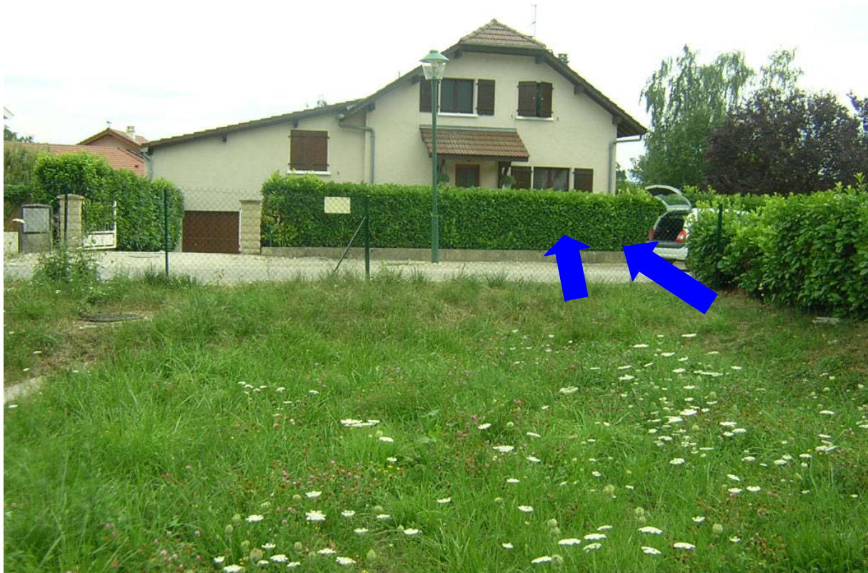
Photo 24 : débordements du bassin
