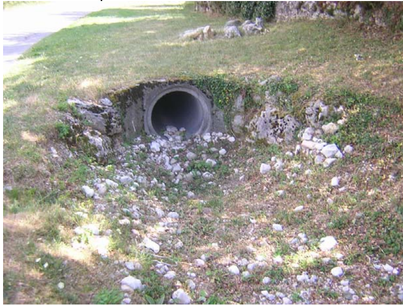
Photo 26 : entrée de buse engravée
