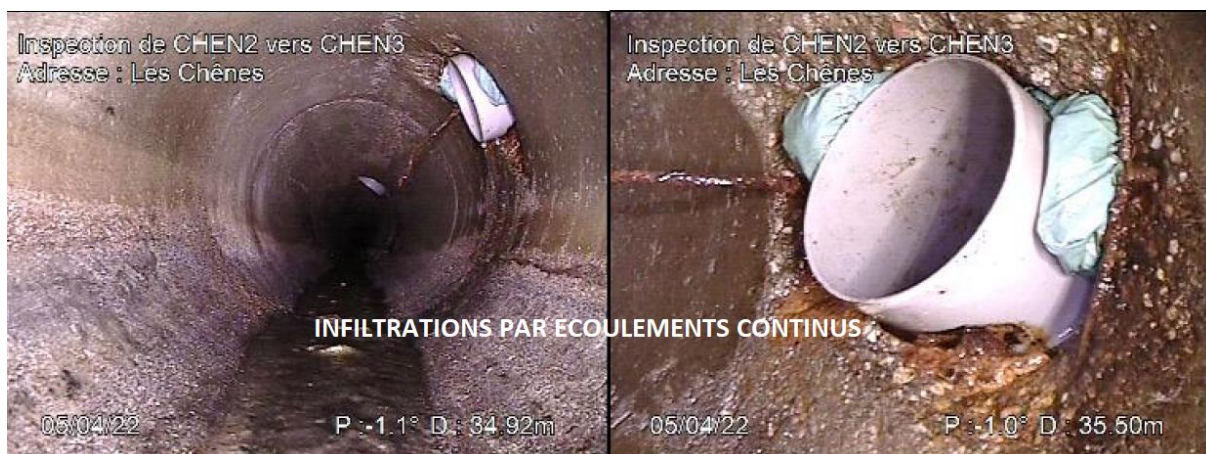
Fig. 71. Raccordements par piquage directs burinés
