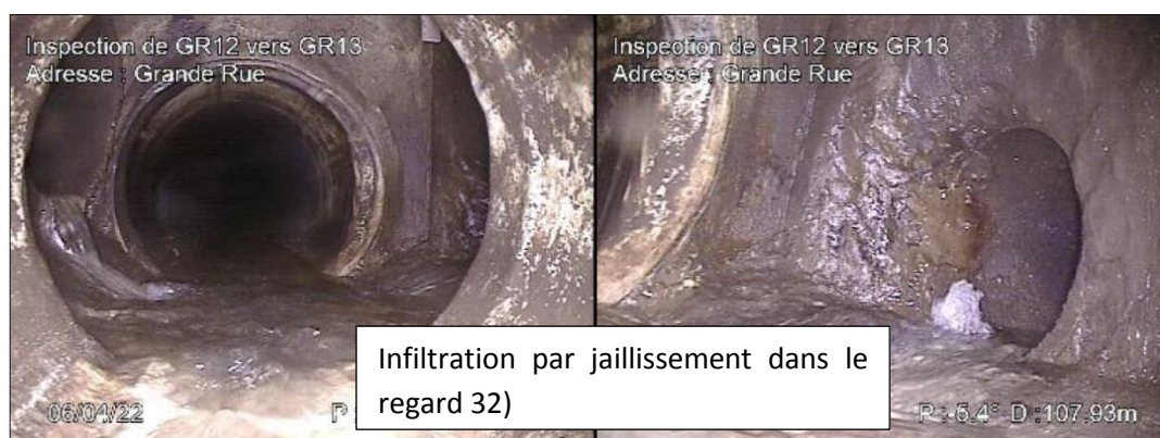
Fig. 75. Arrivée importante d'eaux claires
